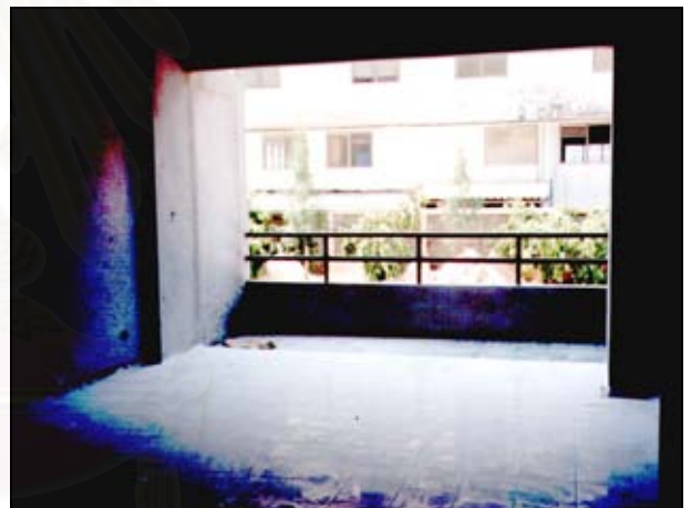
สภาพภายในห้องชุดอาคาร บี
