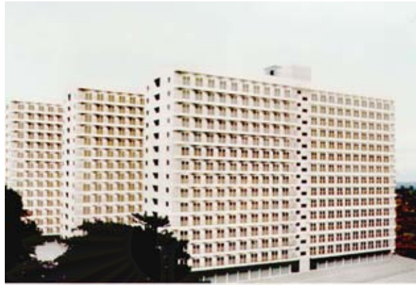
อาคาร ซี อาคาร บี อาคาร เอ
