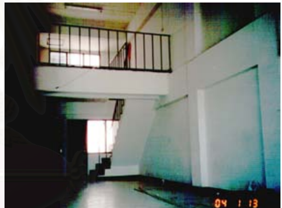
สภาพภายในห้องชุดพาณิชย์กรรม
