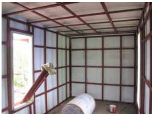
ภาพที่ 5.52 แสดงภาพโครงเหล็กยึดผนังภายในตู้คอนเทนเนอร์
