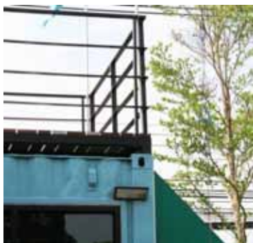
ภาพที่ 5.71 แสดงภาพการติดตั้งโครงสร้างระเบียงชั้น 2
