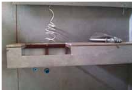
ภาพที่ 5.61 แสดงภาพการติดตั้งเคาท์เตอร์ห้องน้ำ
