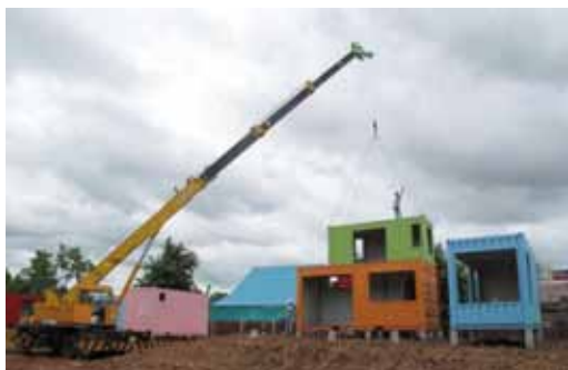
ภาพที่ 5.50 แสดงภาพการยกตู้คอนเทนเนอร์ 2
