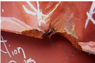
ภาพที่ 2.51 แสดงภาพความเสียหายส่วนล่างด้านข้างรางโครง 1
