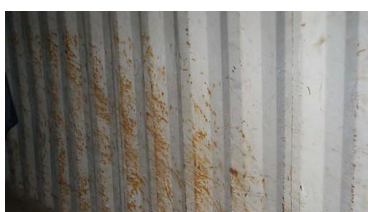
ภาพที่ 2.59 แสดงภาพรอยที่เกิดจากการขูดขีดของสินค้า
