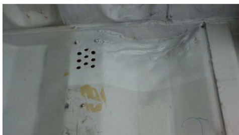
ภาพที่ 2.57 แสดงภาพรอยยี่ดบริเวณผนังตู้คอนเทนเนอร์
