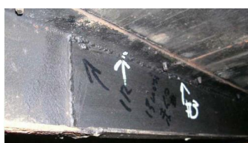
ภาพที่ 2.66 แสดงภาพการซ่อมแซมบริเวณ crossmember ที่ไม่เหมาะสม 1
