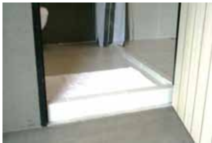
ภาพที่ 5.59 แสดงภาพจำลองถาดคอนกรีตห้องน้ำ
