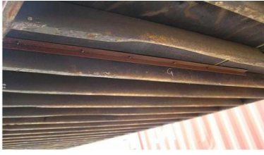
ภาพที่ 2.70 แสดงภาพ Bolt ยึดมุมบริเวณ crossmember
