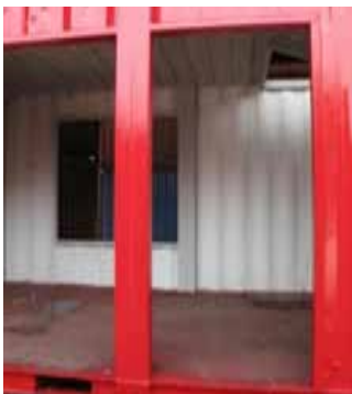
ภาพที่ 5.39 แสดงภาพช่องเปิดที่มีการตามโครงเหล็กแล้ว
