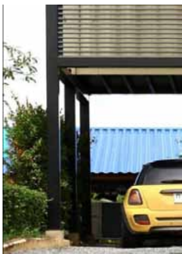
ภาพที่ 5.44 แสดงภาพเสาเหล็กที่ขึ้นไปรับตู้คอนเทนเนอร์ชั้น 2
