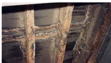
ภาพที่ 2.65 แสดงภาพร่องรอยการรั่วไหลของสารเคมี
