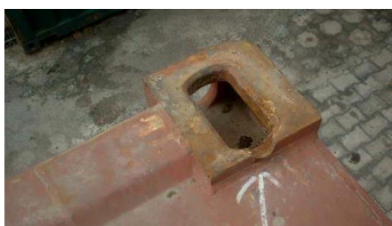
ภาพที่ 2.55 แสดงภาพความเสียหายบริเวณ corner casting
