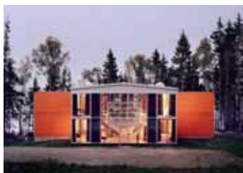
ภาพที่ 1.7 แสดงภาพอาคารบ้านพักในเมือง Brooklin, Maine, USA
