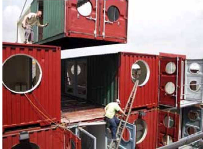
ภาพระหว่างการก่อสร้างอาคาร
