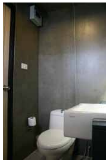
ภาพที่ 5.79 แสดงภาพตู้เบรกกเกอร์ ภายในห้องน้ำ
