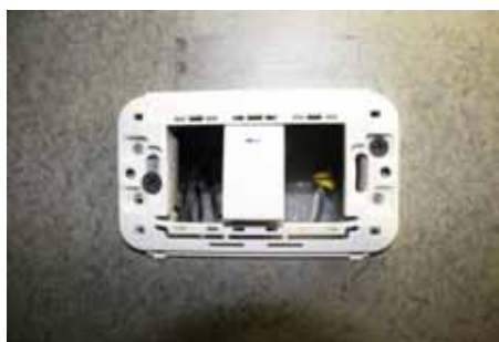
ภาพที่ 5.80 แสดงภาพสายไฟเดิน ภายในผนัง
