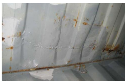
ภาพที่ 2.58 แสดงภาพบริเวณหลังคาซึ่งมีร่องรอยการเชื่อมที่ไม่ดี
