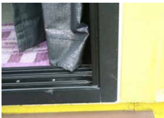
ภาพที่ 5.64 แสดงภาพรายละเอียดบริเวณรอยต่อวงกบประตูกับโครงเหล็ก
