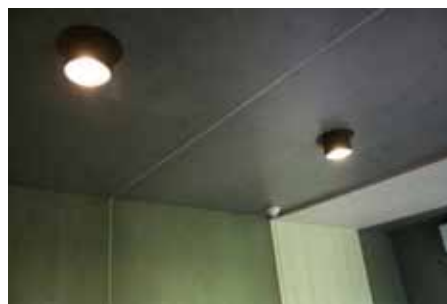
ภาพที่ 5.83 แสดงภาพการติดตั้ง ดวงโคมดาวไลท์ภายในห้องพักแขก
