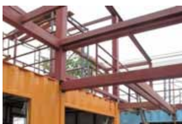
ภาพที่ 5.67 แสดงภาพระหว่างการก่อสร้างโครงสร้างหลังคา
