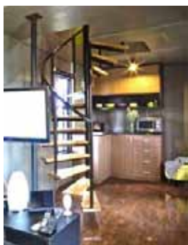
ภาพที่ 5.65 แสดงภาพบันไดวนภายในอาคาร
