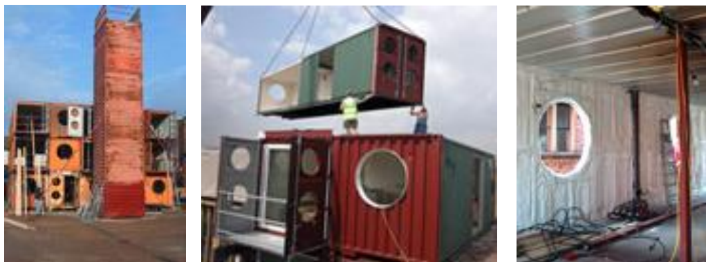
ภาพระหว่างการก่อสร้างอาคาร
