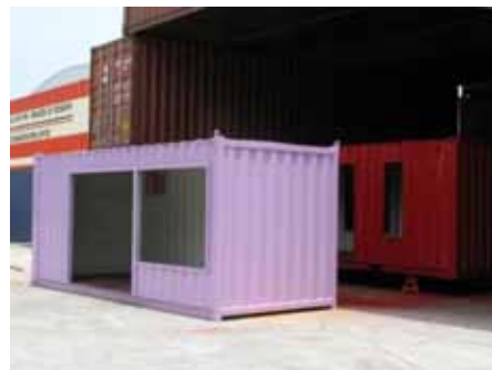
ภาพที่ 5.41 แสดงภาพตู้คอนเทน เนอร์ที่ทำการตัดแปลงจากโรงงาน เรียบร้อยแล้ว
