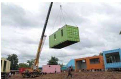
ภาพที่ 5.49 แสดงภาพการยกตู้คอนเทนเนอร์ 1
