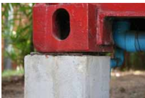
ภาพที่ 5.43 แสดงภาพเพลทเหล็กบริเวณหัวเสาตอม่อ
