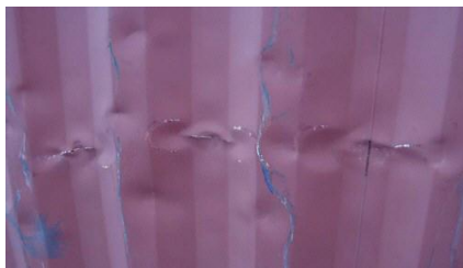
ภาพที่ 2.31 แสดงภาพผนังตู้คอนเทนเนอร์ที่มีความไม่เหมาะสมเกิดจากการยัดตัวของแผ่นเหล็ก
