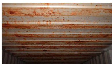
ภาพที่ 2.62 แสดงภาพร่องรอยการตกค้างของสารเคมี 2
