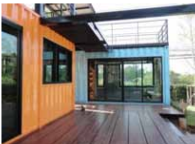
ภาพที่ 5.70 แสดงภาพพื้นไม้คอนกรีต
