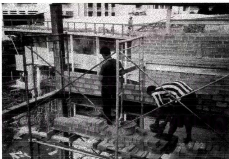
ภาพที่ 4-98 ปัญหาการขาดวัสดุอิฐมวลเบา จึงต้องใช้อิฐแดงชนิดกลวงทดแทน
