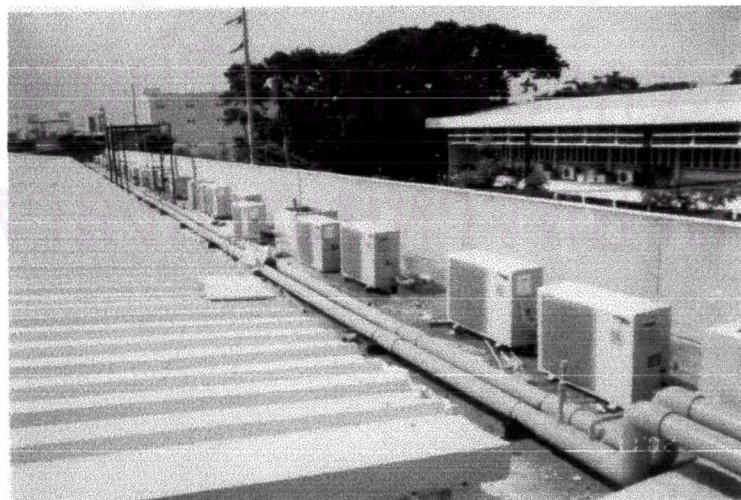
ภาพที่ 4-71 งานระบบปรับอากาศจะเป็นแบบแยกเป็นห้องๆ หรือที่เรียกว่าระบบ Split Type
