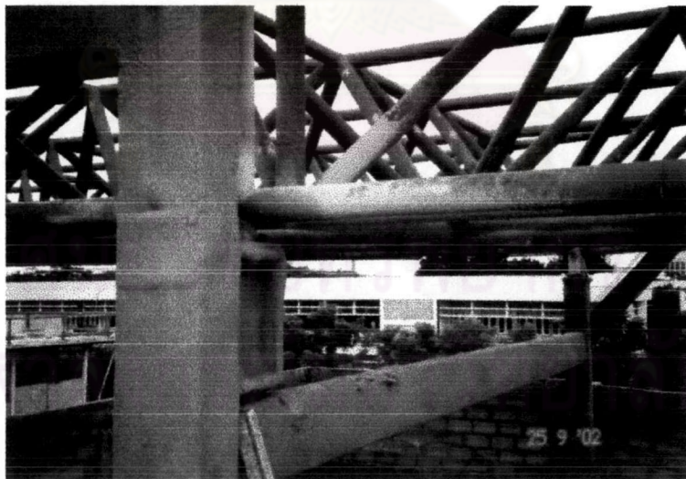
ภาพที่ 4-49 แสดงรอยต่อของ Space Frame เหล็กของโครงหลังคาโถงบันไดอาคาร Zone B
