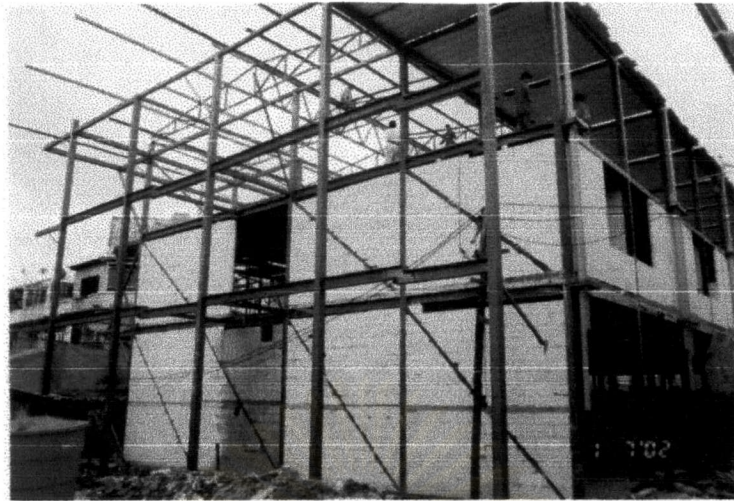
ภาพที่ 4-21 แสดง Bracing ระหว่างโครงสร้างเพื่อรับแรงด้านข้างที่กระทำกับอาคาร
