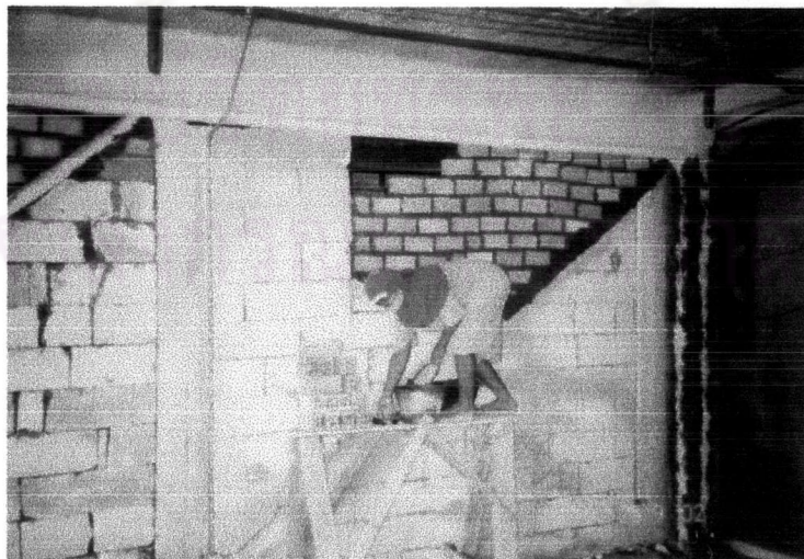
ภาพที่ 4-94 ปัญหาการก่อกำแพงอิฐในส่วน Bracing ทำได้ลำบาก และผนังบางส่วนมีการทรุดตัว
