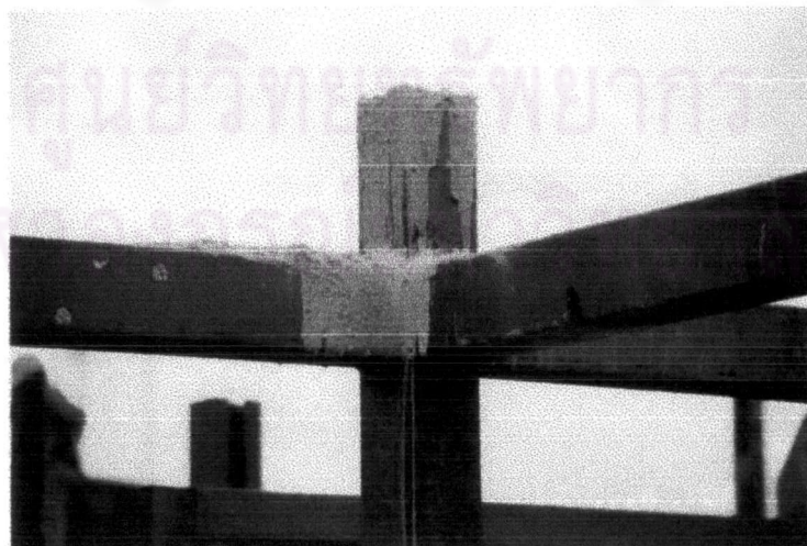
ภาพที่ 4-25 การเทคอนกรีตกรอกลงในเสาเหล็กรูปพรรณจากยอดบนสุด เพื่อความแข็งแรงของโครงสร้างอาคาร
