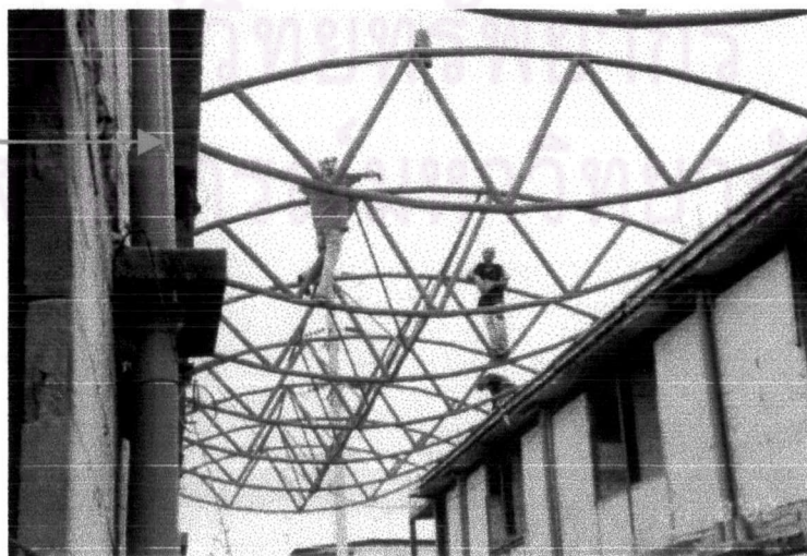
ภาพที่ 4-47 ภาพคนงานกำลังติดตั้งโครงถักเหล็กของหลังคาโค้งคลุมทางเดินระหว่างอาคาร
