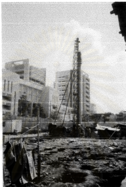
ภาพที่ 4-11 เสาเข็มคอนกรีตอัดแรงรูปตัวไอ ขนาด 0.30 \times 0.30 ยาว 12 เมตร
