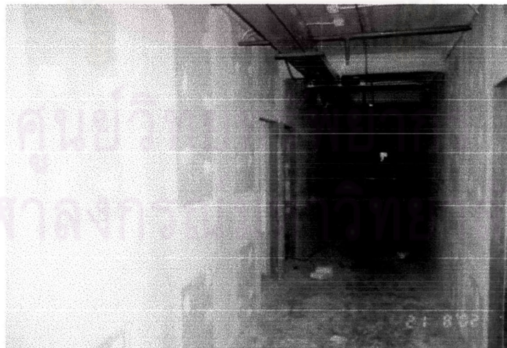
ภาพที่ 4-63 ผนังภายในอาคารส่วนหอพักที่ปูด้วยยิปซัมบอร์ดฉาบเรียบ
