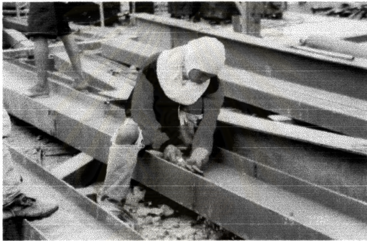
ภาพที่ 4-87 หัวตัดแก๊สสามารถใช้ตัดเหล็กที่มีความหนาต่างๆอย่างคานเหล็ก WF ได้
