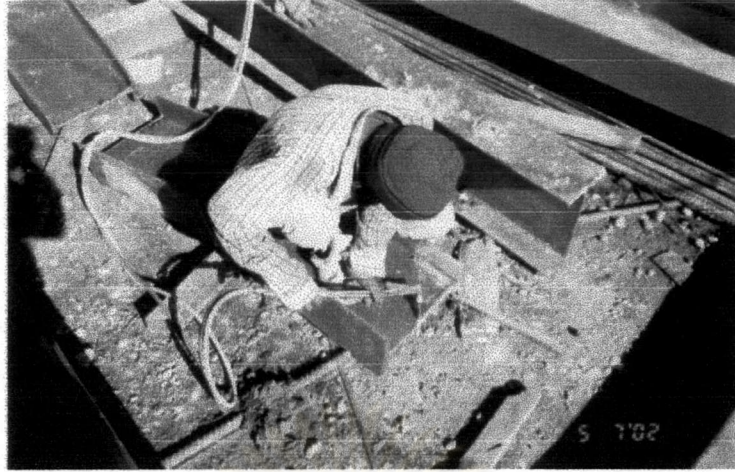
ภาพที่ 4-86 การใช้หัวตัดแก๊สในการตัดชิ้นส่วนคานเหล็กรูปพรรณ
