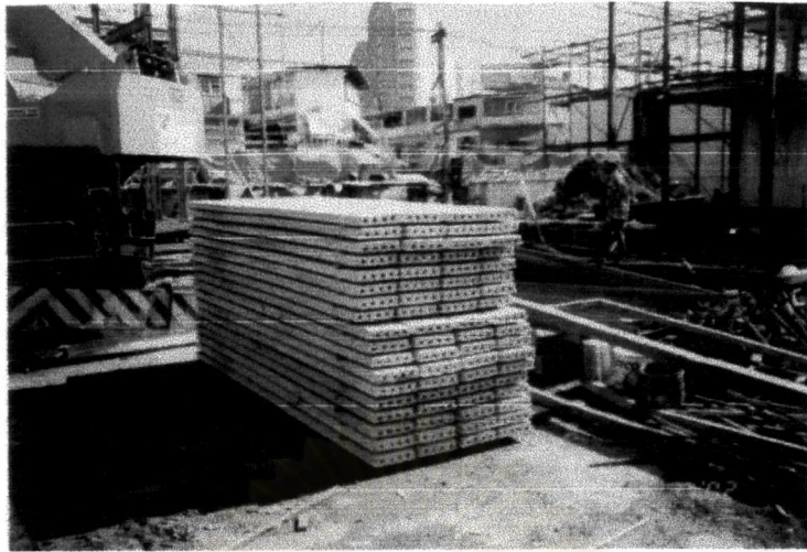
ภาพที่ 4-28 กองวัสดุพื้นสำเร็จรูปคอนกรีตอัดแรงชนิดที่องเรียบก่อนยกขึ้นติดตั้ง
