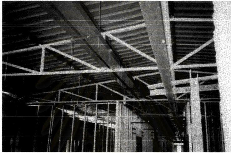
ภาพที่ 4-50 หลังคาแผ่นเหล็กรีดลอนเป็นวัสดุผนังของโครงสร้างหลังคาจั่วในส่วนหอพัก
