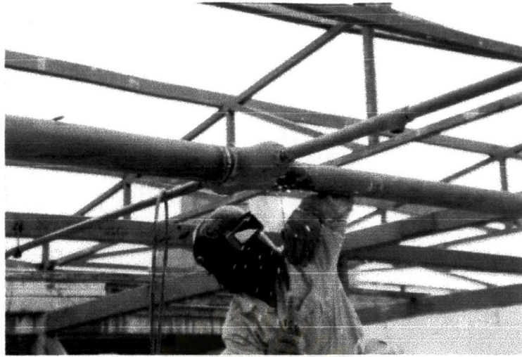
ภาพที่ 4-69 คนงานกำลังเชื่อมต่อท่อดับเพลิงสำหรับงานระบบป้องกันอัคคีภัย
