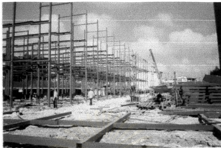
ภาพที่ 4-18 การใช้ Mobile Crane ยกชิ้นส่วนที่เชื่อมประกอบไว้แล้วยกขึ้นติดตั้งตามแนวเสาด้านขวางของอาคาร
