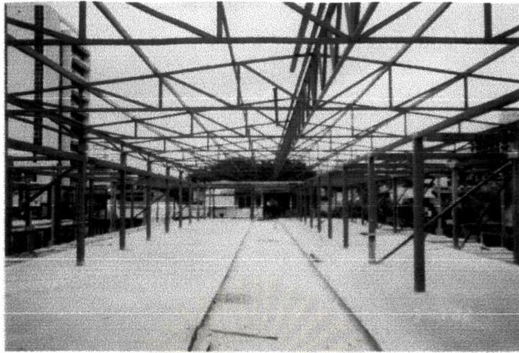
ภาพที่ 4-42 ภาพเหล็กโครงสร้างที่ใช้ทำโครงหลังคาจั่วบริเวณส่วนห้องพัก
