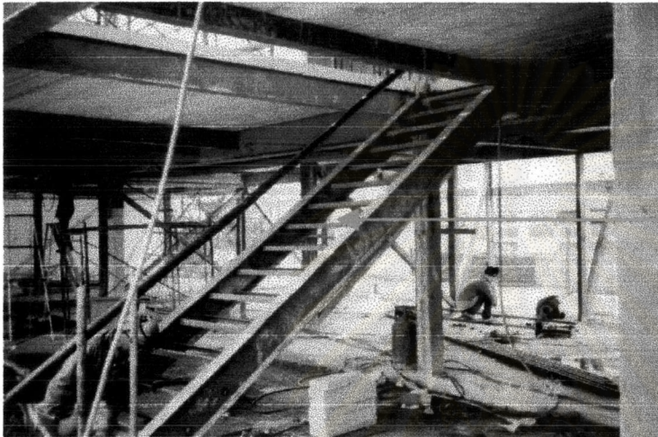
ภาพที่ 4-41 บันไดเหล็กรูปพรรณขึ้นชั้นปกกักเก็บน้ำและดาดฟ้าอาคารเหนือ Zone B
