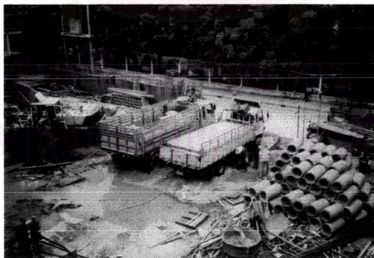
ภาพที่ 4-97 ปัญหาการเข้าออกเมื่อวัสดุเข้าหน้างาน รถเครนไม่สามารถทำงานติดตั้งโครงเหล็กรูปพรรณได้
