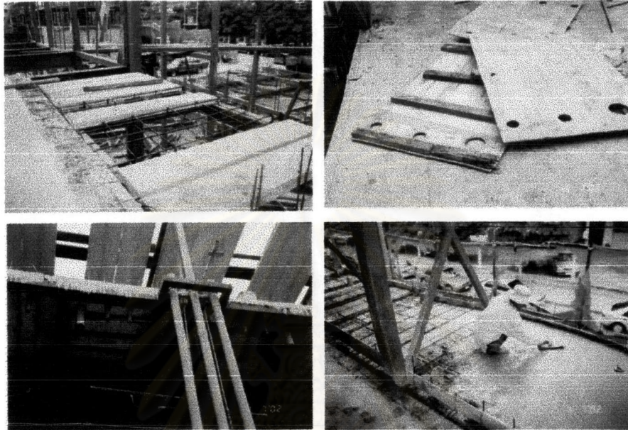
ภาพที่ 4-31 แสดงงานโครงสร้างพื้นห้องน้ำในส่วนห้องพักชั้น 2 และชั้น 3
