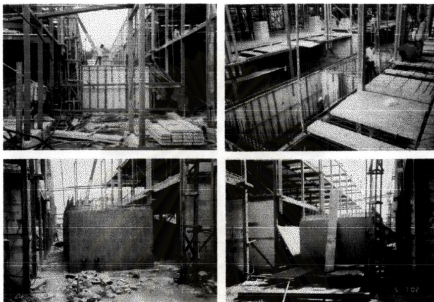
ภาพที่ 4-33 แสดงงานโครงสร้างพื้นห้องน้ำในส่วนห้องพักชั้น 2 และชั้น 3
