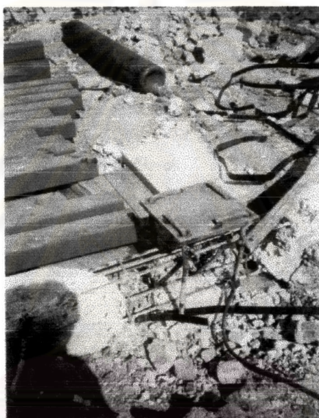
ภาพที่ 4-13 การสกัดคานคอดินเหนือฐานรากเพื่อทำแผ่นเหล็กประกบกับหัวเสายึดกับตอม่อ ค.ส.ล.
