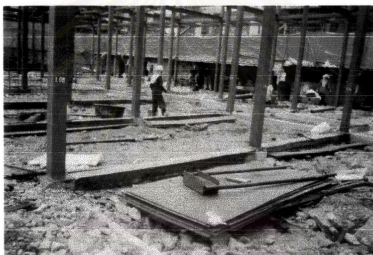
ภาพที่ 4-19 แสดงเฟรมโครงสร้างเหล็กที่ยึดติดกับแผ่นเหล็กประกบกับหัวเสา ที่มีช่วงกว้างเสา 3.50 x 3.50 เมตร
