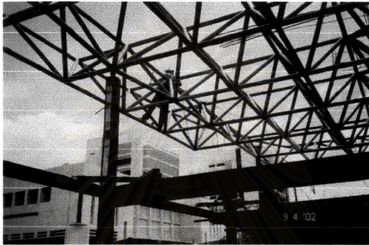
ภาพที่ 4-48 Space Frame เหล็กของโครงหลังคาโถงบันไดอาคาร Zone B
