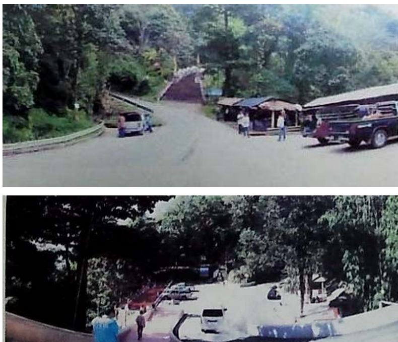
ภาพที่ 2.6.1-7 แสดงสภาพภูมิทัศน์บริเวณลานจอดรถและพื้นที่ส่วนร้านค้า ภายหลังจากปรับปรุง (ที่มา : เล่มรายงานโครงการบูรณะและปรับปรุงสภาพภูมิทัศน์วัดพระธาตุดอยตุง
