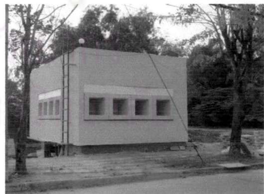
ภาพที่ 3-9 แสดงก่อกองทดลองที่กระทำการติดตั้งบนผนังอาคารทดสอบ
