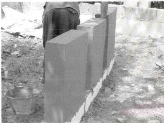
ภาพที่ 3-2 การเตรียมผนังก่ออิฐฉาบปูน เพื่อ กระทำการทดสอบ
