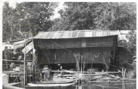
9. การตั้งบ้านเรือนรุกล้ำริมฝั่งแหล่งน้ำธรรมชาติลำตะคอง บริเวณหลังวัดสามัคคีถนนสุรนารายณ์
