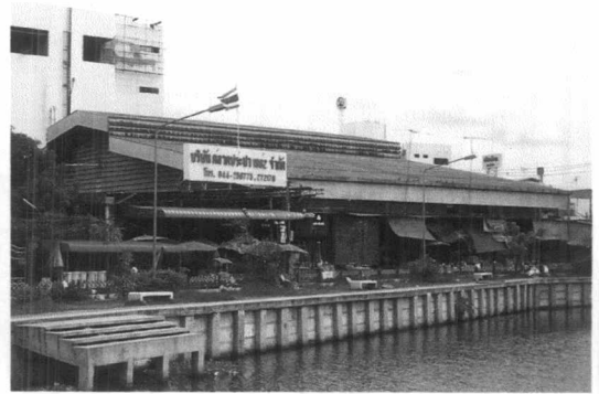
2. ตลาดประปา ตลาดสดของเทศบาล ที่ตั้งอยู่ติดกับอ่างเก็บน้ำอัมฤงค์
