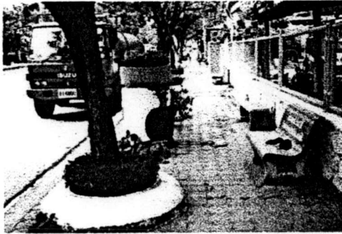
อุปกรณ์ประกอบถนนที่มีรูปแบบหลากหลายไม่สวยงามและชำรุดไม่น่าใช้
