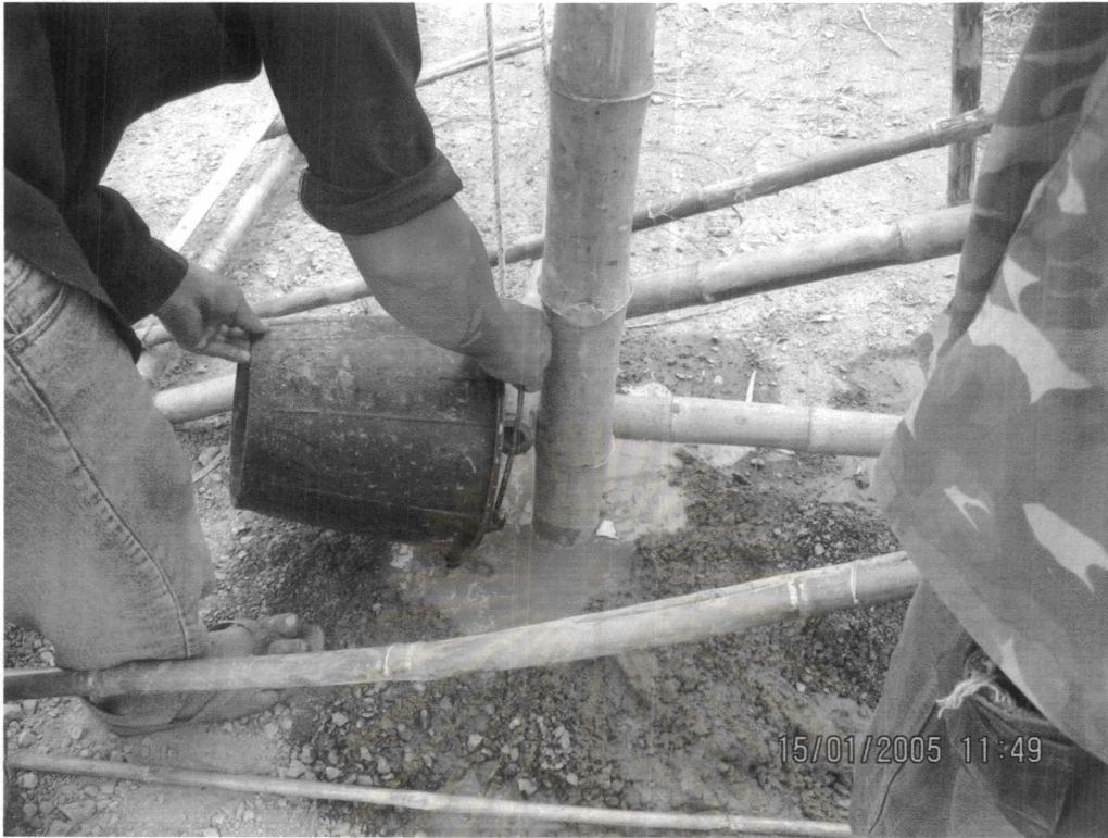
ภาพที่ 7.39 แสดงการเทปูนลงไปหลุมเสาตอม่อ (1)
