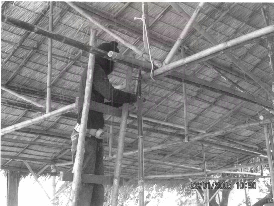
ภาพที่ 7.57 แสดงการถอดเสากลางช่วงพาด และค้ำยันเสา (3)
