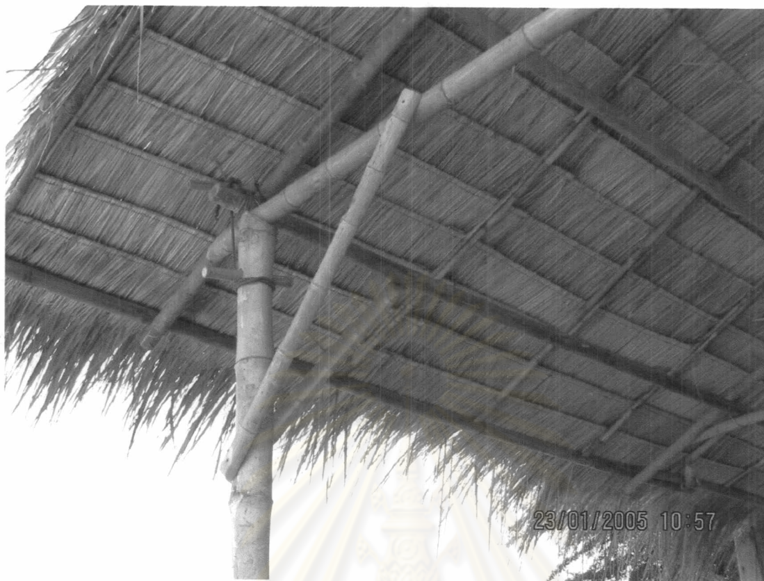
ภาพที่ 7.60 แสดงการเสริมค้ำยันหลังคา (1)
