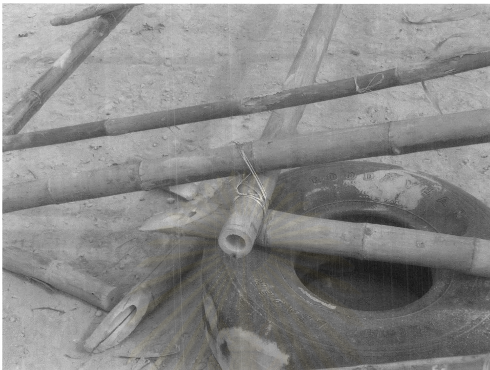
ภาพที่ 7.20 แสดง รอยต่อ อะเส, ชื่อ และดั่ง (1)
