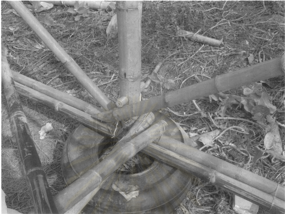
ภาพที่ 7.18 แสดง รอยต่อตั้งเอากับข้อคู้ และโครงยึดยัน (1)
