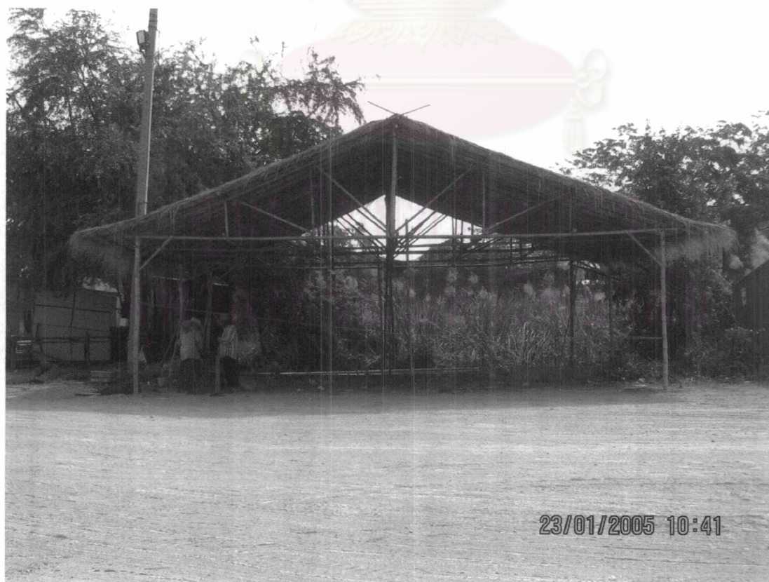
ภาพที่ 7.52 แสดงการมุงหลังคาแล้วเสร็จ (1)
