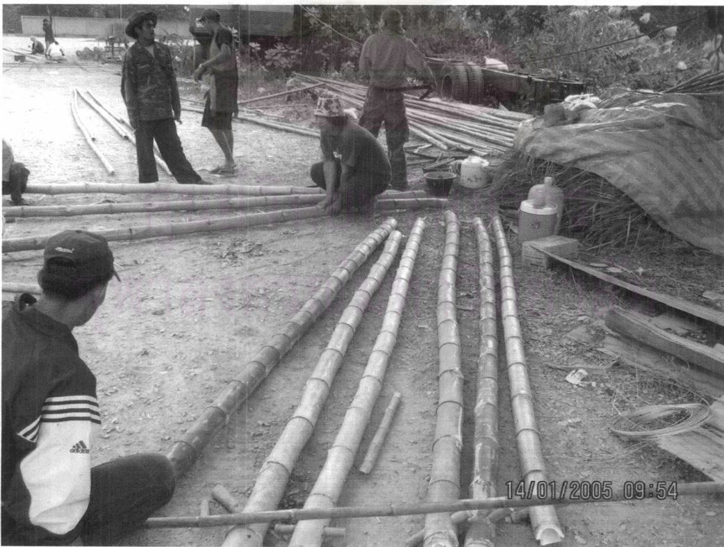
ภาพที่ 7.11แสดง การกองและเตรียมชิ้นส่วนโครงสร้าง
