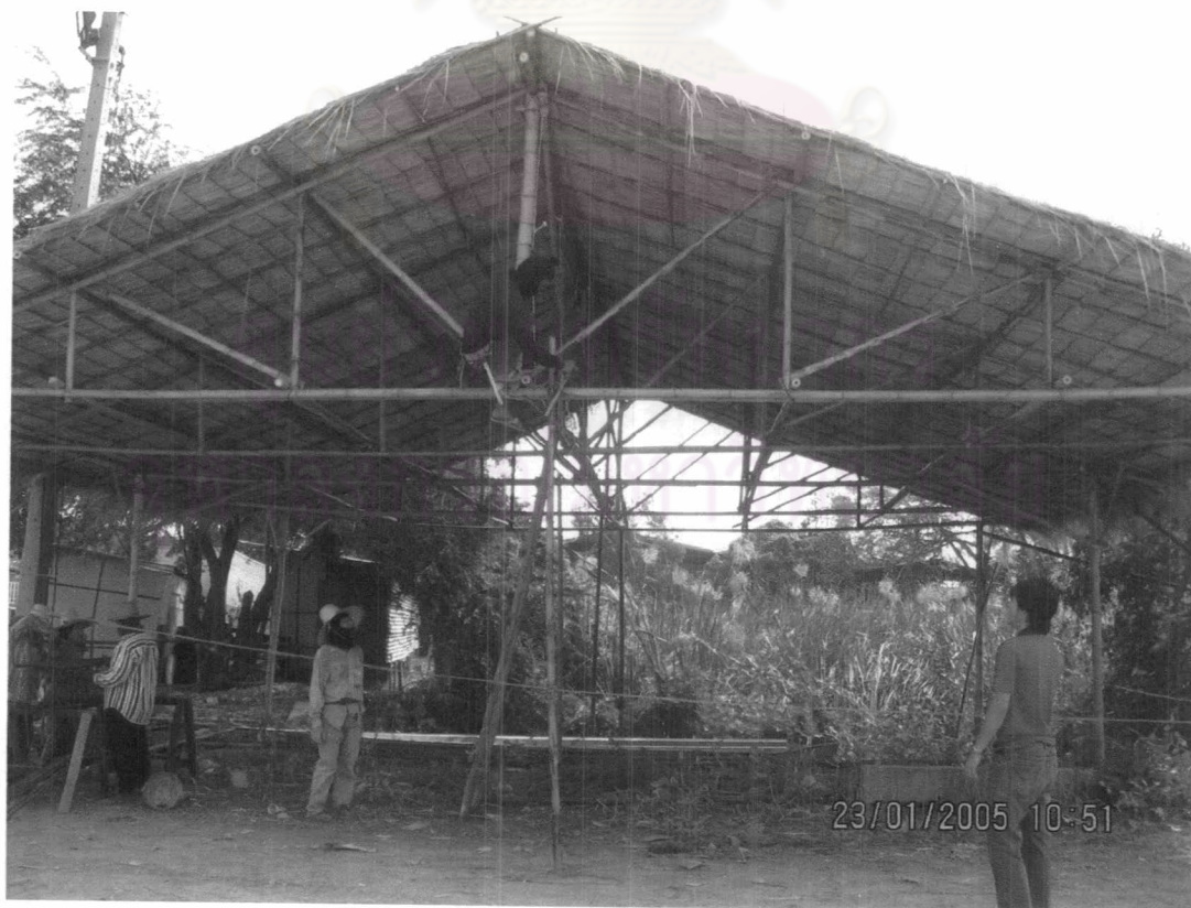
ภาพที่ 7.59 แสดงการถอดเสากลางช่วงพาด และค้ำยันเสา (5)
