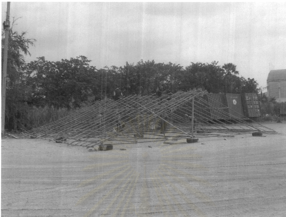
ภาพที่ 7.14 แสดง การประกอบโครงหลังคาบนยางล้อรถยนต์ (2)
