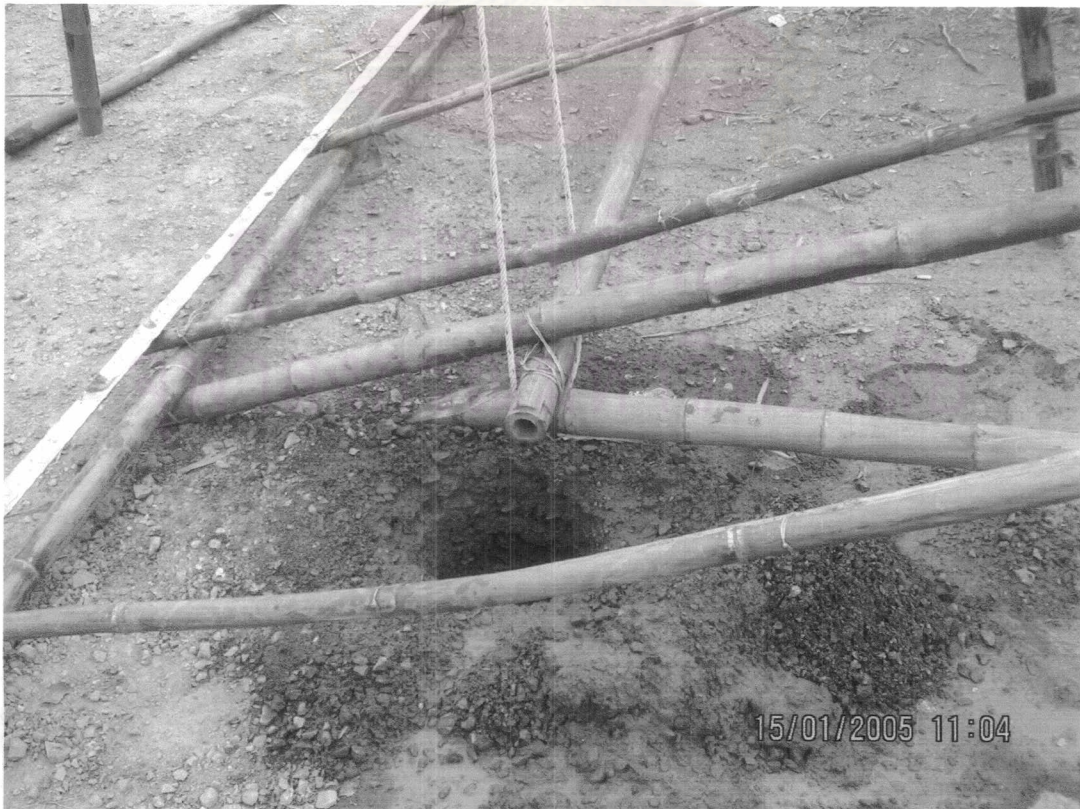
ภาพที่ 7.34 แสดงการขุดหลุมเสาตอม่อ (2)
