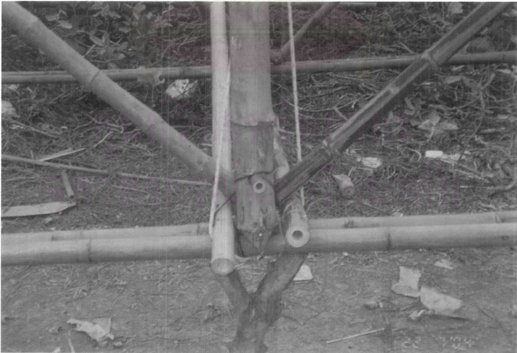
ภาพที่ 7.28 แสดงการใช้เชือกมะนิลามัดโครงสร้าง (1)
