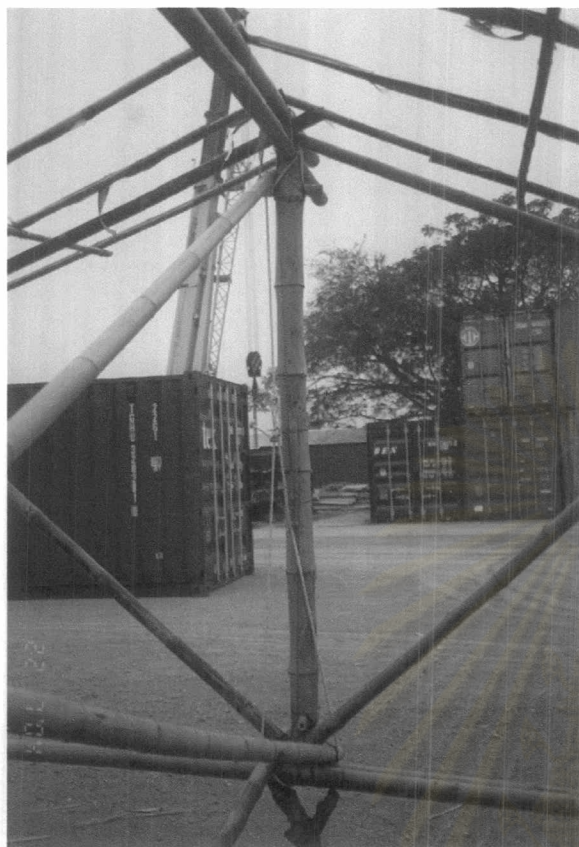
ภาพที่ 7.29 แสดงการใช้เชือกมะนิลามัดโครงสร้าง (2)
