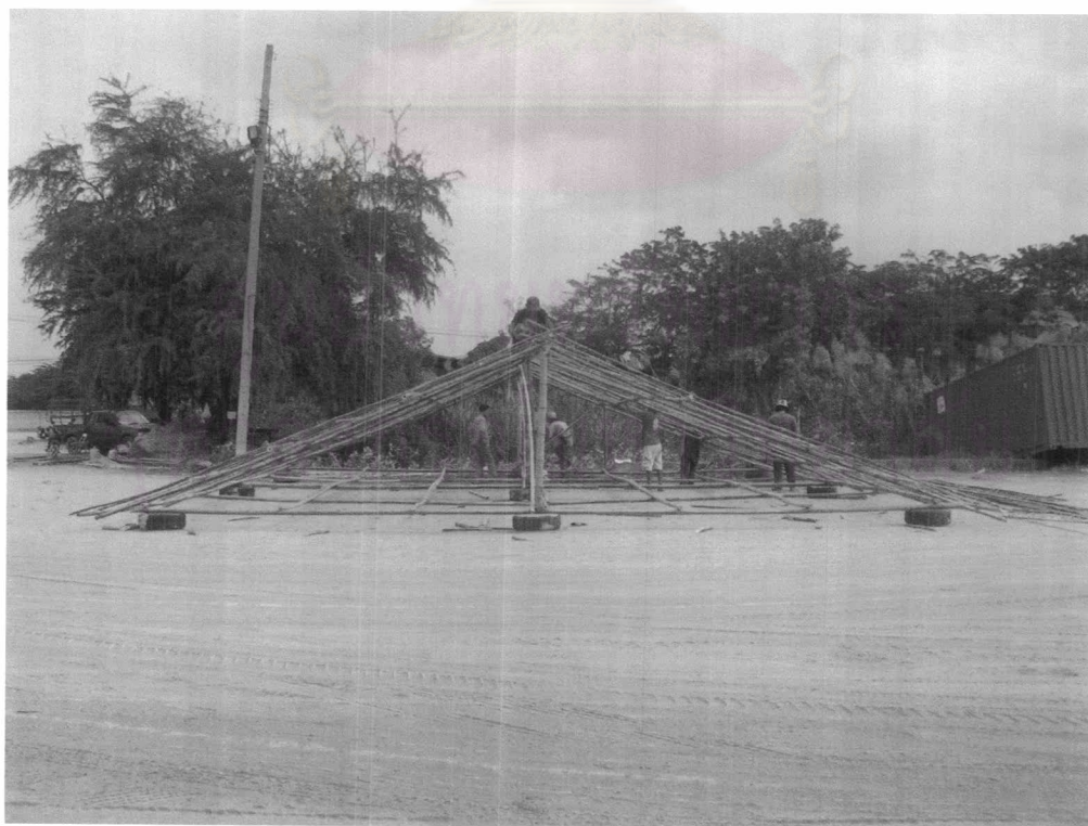
ภาพที่ 7.13 แสดงการประกอบโครงหลังคาบนยางล้อรถยนต์ (1)
