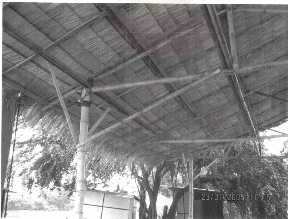
ภาพที่ 7.61 แสดงการเสริมค้ำยันหลังคา (2)
