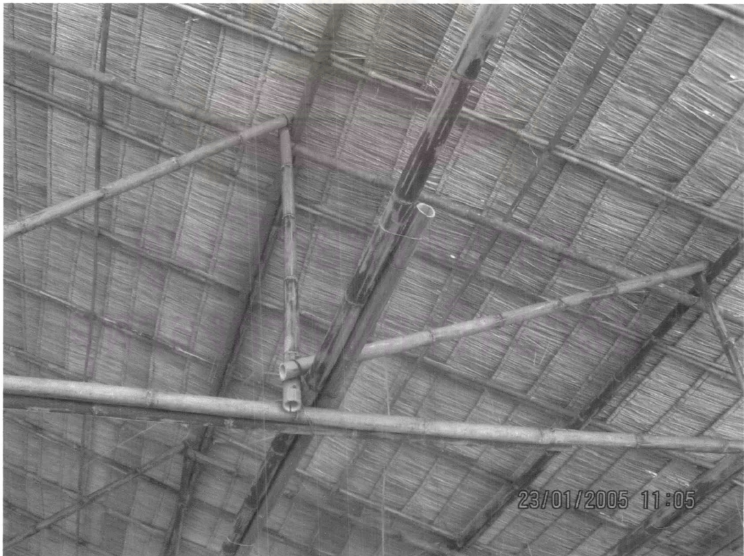
ภาพที่ 7.63 แสดงโครงสร้างหลังสิ้นสุดการก่อสร้าง (2)
