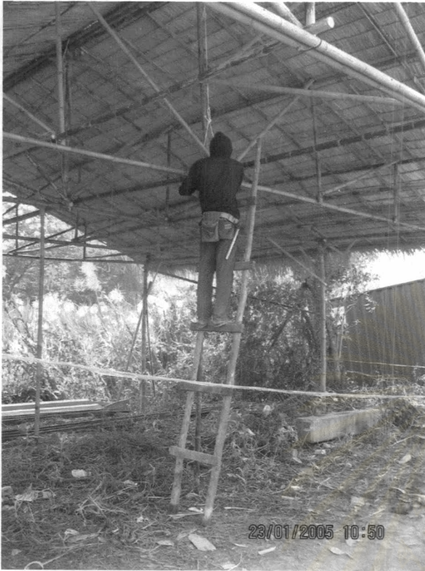
ภาพที่ 7.55 แสดงการถอดเสากลางช่วงพาด และค้ำยันเสา (1)
