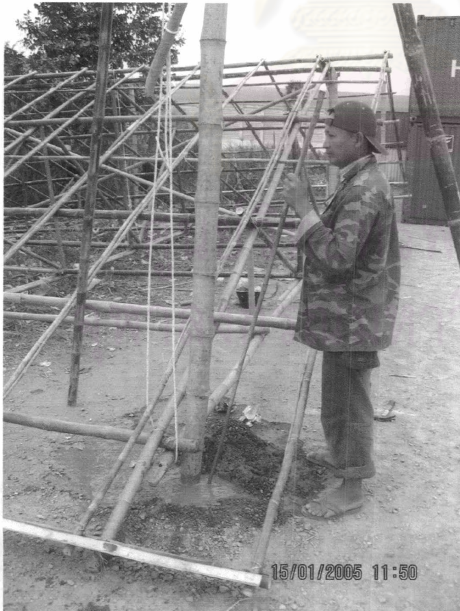
ภาพที่ 7.40 แสดงการเทปูนลงไปหลุมเสาตอม่อ (2)
