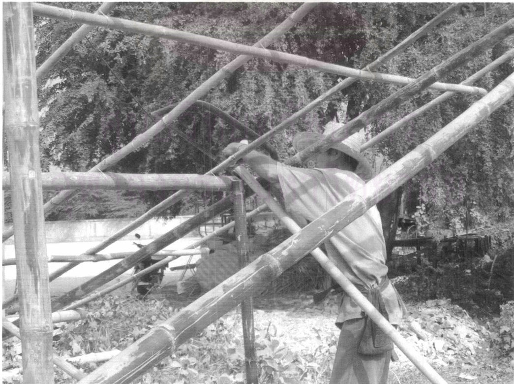
ภาพที่ 7.24 แสดงการติดตั้งตั้งโท และซื่อใน (1)
