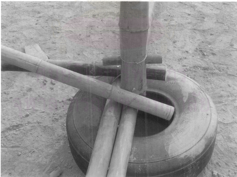
ภาพที่ 7.19 แสดง รอยต่อตั้งเอากับข้อคู้ และโครงยึดยัน (2)
