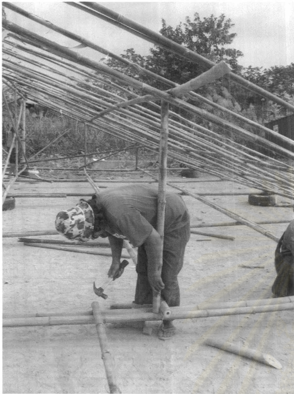
ภาพที่ 7.22 แสดงการติดตั้งตั้งโท และอะเสใน
