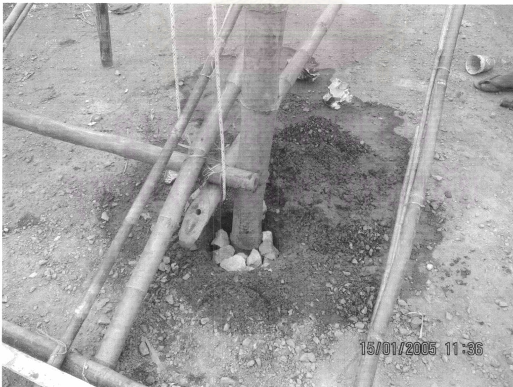
ภาพที่ 7.36 แสดงการติดตั้งเสาและเสริมด้วยเศษหินและอิฐลงไปในหลุม (1)
