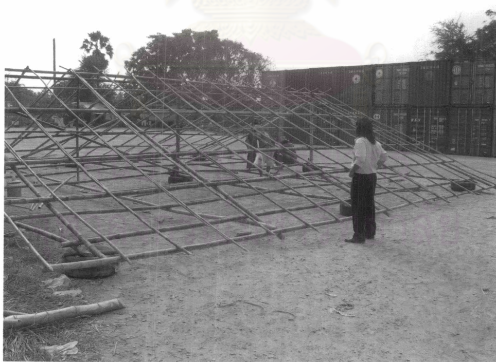
ภาพที่ 7.15 แสดง การประกอบโครงหลังบนยางล้อรถยนต์ (3)
