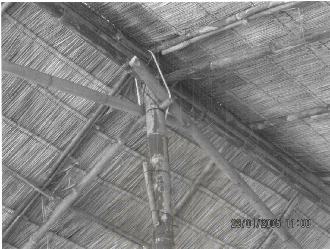
ภาพที่ 7.64 แสดงโครงสร้างหลังสิ้นสุดการก่อสร้าง (3)
