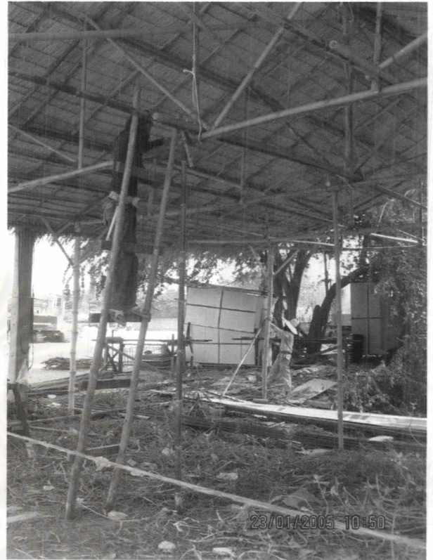
ภาพที่ 7.56 แสดงการถอดเสากลางช่วงพาด และค้ำยันเสา (2)
