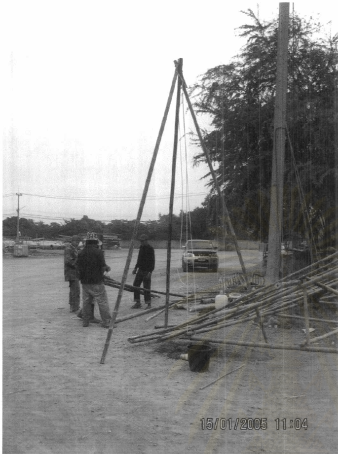
ภาพที่ 7.35 แสดงการติดตั้งเสาหมอนเพื่อการยกโครงหลังคา
