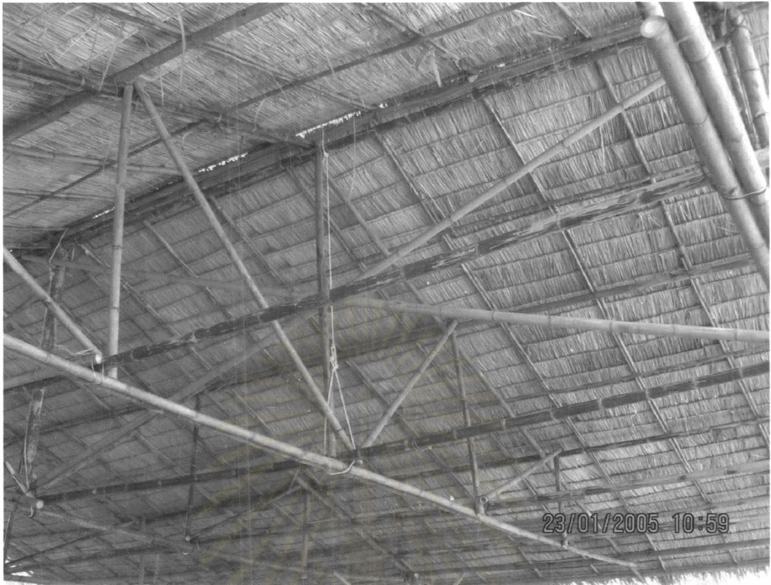
ภาพที่ 7.62 แสดงโครงสร้างหลังสิ้นสุดการก่อสร้าง (1)
