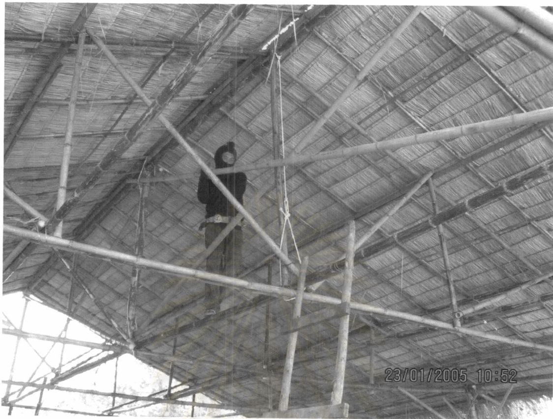
ภาพที่ 7.58 แสดงการถอดเสากลางช่วงพาด และค้ำยันเสา (4)
