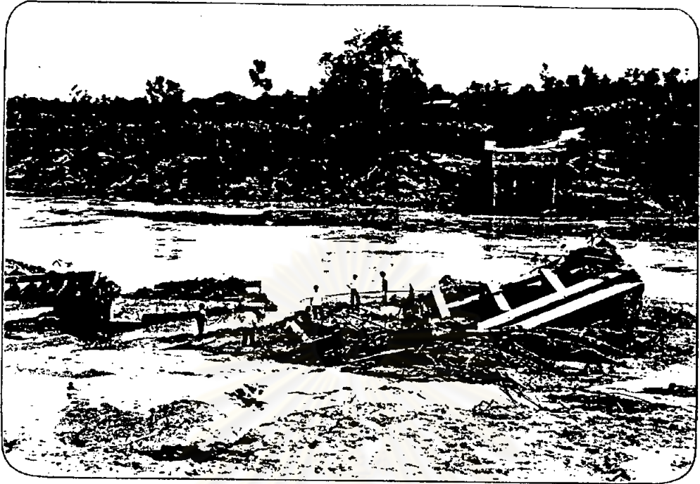
รูป ข-6 ส่วนต่างๆของโครงสร้างสะพาน กระจายอยู่ด้านท้ายน้ำ และ ส่วนใหญ่อยู่ด้านส่วนโค้งในของลำนน้ำ
