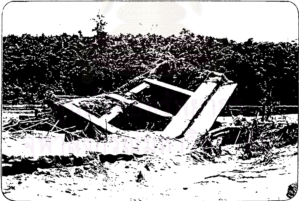
รูป ข-9 ตอม่อแตกหักพิบอยู่บนฐานราก ปริมาณสวะ กิ่งไม้ที่ติดอยู่สามารถ ทำให้ตอม่อกลายเป็นแผ่นทึบ และถูกแรงน้ำกระทำ
