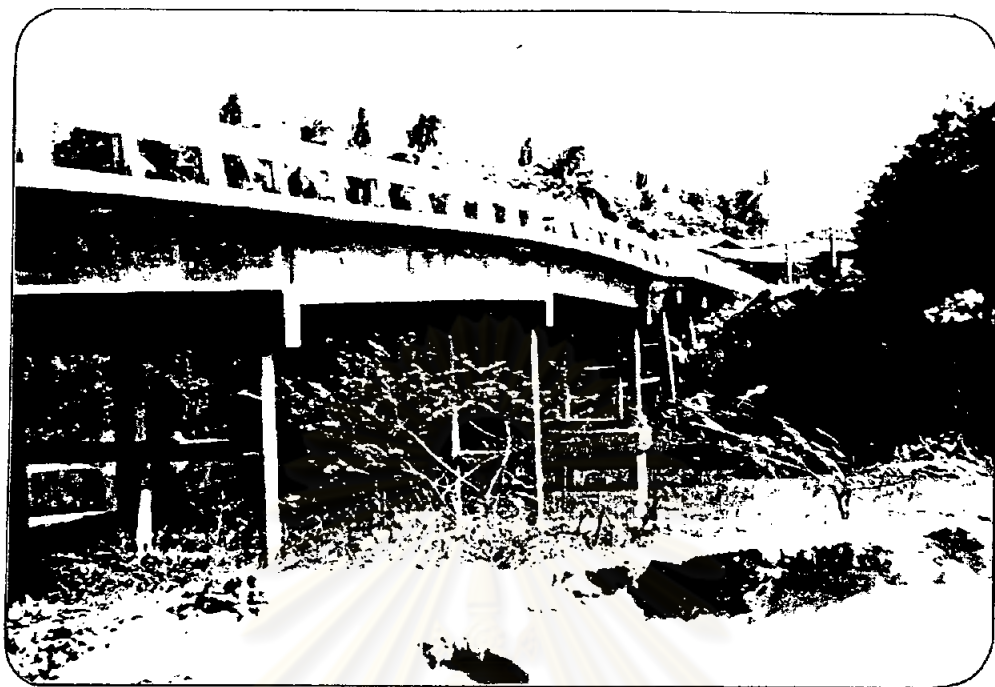
รูป ง-5 ตอม่อสะพานค้ำที่ทรุดลง จะเห็นได้ชัดทางด้านข้างของสะพาน แต่พื้นและตอม่อไม่ปรากฏรอยแตกร้าว (ปี 2525)
