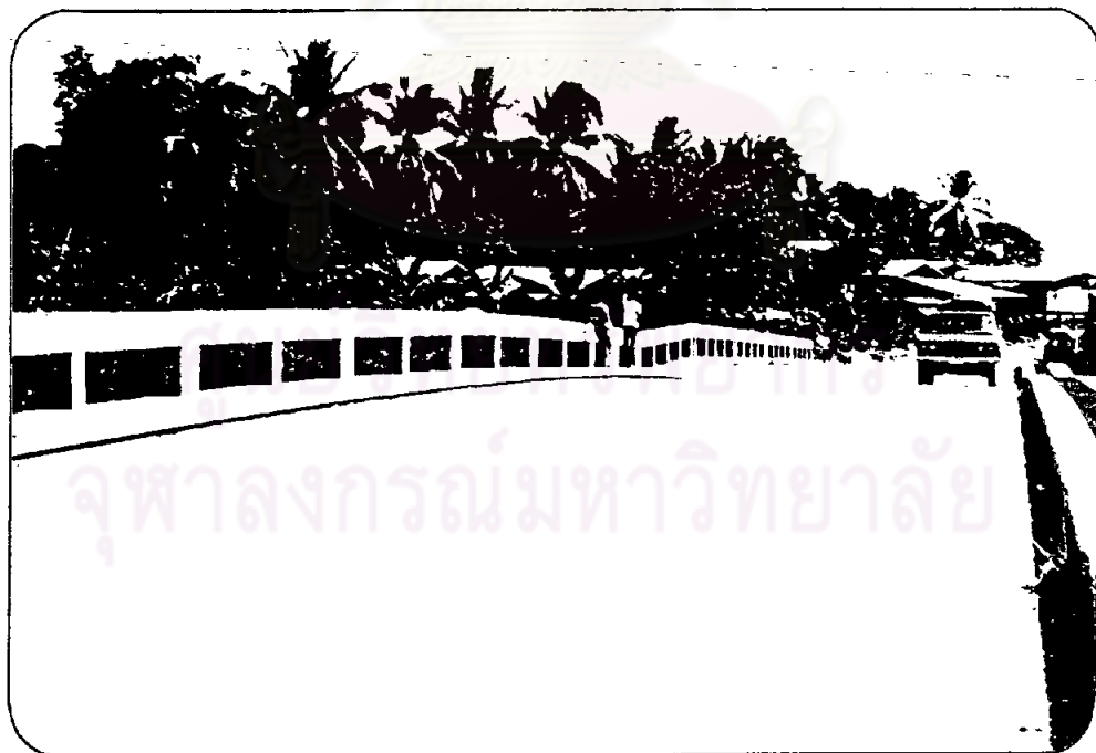
รูป ง-6 ระดับการทรุดตัวของตอม่อที่ปรากฏ เมื่อมองเปรียบเทียบกับระดับทางเท้าและราวสะพาน (ปี 2525)
