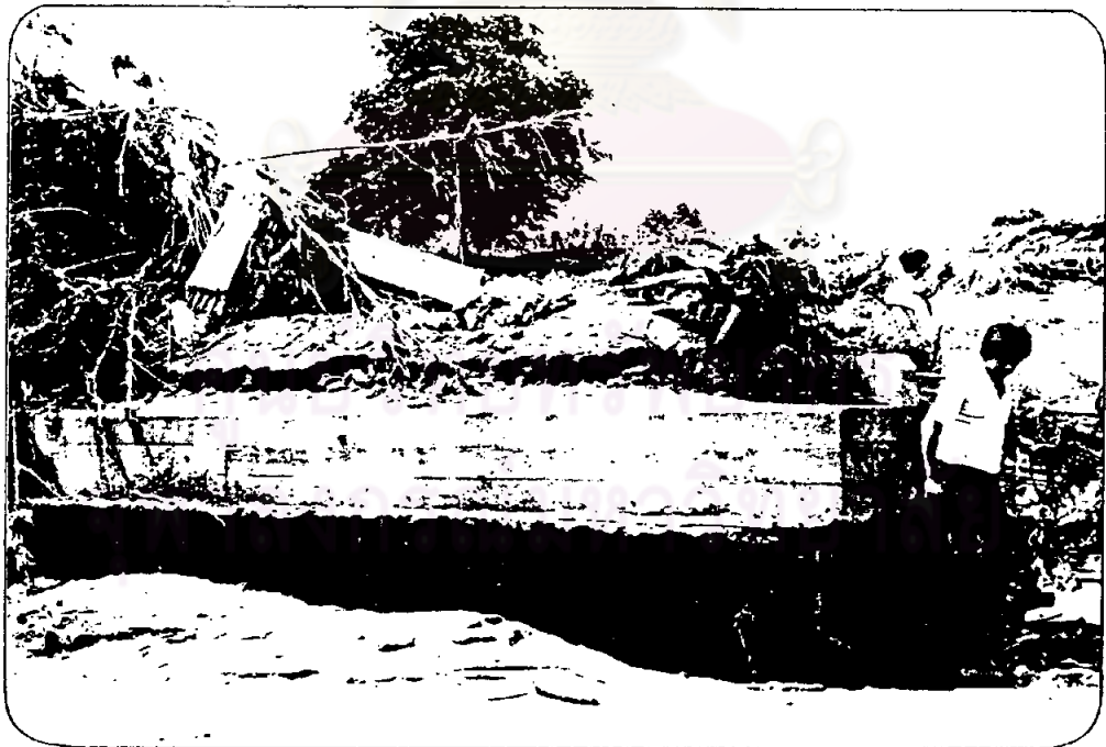
รูป ข-11 ส่วนของฐานรากที่ถูกกัดเซาะ เดิมนั้นฝังอยู่ใต้ระดับท้องน้ำ ประมาณ 1.50 เมตร
