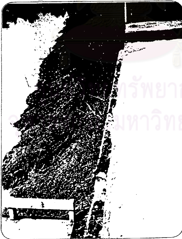
รูป ค-10 ตำแหน่งและ ระดับของพื้นสองช่วงที่ หลุดออกจากกัน สามารถ คาดการณ์ลักษณะการพัง ทลายได้
