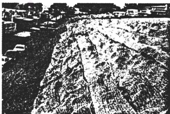
ภาพที่ 2.8. แสดงการใช้วัสดุพืชพันธุ์กันการกัดเซาะพังทลายพร้อมคลุมด้วยฟางและตาข่าย (สุตสวาสดี, 2545: 67)
