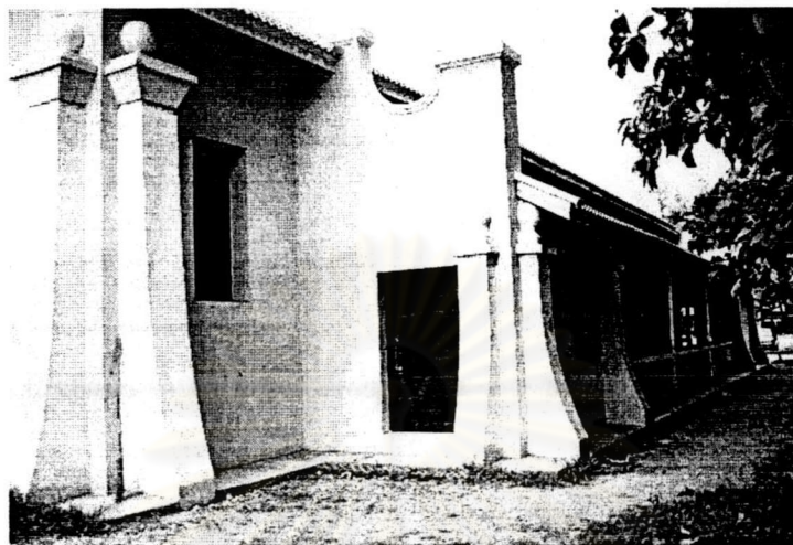
รูปที่.๔.๕.๒๘ ด้านข้างอาคาร
