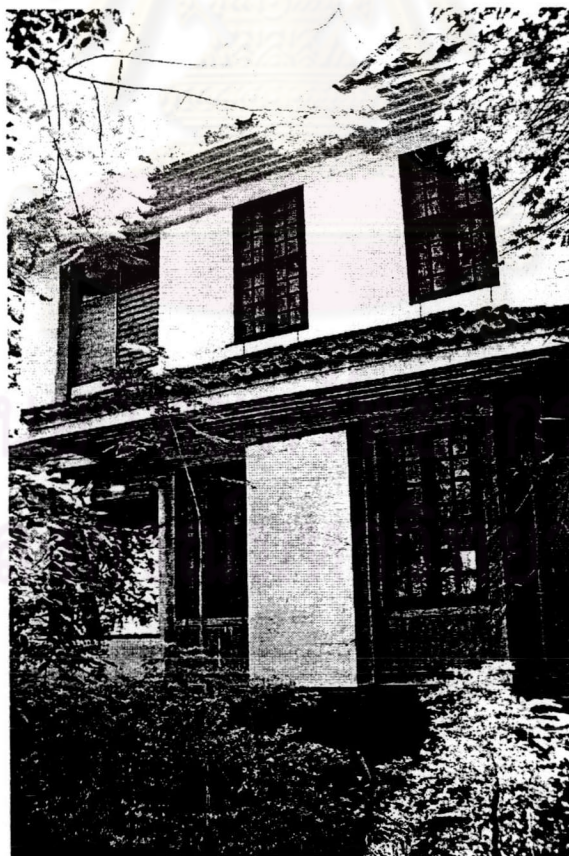
รูปที่.๔.๓.๗ แสดงด้านข้างทางทิศเหนือของอาคาร
