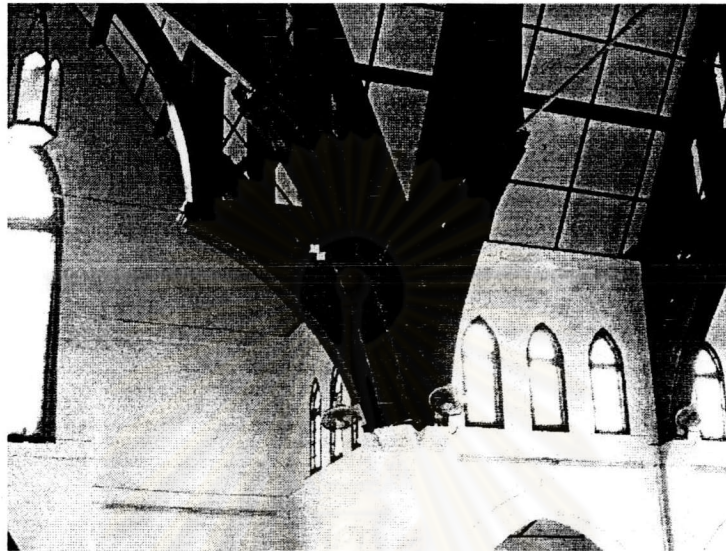
รูปที่.๔.๕.๒๑ โครงถักไม้บริเวณหัวเสา
