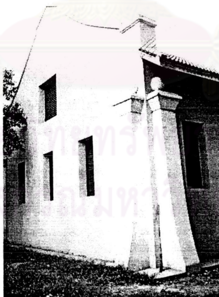
รูปที่.๔.๕.๒๙ ช่องเจาะสี่เหลี่ยมและเสาปูนประดับอาคาร
