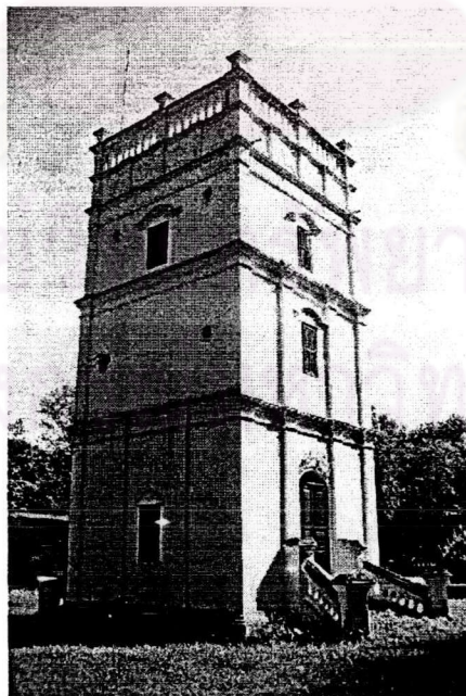
รูปที่.๔.๔.๑๖ หอเก็บน้ำ
