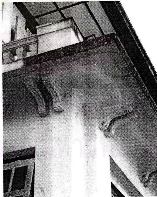
รูปที่ ๕.๕.๘ การใช้ท้าวแขนปูนเป็นส่วนประดับและตกแต่งอาคาร
