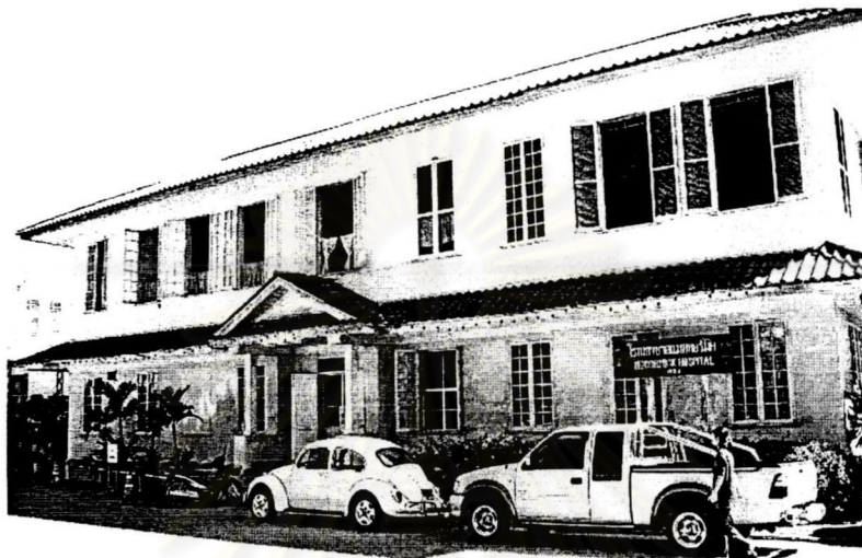
รูปที่ ๔.๒.๕ ด้านหน้าของอาคาร
