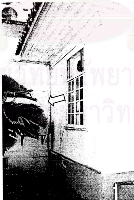
รูปที่. ๔.๒.๙ อาคารที่สร้างใหม่เชื่อมติดกับอาคาร ณ เชียงใหม่
