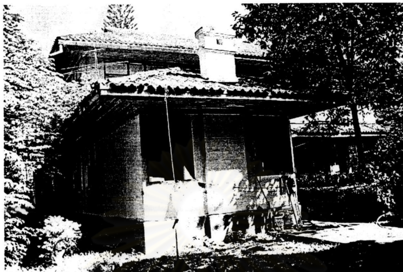
รูปที่.๔.๓.๖ ห้องครัวและห้องนอนคนใช้ที่แยกออกจากอาคาร
