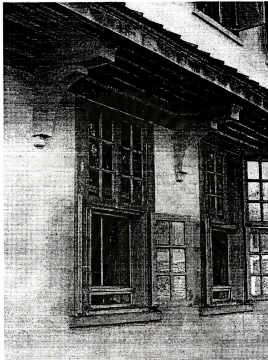
รูปที่.๔.๖.๒๖ แสดงการตกแต่งภายนอกของบ้านด้วยท้าวแขนปูน
