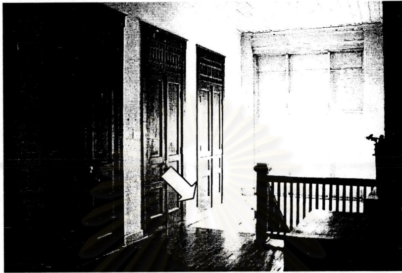
รูปที่.๕.๖.๑๙ การต่อเติมบันไดภายหลัง คาดว่าบริเวณนี้จะเป็นระเบียงเดิม
