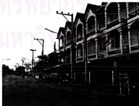
ภาพที่ 5.66 แสดงบ้านภายในโครงการ การใช้ประโยชน์ อาคารภายในชุมชน ยังมีประสิทธิภาพไม่เต็มที่
