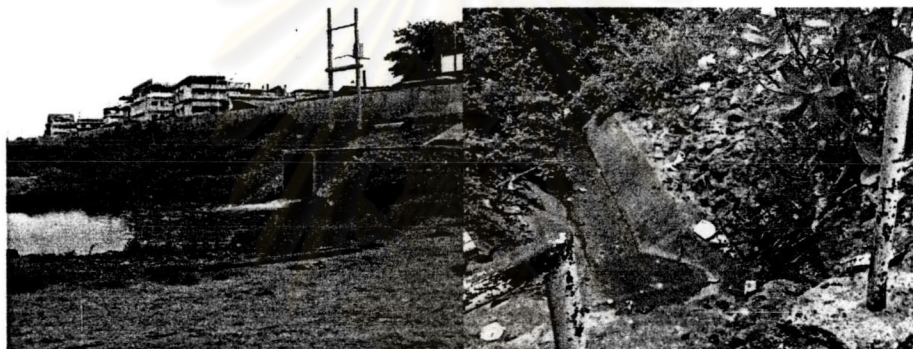
ภาพที่ 6.66 แสดงพื้นที่ริมแม่น้ำ ที่ขาดการดูแลรักษาในด้านทัศนียภาพ และการป้องกันน้ำเสีย
