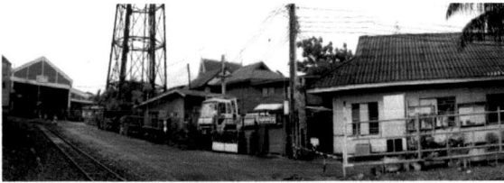
● กลุ่มอาคารบ้านบุ
