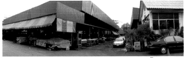
● อาคารตลาดศาลาน้ำร้อน
