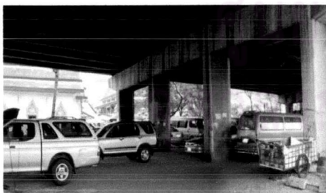
● การจอดรถใต้สะพานอรุณอมรินทร์
