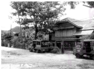
● กลุ่มบ้านในหมู่บ้านนิคมรถไฟ
