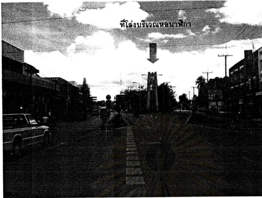
ภาพที่ 3.15 ที่โล่งบริเวณหอนาฬิกา ซึ่งเป็นที่โล่งระหว่างทางแยกของถนนราชดำเนินและถนนหลังพระบรมธาตุ และเป็นที่ตั้งของหอนาฬิกาซึ่งมีความสูงข่มและบดบังพระบรมธาตุเจดีย์ซึ่งเป็นที่ยูนิคที่ล้ำค้ำของเมือง
