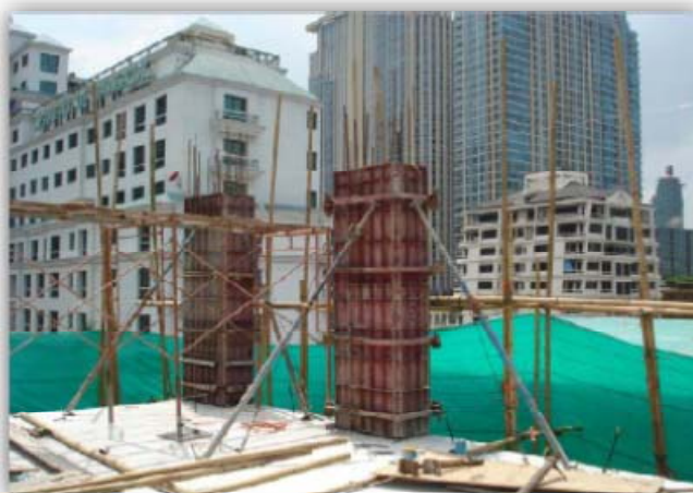
งานเสาชั้น 8
