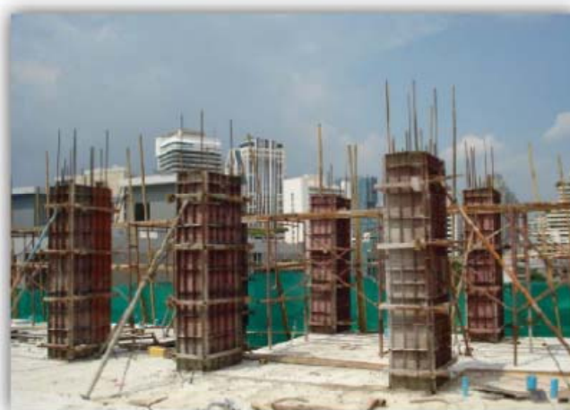
งานเสาชั้น 8
