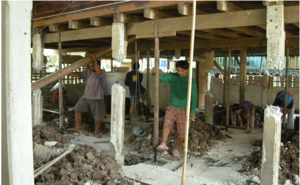
รูปที่ 4-53 ดัดบ้านชั้นที่ละ 5-30 เซนติเมตร
