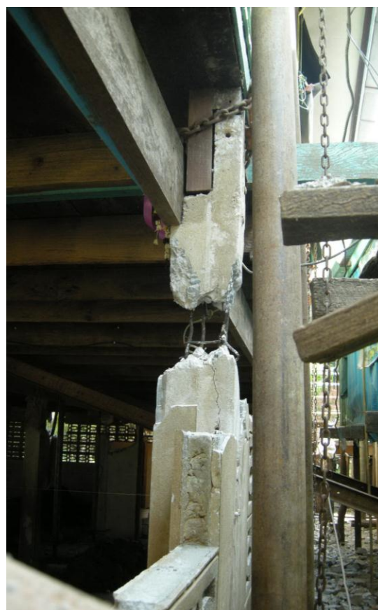
รูปที่ 4-38 การติดตั้งรอกยกบ้าน
