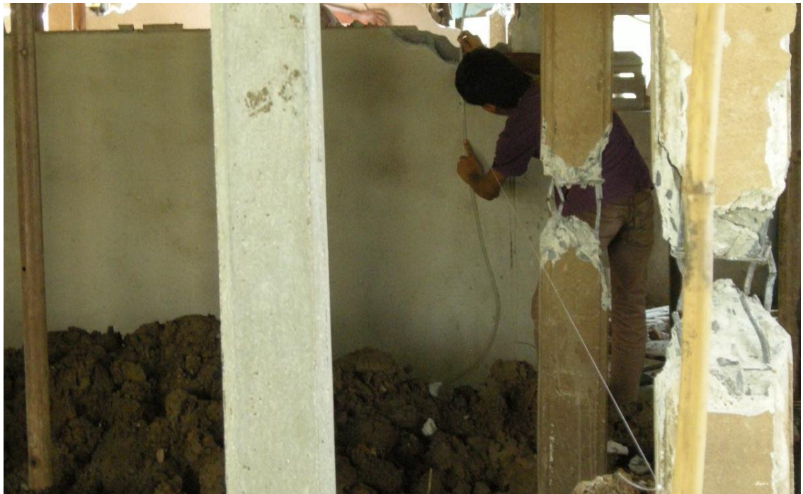
รูปที่ 4-46 การติดตั้งอุปกรณ์วัดระดับแนวตั้ง
