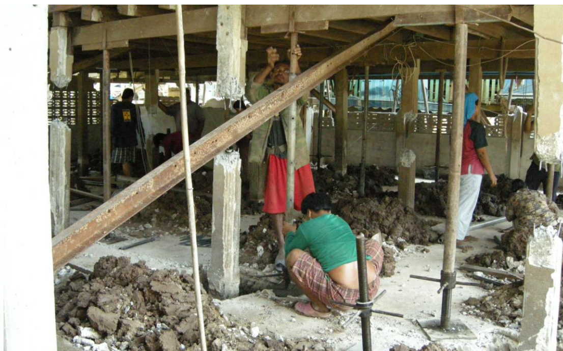
รูปที่ 4-52 ติดบ้านขึ้นทีละ 5-30 เซนติเมตร
