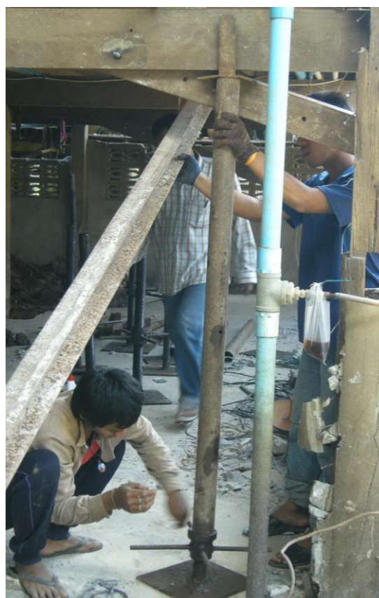
รูปที่ 4-35 การติดตั้งแม่แรงติดบ้าน
