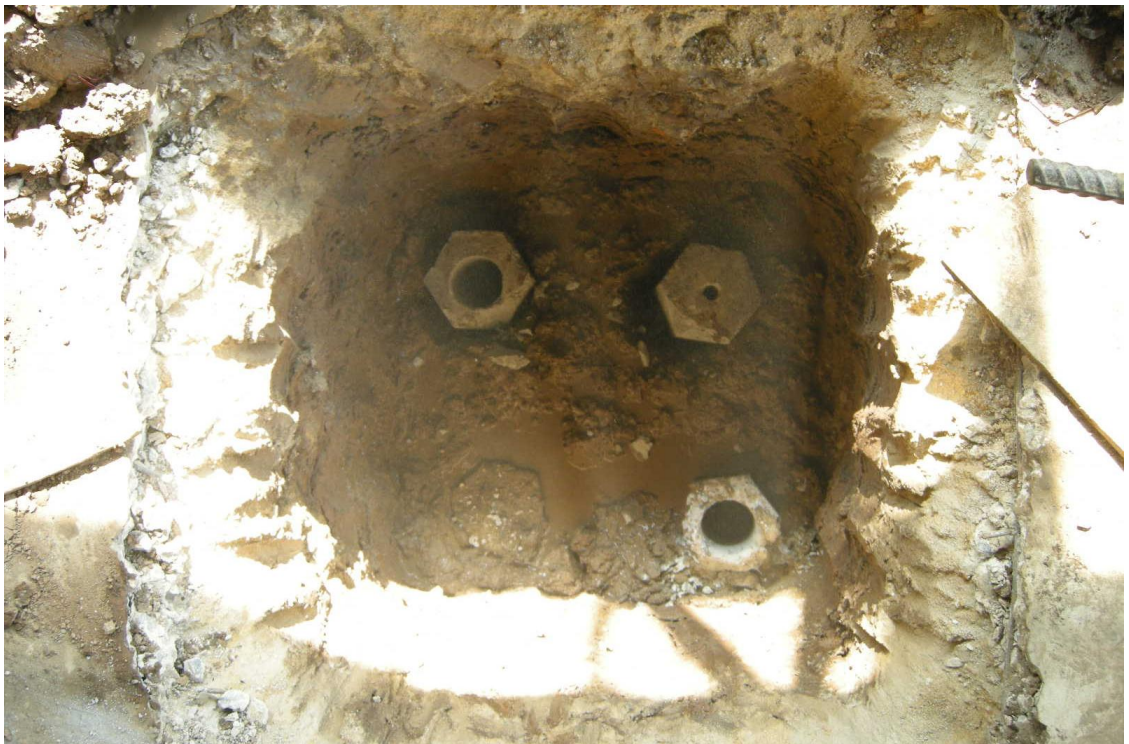
รูปที่ 4-62 การเตรียมหลุมวางเสาใหม่สำหรับหลุมที่ไม่มีฐานรากเดิม
