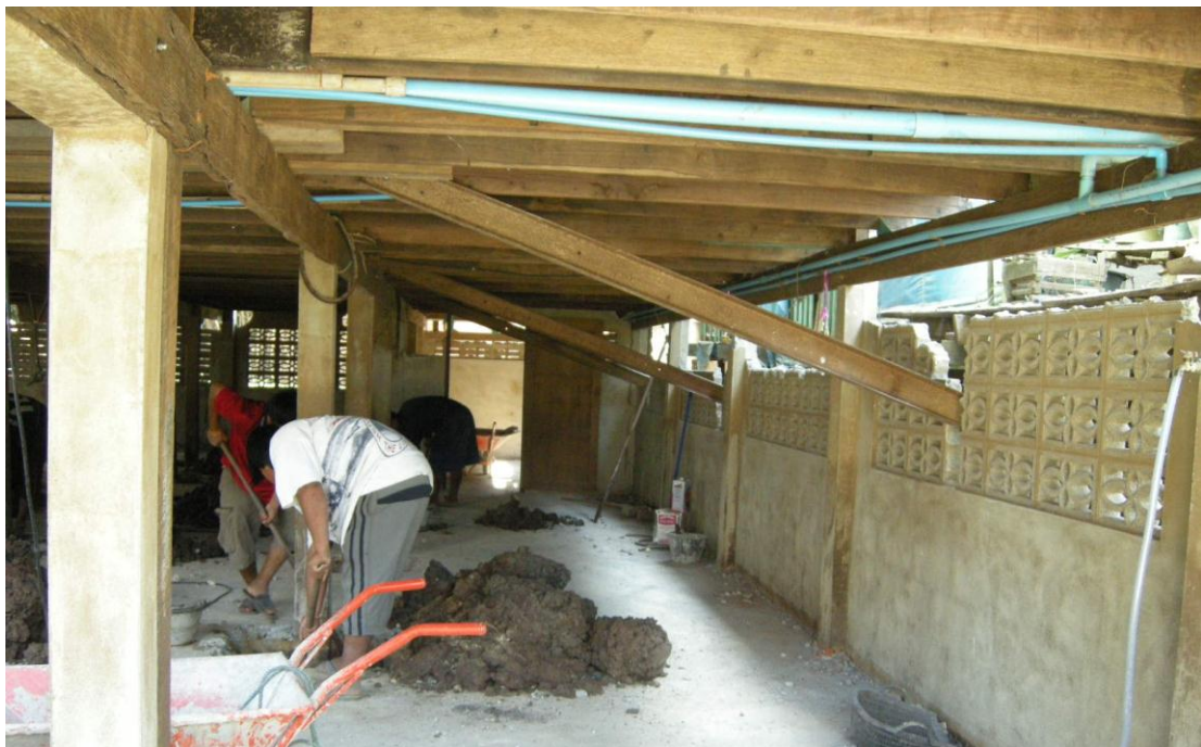
รูปที่ 4-25 การติดตั้งอุปกรณ์ช่วยการทรงตัวแนวดิ่ง
