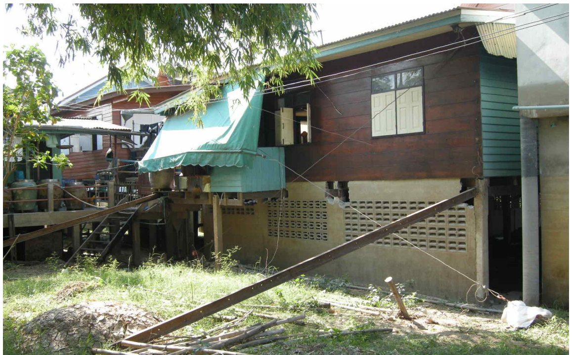
รูปที่ 4-28 การติดตั้งอุปกรณ์ช่วยการทรงตัวแนวขวาง
