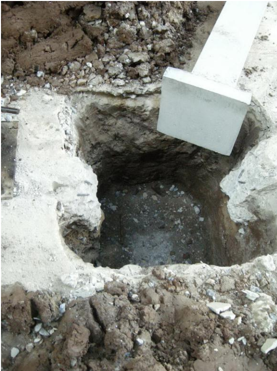
รูปที่ 4-61 การเตรียมหลุมวางเสาใหม่สำหรับหลุมที่มีฐานรากเดิม
