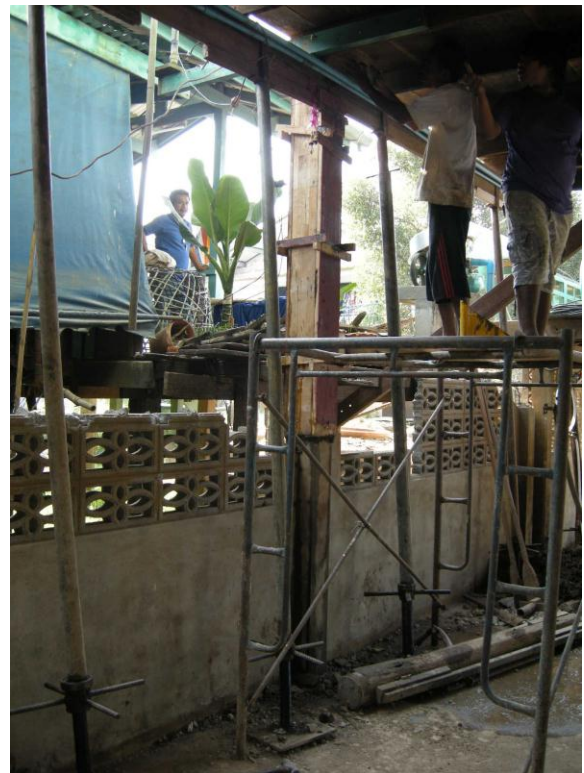
รูปที่ 4-66 ขั้นตอนการหล่อเสาใหม่
