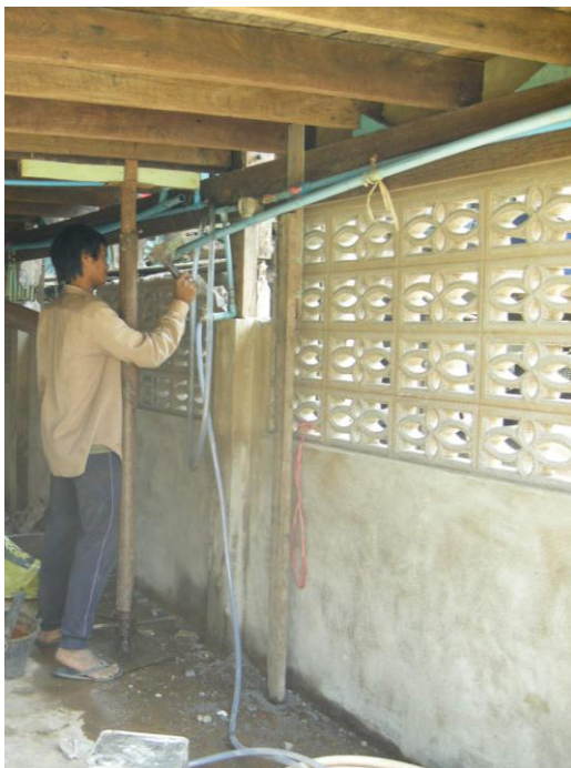
รูปที่ 4-16 การตัดต่อระบบท่อประปาใหม่
