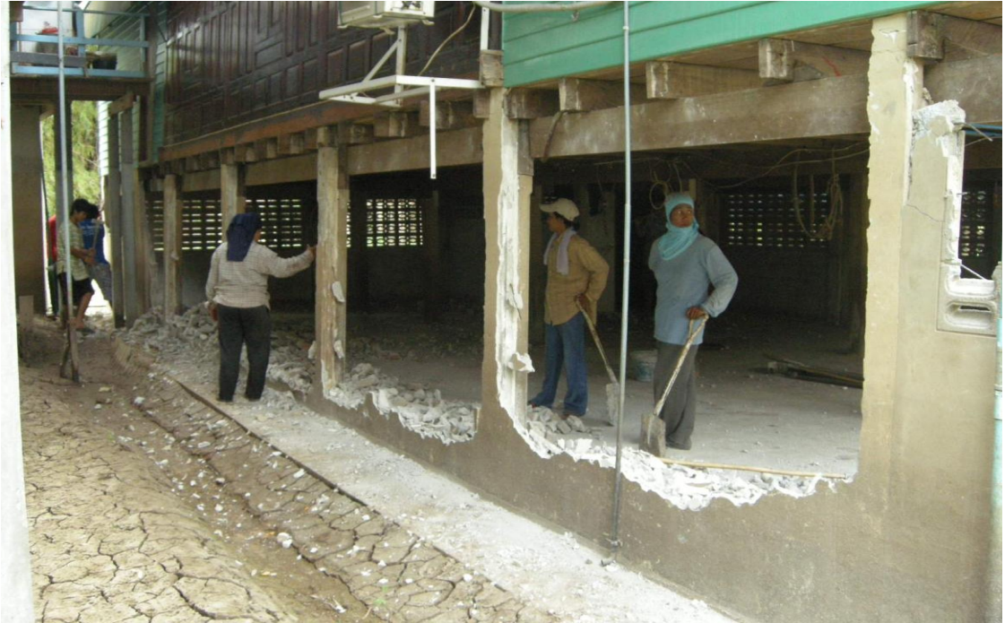
รูปที่ 4-12 การรื้อถอนกำแพงใต้ถุนบ้าน
