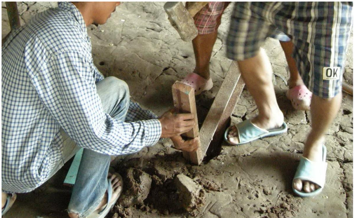
รูปที่ 4-54 การย้ายตำแหน่งไม้ค้ำค้ำยัน
