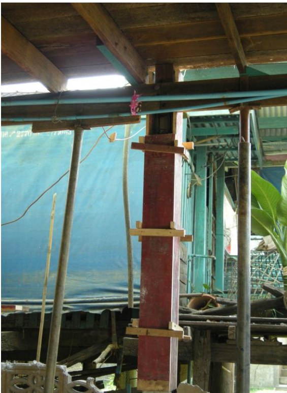
รูปที่ 4-66 ขั้นตอนการหล่อเสาใหม่
