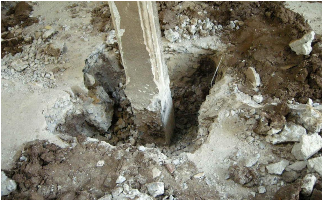
รูปที่ 4-22 การเจาะพื้นคอนกรีต
