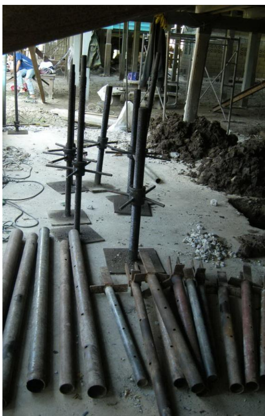
รูปที่ 4-35 การติดตั้งแม่แรงติดบ้าน
