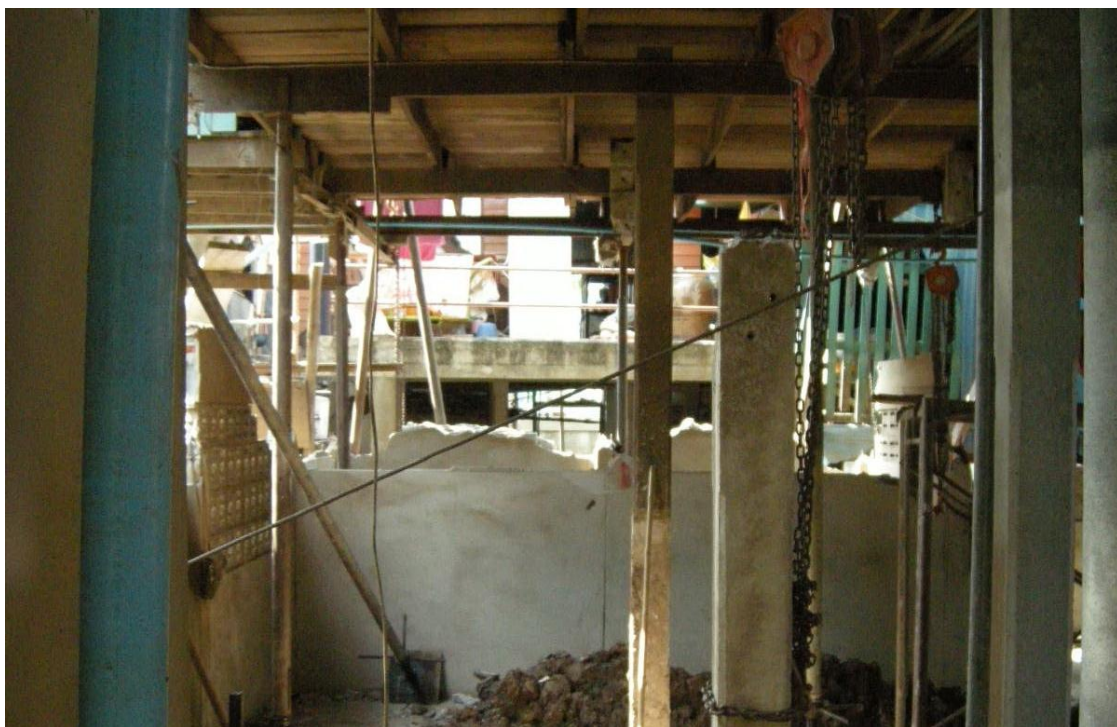
รูปที่ 4-58 การถอดเสาเดิมออก
