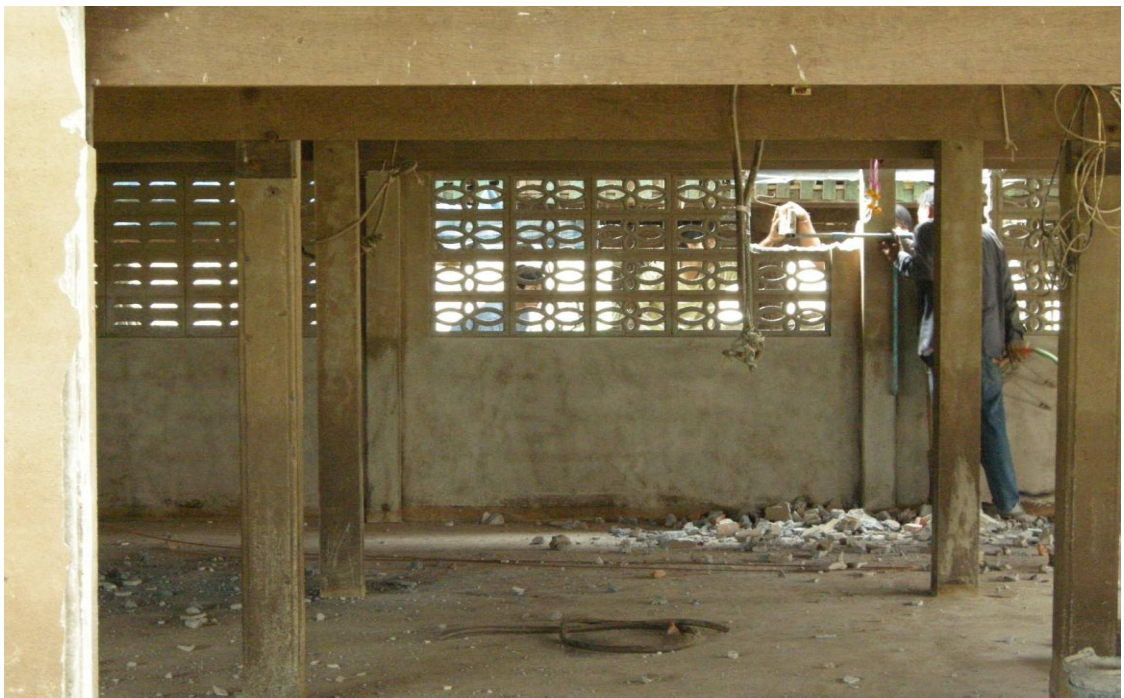
รูปที่ 4-13 การรื้อถอนกำแพงใต้ถุนบ้าน
