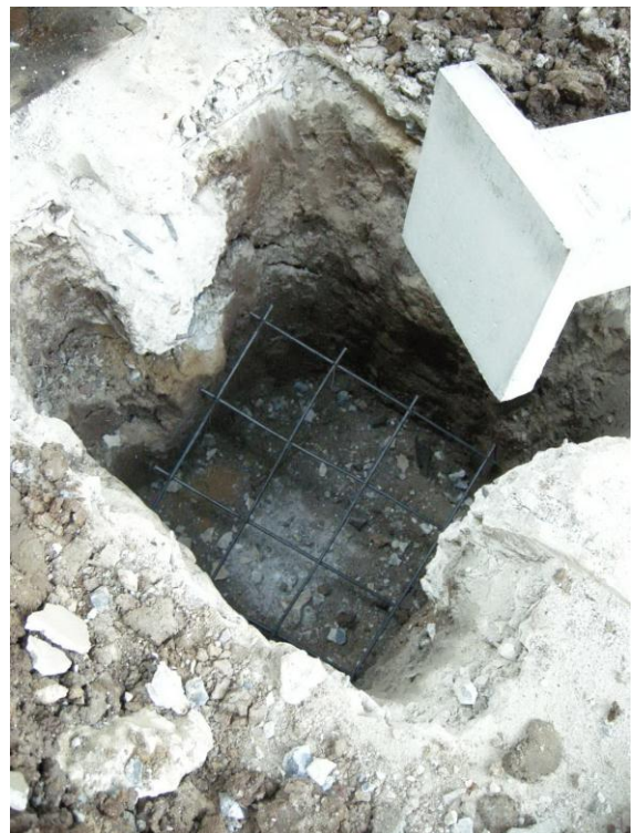
รูปที่ 4-61 การเตรียมหลุมวางเสาใหม่สำหรับหลุมที่มีฐานรากเดิม
