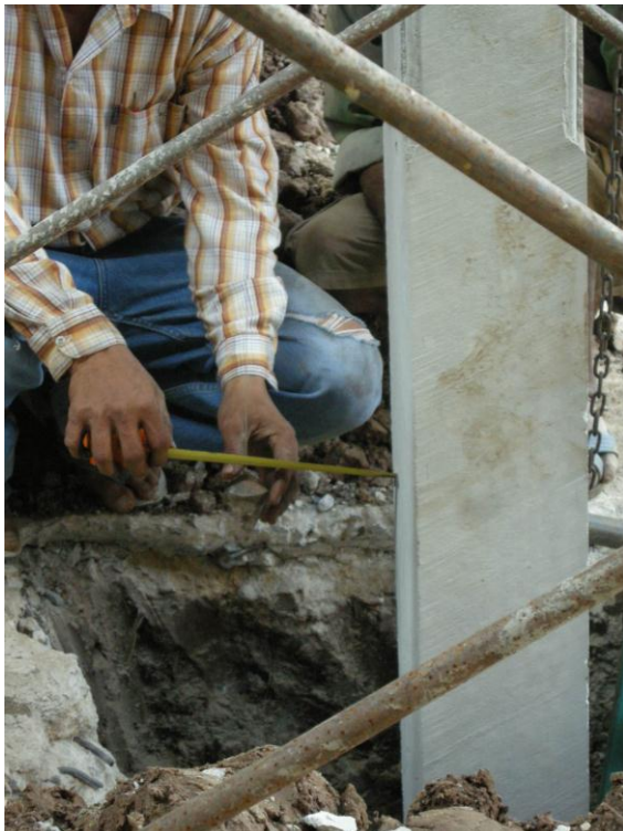
รูปที่ 4-65 ขั้นตอนการใส่เสาใหม่
