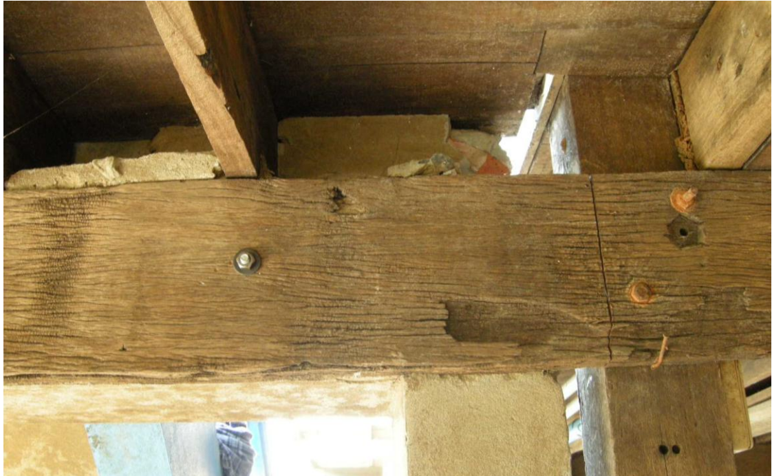
รูปที่ 4-19 การตัดคานของจัดการพื้นที่เชื่อมต่อ
