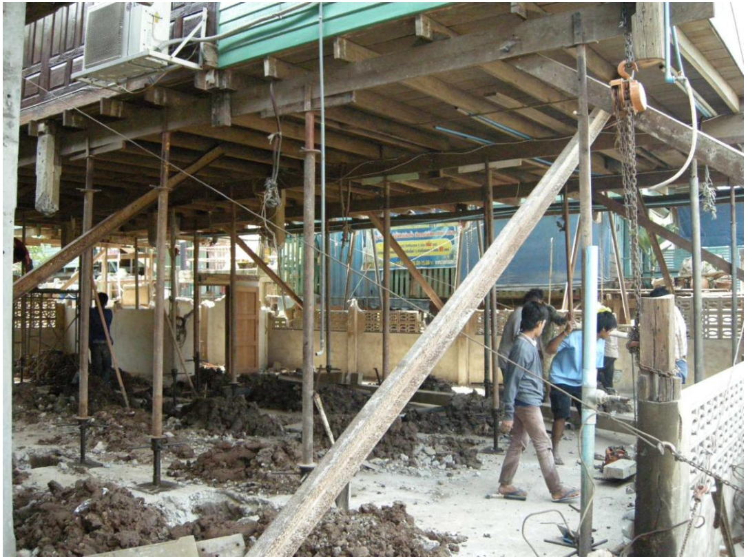
รูปที่ 1-3 ขั้นตอนในระหว่างการติดบ้าน
