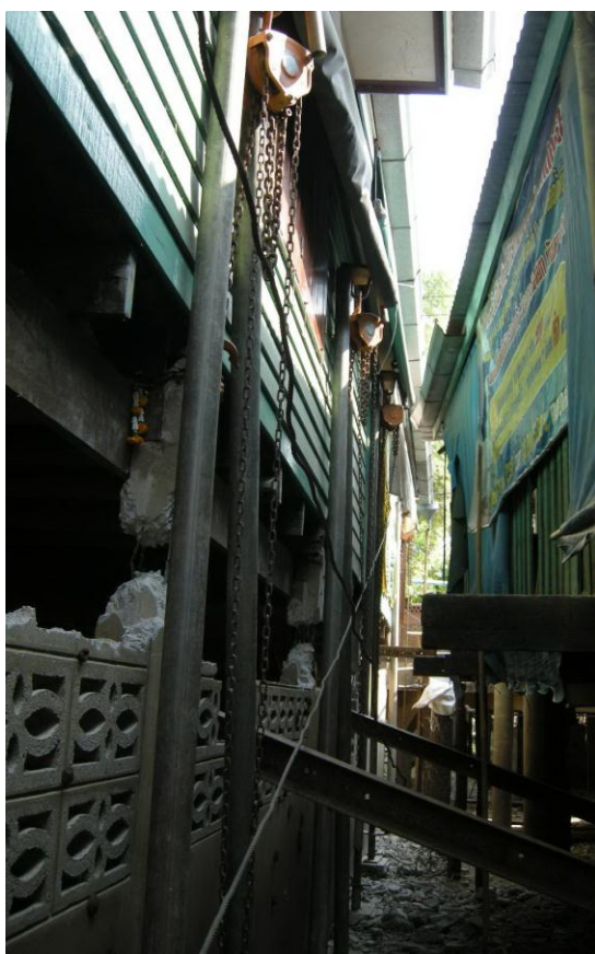
รูปที่ 4-38 การติดตั้งรอกยกบ้าน
