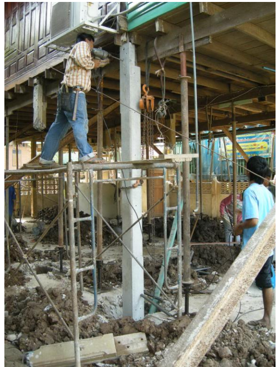
รูปที่ 4-65 ขั้นตอนการใส่เสาใหม่
