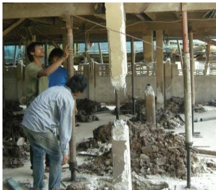
รูป 5-3 ภาพจำลองการรับแรงเกลียวของแม่แรง
