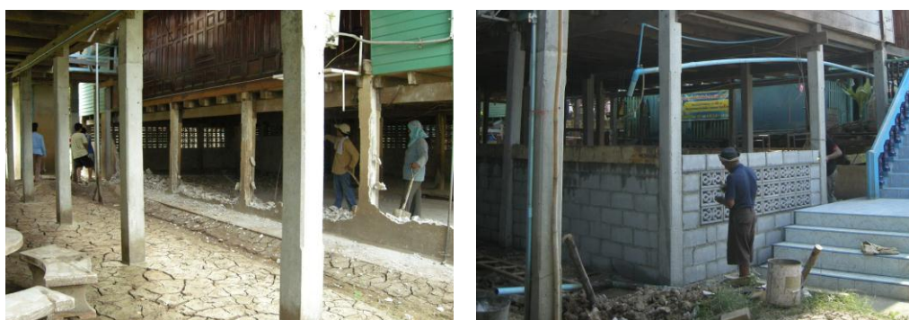
รูป 5-9 ภาพกำแพงก่อนและหลังการติดบ้าน
