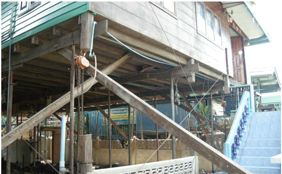
รูปที่ 4-55 การตรวจสอบรอยไขว้
