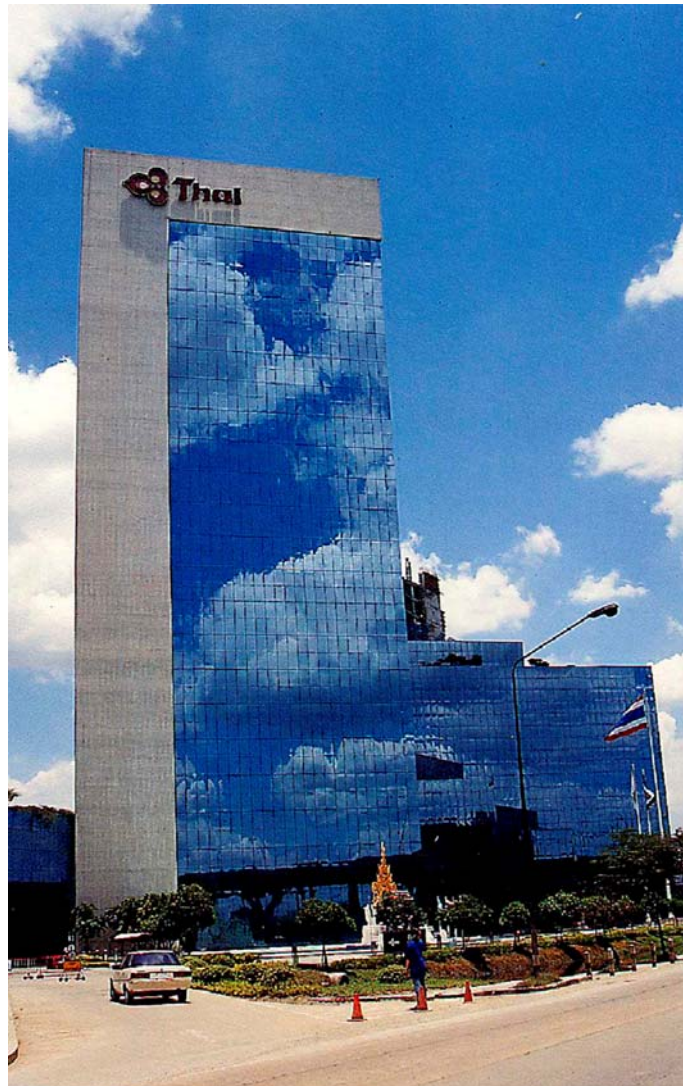
ภาพที่ 4.28 การใช้ 4-sided curtain wall ในอาคารสำนักงานใหญ่ บริษัทการบินไทย จำกัด ที่มา สถาปนิกสยาม เล่ม 2 หน้า 903
