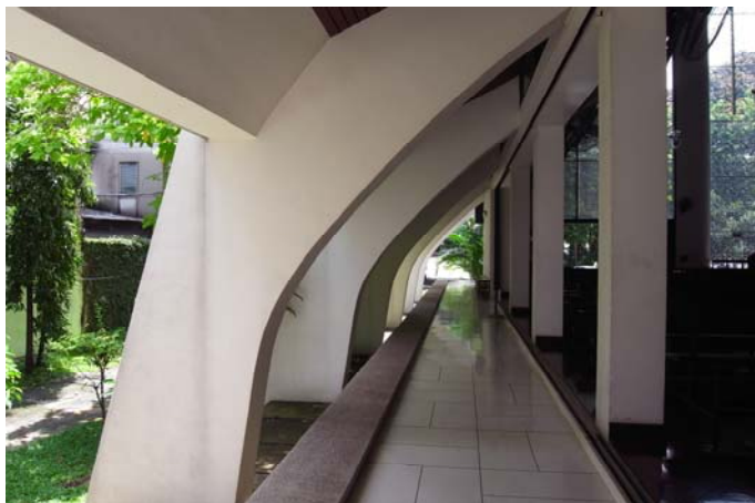
ภาพที่ 4.4 เสาอาคารที่โค้งต่อเนื่องลงมาจากหลังคาของโบสถ์เซเวียร์ ที่มา การสำรวจของผู้วิจัย, 29 กันยายน พ.ศ. 2553
