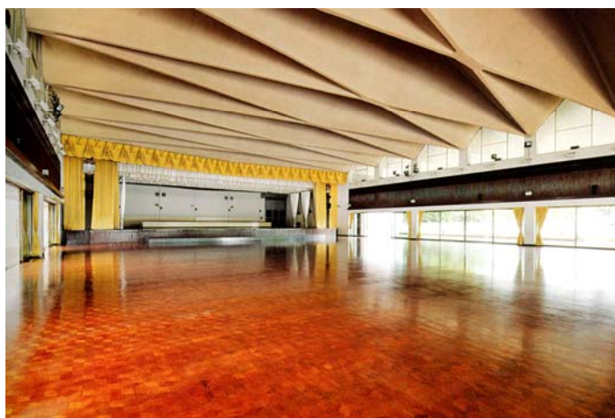
ภาพที่ 5.3 โถงภายในอาคารใหม่สวนอัมพร แสดงโครงสร้างหลังคาแผ่นพับจีบ
