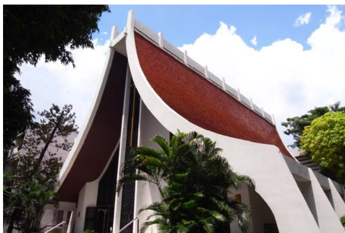
ภาพที่ 4.3 การประยุกต์ใช้หลังคาโค้งสูงคล้ายโบสถ์ไทยของโบสถ์เซเวียร์ ที่มา การสำรวจของผู้วิจัย, 29 กันยายน พ.ศ. 2553
