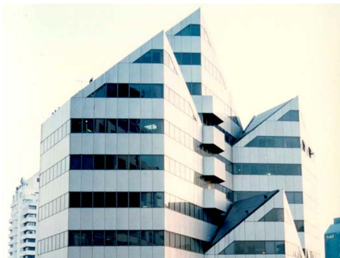
ภาพที่ 4.29 การสลับแถบทางนอนของกระจก และวัสดุแผ่นเบา
