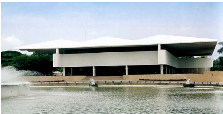
ภาพที่ 4.2 รูปทรงเฉียงของหลังคา อันเกิดจากโครงสร้างแผ่นพับจีบในอาคารใหม่ สวนอัมพร
