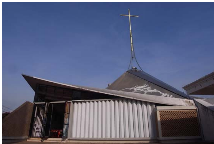
ภาพที่ 4.1 รูปทรงเฉียงและโค้งของหลังคา อันเกิดจากโครงสร้างไฮเพอร์โบลิก พาราโบลอยด์
