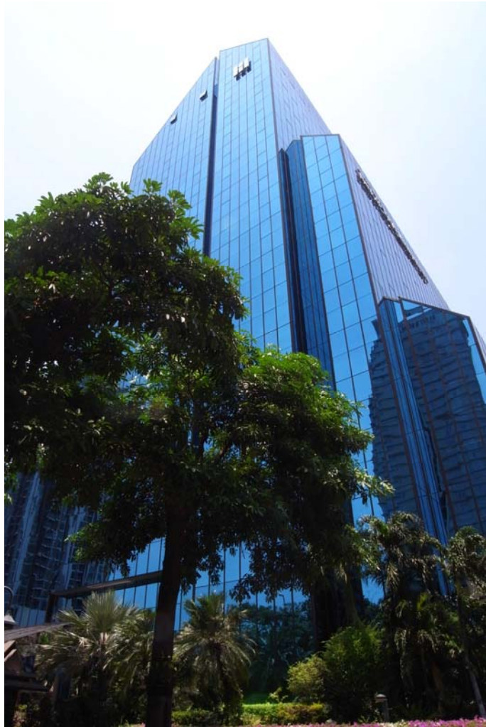
ภาพที่ 4.30 การใช้ผนังผืนกระจกขนาดใหญ่ คลุมทั้งอาคารในอาคารหะรินธร ที่มา การสำรวจของผู้วิจัย, 10 เมษายน พ.ศ. 2555
