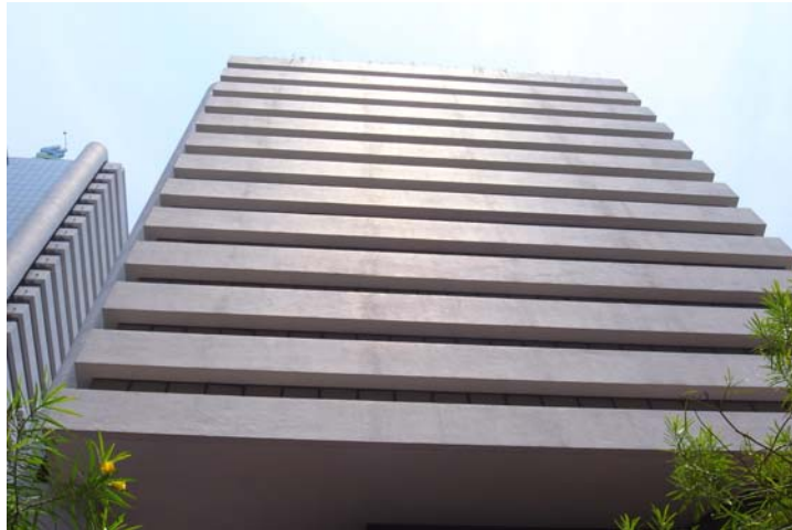
ภาพที่ 4.20 รูปแบบแถบทางนอนยื่นกันสาดน้อยในอาคารสาธารณะ ที่มา การสำรวจของผู้วิจัย, 10 เมษายน พ.ศ. 2555
