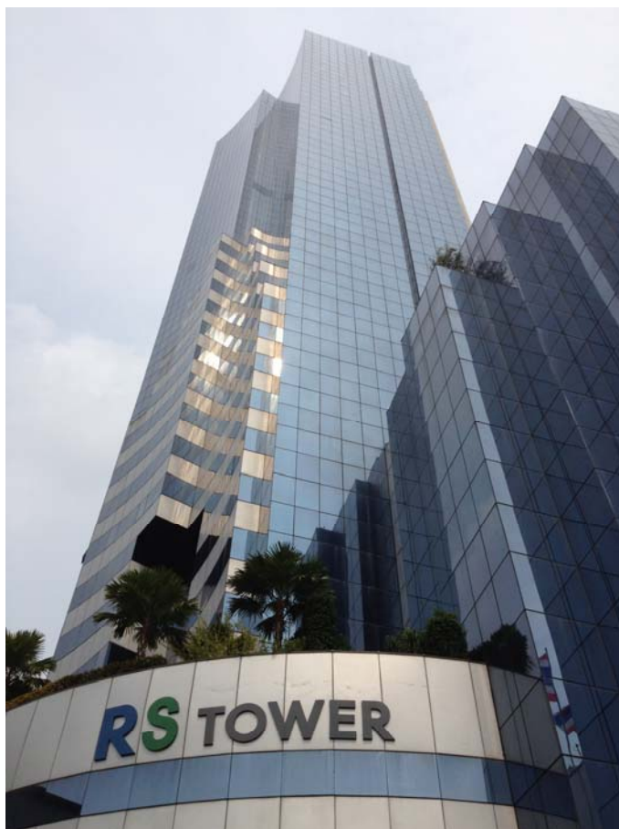
ภาพที่ 5.6 รูปแบบการใช้แผ่นอลูมิเนียมสลัดกับผนังกระจกในอาคารอาร์.เอส. ทาวเวอร์ ที่มา การสำรวจของผู้วิจัย, 26 มีนาคม พ.ศ. 2555
