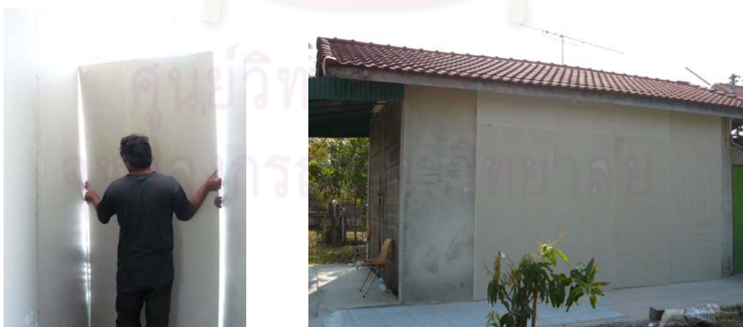
ภาพที่ 3.40 แสดงการเปลี่ยนผนังห้องทดลองเป็นผนังซีเมนต์บอร์ด
