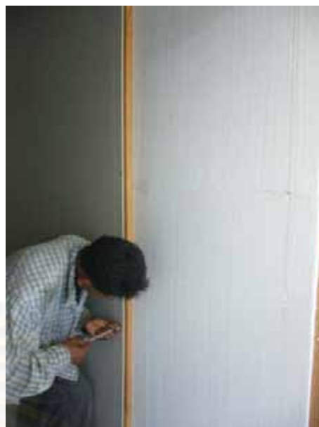
ภาพที่ 3.13 ผนังระหว่างห้องทดลองทุกห้องบุโฟมหนา 3 นิ้ว
