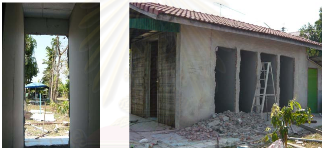
ภาพที่ 3.39 แสดงการเปลี่ยนผนังห้องทดลองเป็นผนังก่ออิฐฉาบปูน 2 ชั้น
