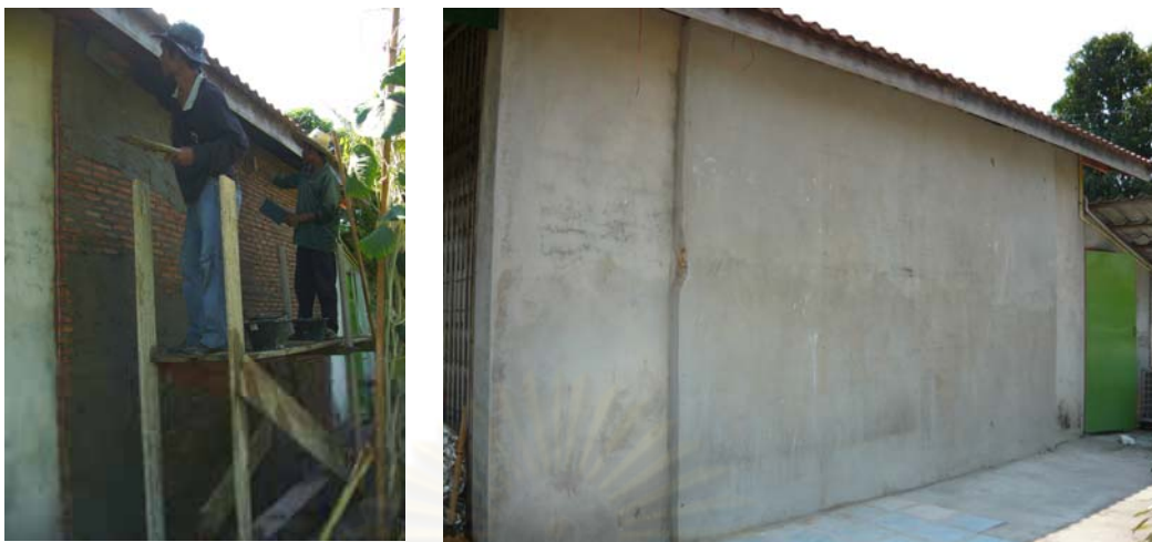
ภาพที่ 3.39 แสดงการเปลี่ยนผนังห้องทดลองเป็นผนังก่ออิฐฉาบปูน 2 ชั้น
