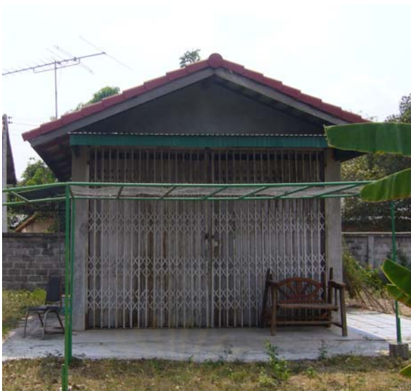
ภาพที่ 3.9 แสดงสภาพภายนอกอาคารที่ใช้ในการทดลอง
