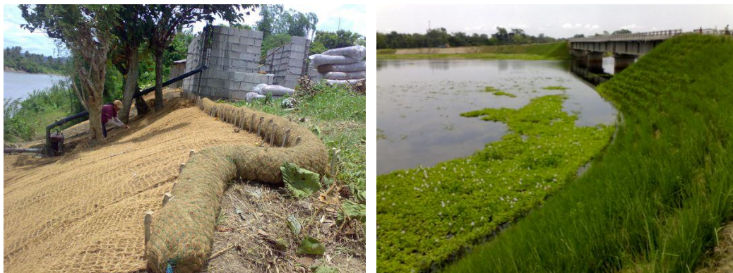
ภาพที่ 5-3 การใช้แผ่นใยสังเคราะห์ (Geotextile) ร่วมกับการปลูกหญ้าแฝก ที่มา: The Vetiver Network International ( http://www.vetiver.org )
