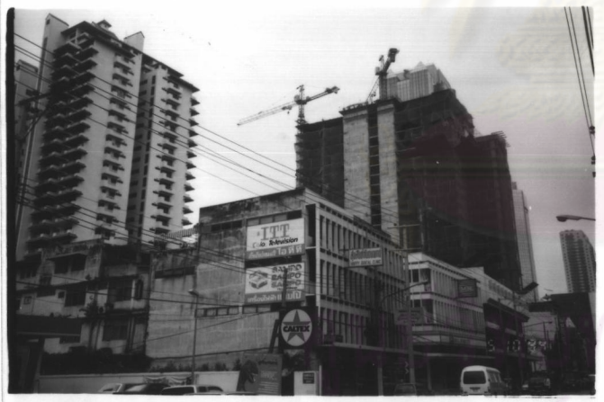
รูปที่ 4-7 สภาพอาคารบริเวณถนนอโศกและ อาคารสำนักงานก่อสร้างใหม่
