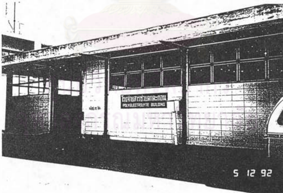
รูปที่ ก.14 โรงจ่ายสารช่วยตกตะกอน (POLYELECTROLYTE BUILDING)
