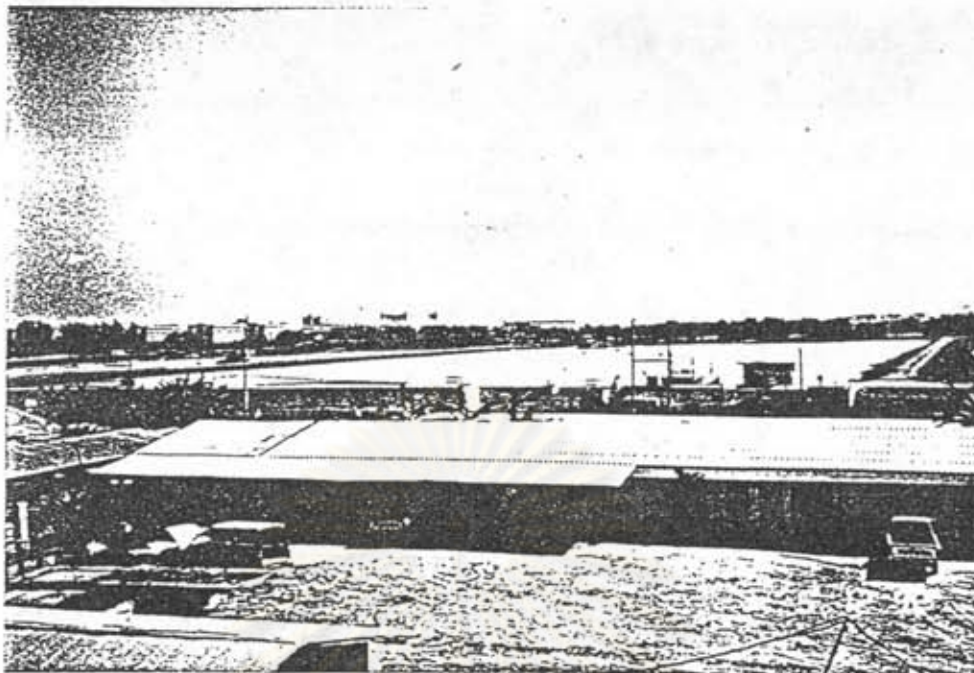
รูปที่ ก.23 แสดงบ่อกักและตากตะกอน (SLUDGE LAGOON)
