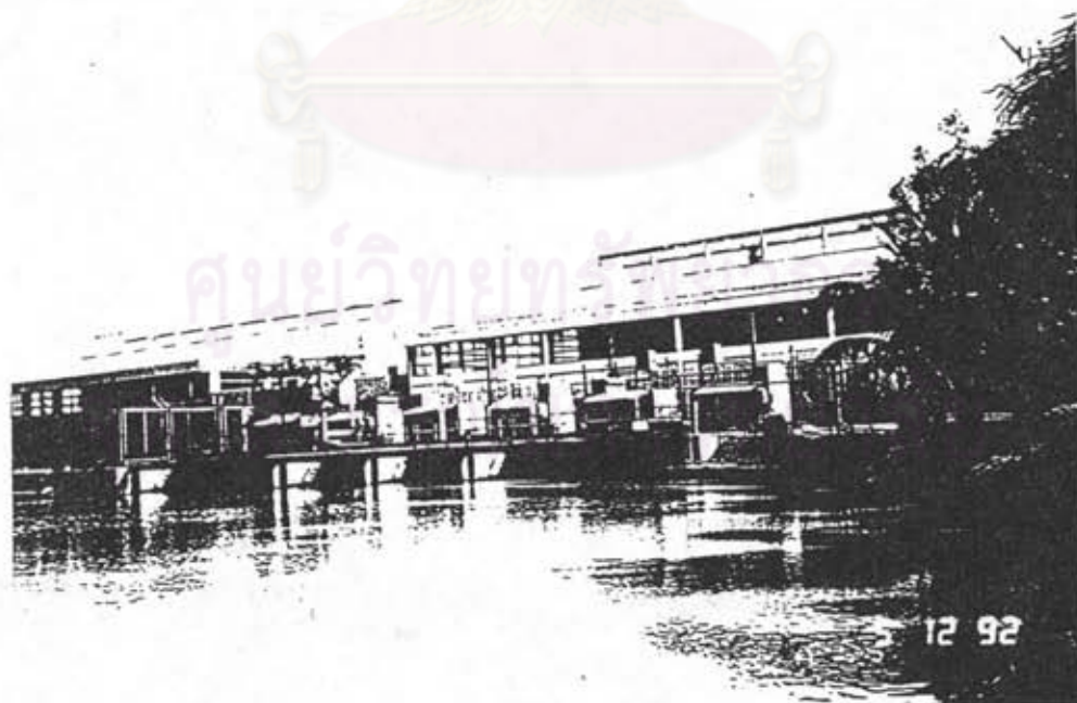
รูปที่ ก.4 บริเวณหน้าโรงสูบน้ำดิบ (RAW WATER INTAKE)
