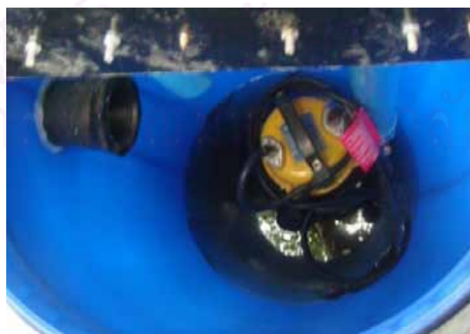
ภาพที่ 3.6 ถังเตรียมเศษอาหารและเครื่องสูบลม
