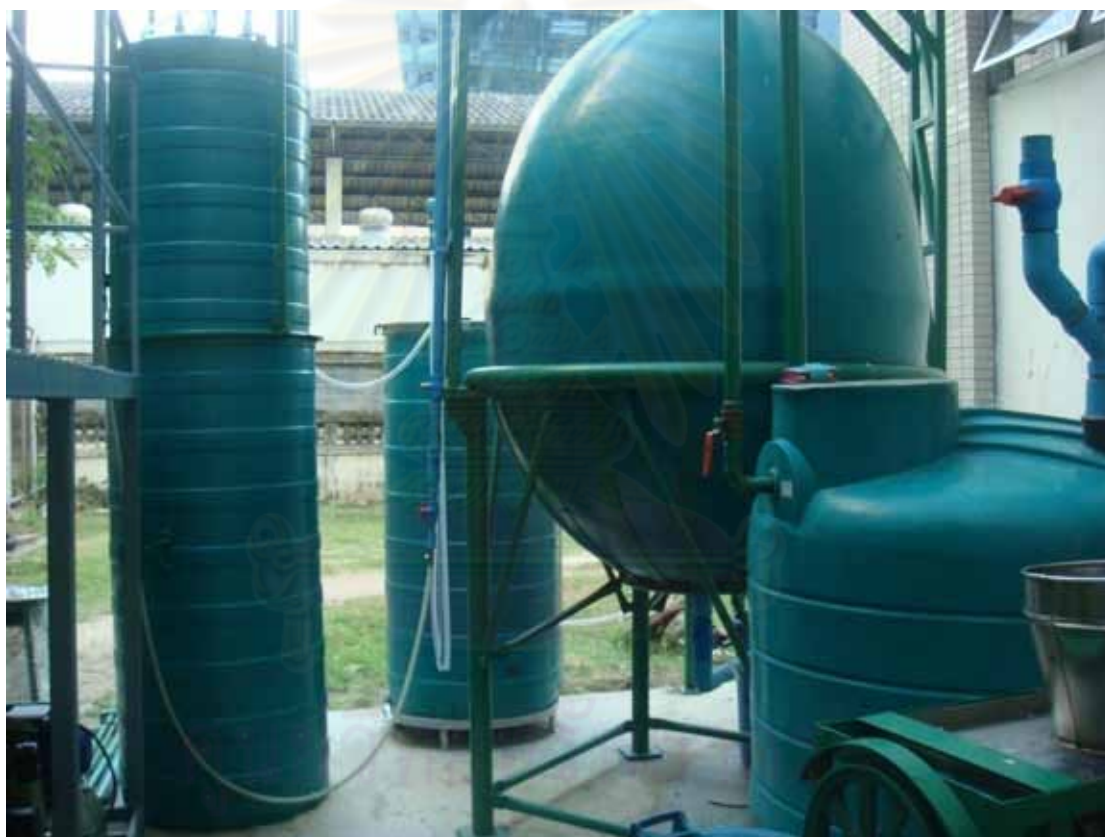
ภาพที่ 3.3 ระบบถังหมักภายใต้สภาวะไร้ออกซิเจนแบบสองขั้นตอน (two-stage anaerobic digestion) ในระดับภาคสนาม (ด้านหน้า)
