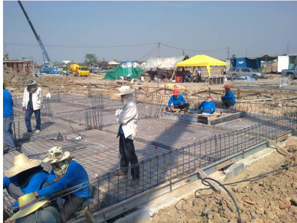
ภาพที่ 5-17 การผูกเหล็กคานและเสาค
