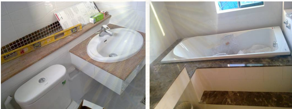
ภาพที่ 5-45 งานติดตั้งสุขภัณฑ์
