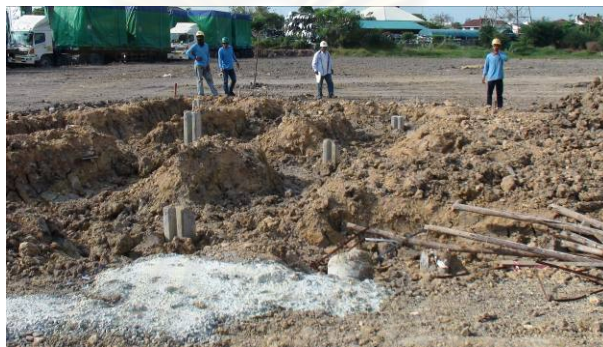
ภาพที่ 5-14 การเตรียมพื้นที่ฐานราก
