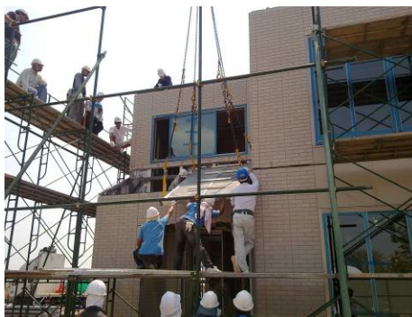
ภาพที่ 5-39 งานติดตั้งโครงหลังคา
