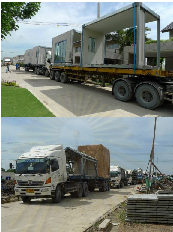
ภาพที่ 5-29 การใช้พื้นที่จอดรถเพื่อขนส่งชิ้นส่วนติดตั้ง
