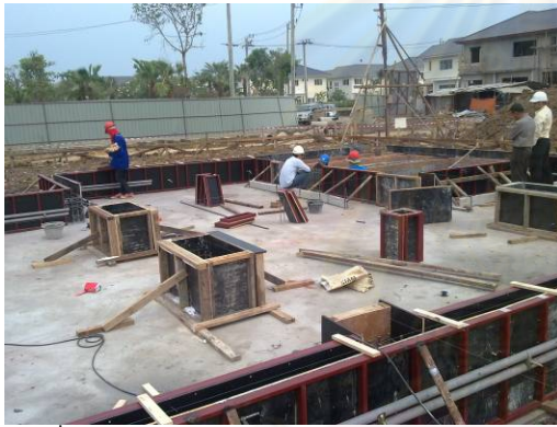
ภาพที่ 5-18 การเข้าแบบผูกเหล็กคานและเสาค
