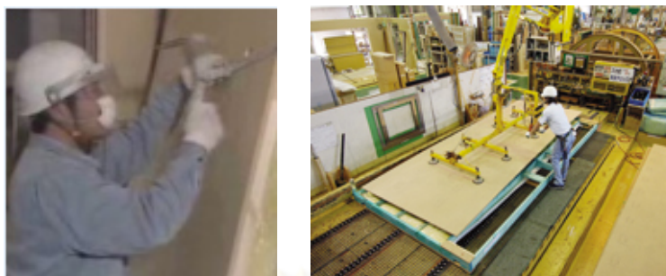
ภาพที่ 5-9 การติดตั้งผนังภายใน
