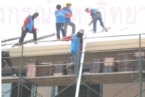
ภาพที่ 5-41 งานติดตั้งกระเบื้องหลังคา
