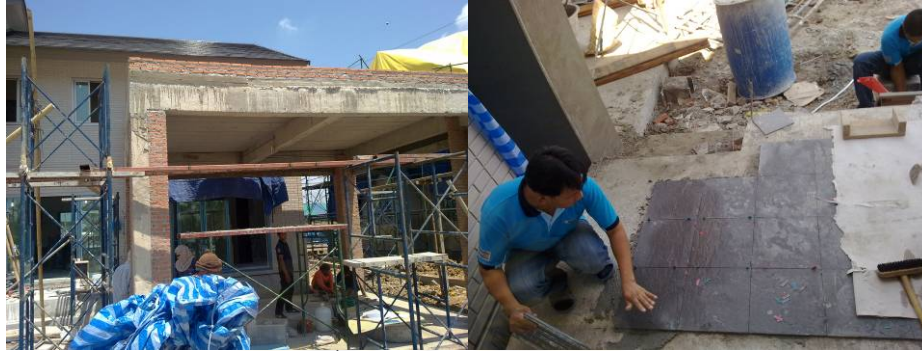
ภาพที่ 5-53 การก่อสร้างโรงจอดรถ
