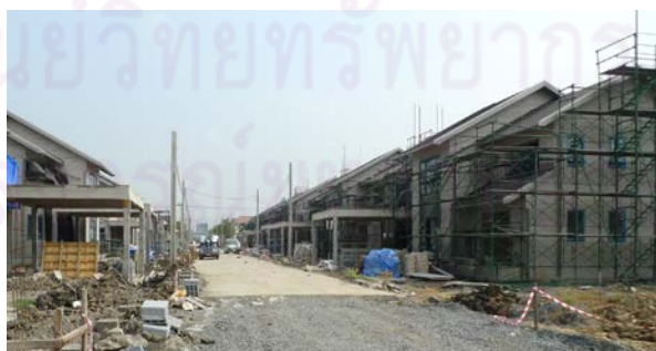
ภาพที่ 5-60 สภาพพื้นที่ก่อสร้างระบบโครงสร้างเสา-คานเหล็กสำเร็จรูป
