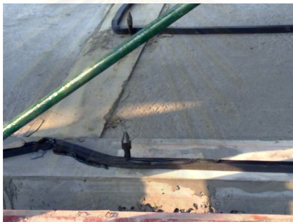
ภาพที่ 5-26 การติดตั้งยางรองพื้น
