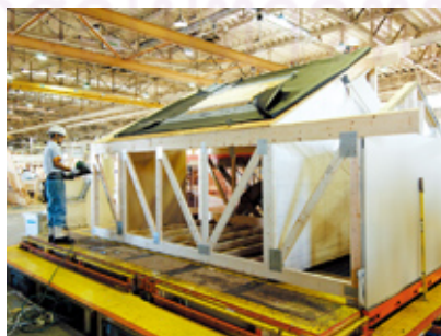
ภาพที่ 5-13 การประกอบโครงหลังคา
