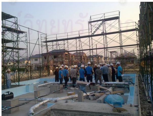
ภาพที่ 5-27 การอบรมเตรียมความพร้อมก่อนการติดตั้ง
