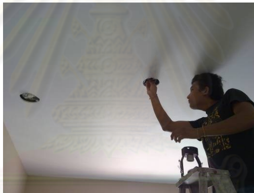
ภาพที่ 5-51 การติดตั้งดวงโคม
