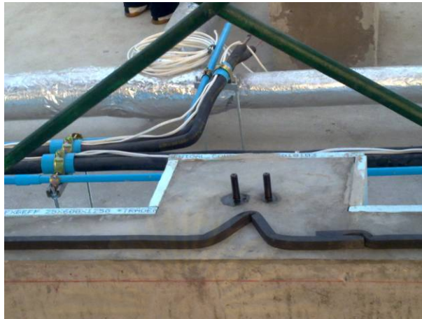
ภาพที่ 5-25 การติดตั้งยางรองพื้น
