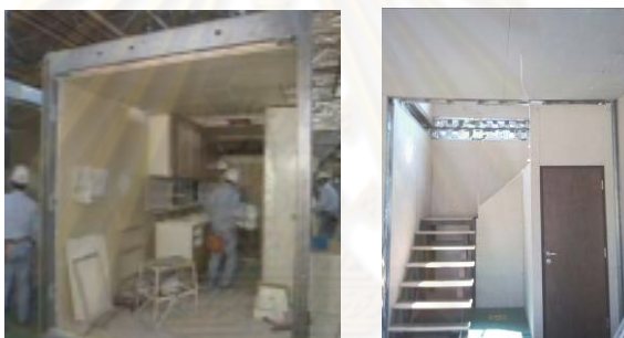
ภาพที่ 5-10 การติดตั้งอุปกรณ์และบันได
