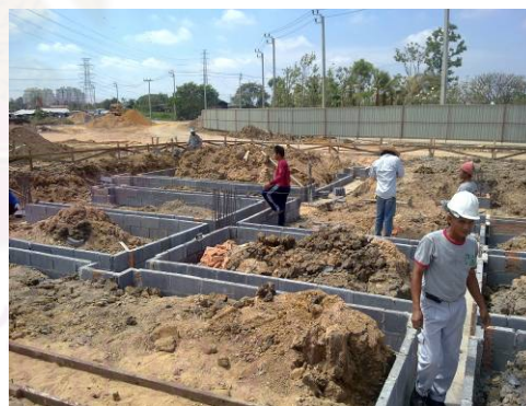
ภาพที่ 5-16 การตั้งแบบเพื่อเทคอนกรีตฐานรากและคาน
