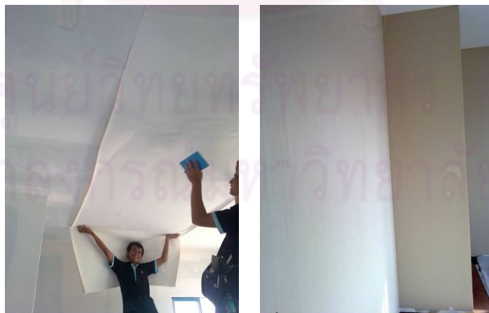
ภาพที่ 5-46 งานติดตั้งวอลเปเปอร์
