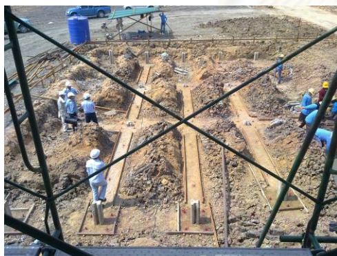
ภาพที่ 5-15 การปรับดินแนวคานและฐานราก
