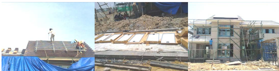
ภาพที่ 5-42 งานติดตั้งแผงโซลาร์เซลล์
