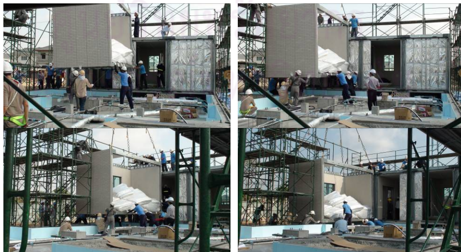
ภาพที่ 5-32 ขั้นตอนการวางชิ้นส่วน
