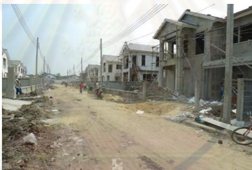
ภาพที่ 5-59 สภาพพื้นที่ก่อสร้างระบบเดิม
