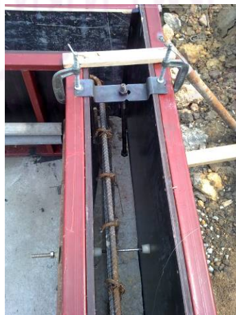
ภาพที่ 5-20 การติดตั้งสลักเกลียว
