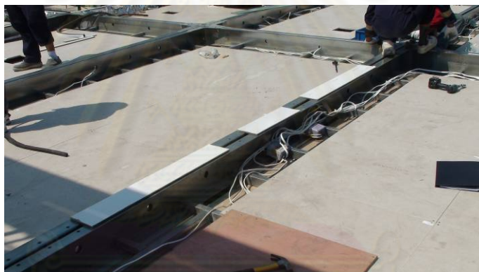
ภาพที่ 5-34 การเดินสายไฟก่อนติดตั้งชั้น 2
