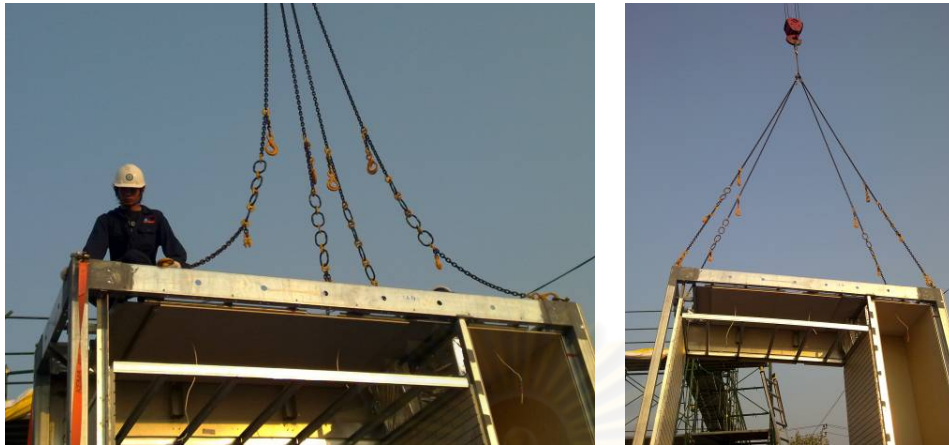
ภาพที่ 5-30 การใช้อุปกรณ์สำหรับยกชิ้นส่วน
