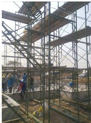
ภาพที่ 5-21 การติดตั้งนั่งร้าน
