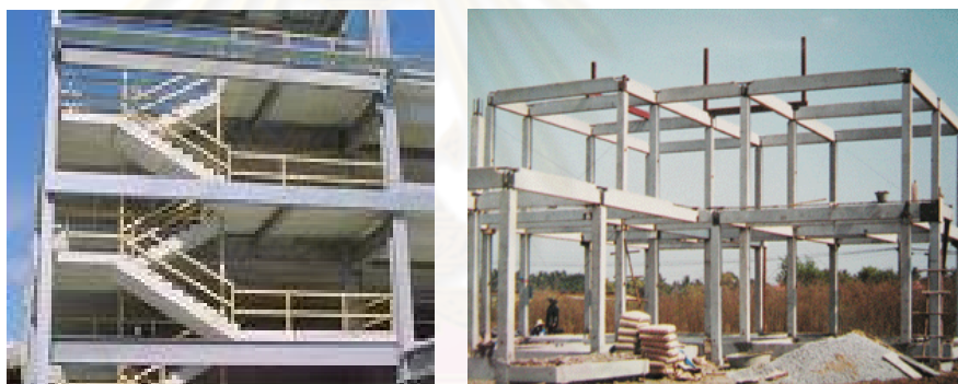
ภาพที่ 2-1 โครงสร้างเสา-คาน อาคารที่จอดรถและที่อยู่อาศัย
