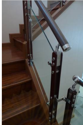
ภาพที่ 5-50 การติดตั้งไม้บันไดและราวจับ
