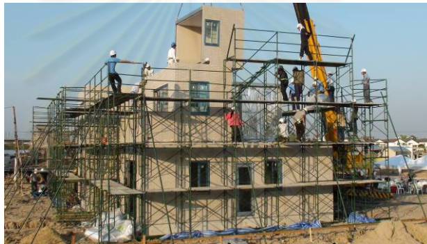
ภาพที่ 5-37 การติดตั้งโครงสร้าง ชั้น 2
