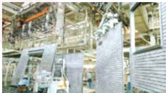
ภาพที่ 5-8 การติดตั้งผนังภายนอก
