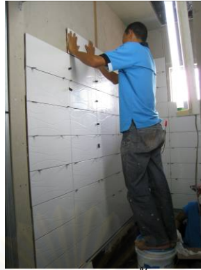
ภาพที่ 5-44 งานปูกระเบื้องผนังห้องน้ำ
