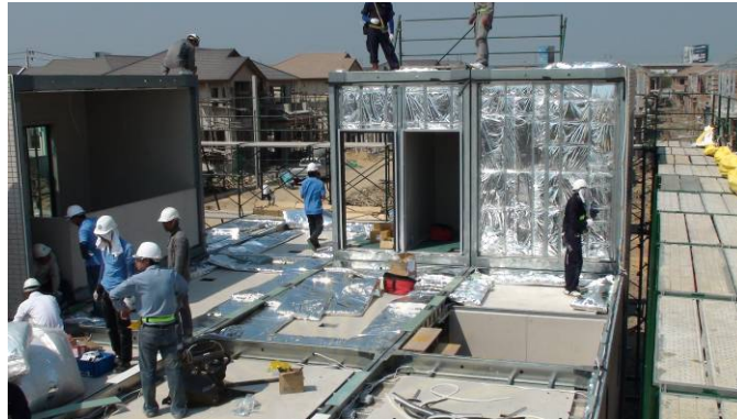
ภาพที่ 5-36 การติดตั้งโครงสร้าง ชั้น 2
