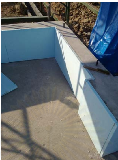
ภาพที่ 5-23 การติดตั้งแผ่นโฟมพอลิสไตรีน (Polystyrene Foam)
