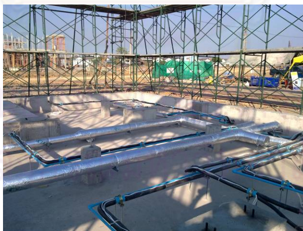
ภาพที่ 5-22 การติดตั้งระบบระบายอากาศ
