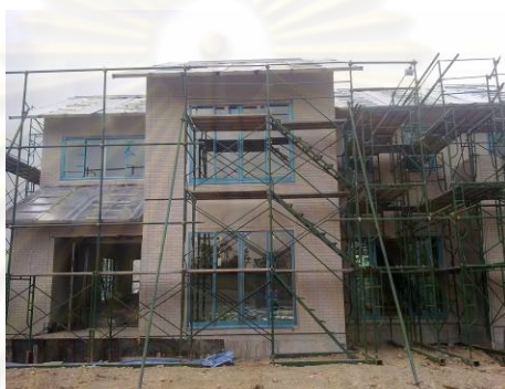
ภาพที่ 5-40 งานติดตั้งโครงสร้างแล้วเสร็จ
