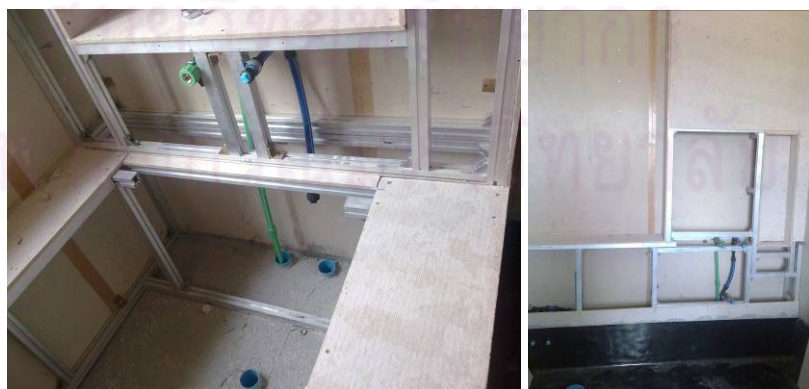
ภาพที่ 5-43 งานติดตั้งระบบประปา และสุขาภิบาล
