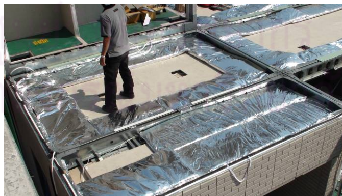
ภาพที่ 5-35 การปลูฉนวนกันความร้อน
