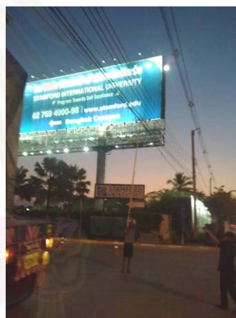
ภาพที่ 5-28 การใช้รถเทรลเลอร์ในการขนส่ง และการยกสายไฟให้พื้นรถเทรลเลอร์
