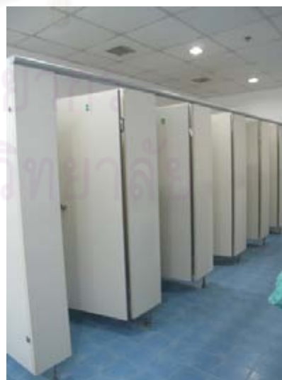
ภาพที่ 4.95 พื้น ผนัง ฝ้าเพดานห้องเปลี่ยนเสื้อผ้าบุคลากรและห้องน้ำของแต่ละแผนก
