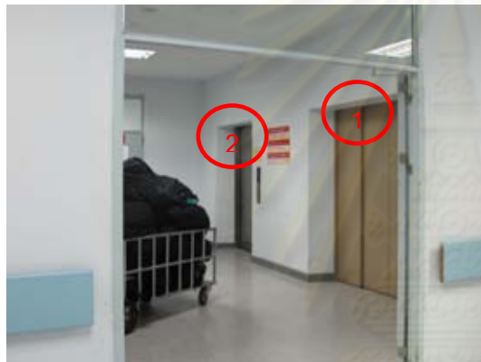
ภาพที่ 4.61 ลิฟท์ขนของสกปรก(1) และ ลิฟท์ขนของสะอาด(2) ขึ้น-ลงทุกชั้น
