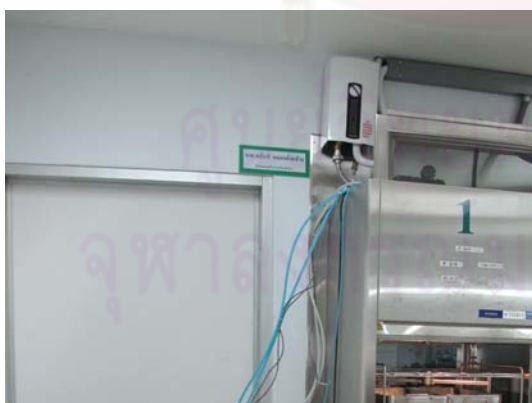
ภาพที่ 4.80 ผนังบริเวณเครื่องล้างอุปกรณ์ฯอัตโนมัติ
