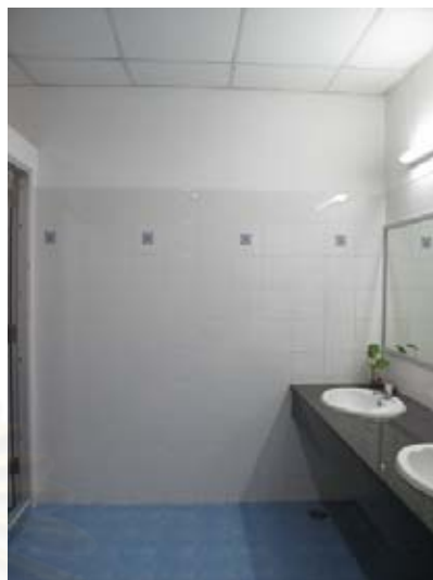
ภาพที่ 4.97 พื้น ผนัง ฝ้าเพดาน ห้องน้ำในห้องจัดเตรียม เครื่องมือผ่าตัด (TSSU)
