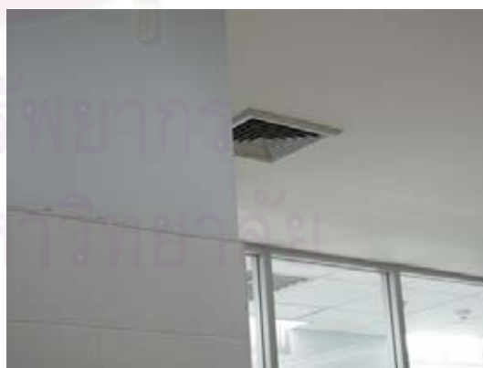
ภาพที่ 4.81 ฝ้าเพดาน ห้องล้างอุปกรณ์
