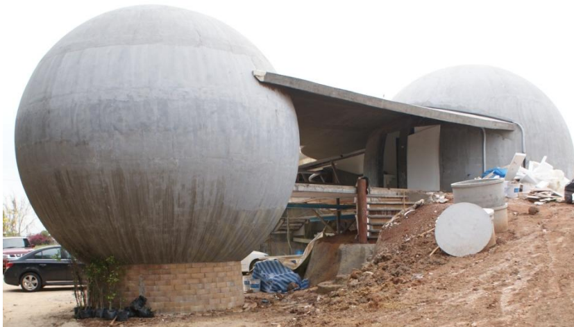
ภาพที่ 5-8 อาคารห้องน้ำทำจากวัสดุประเภทโฟม
