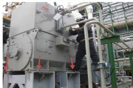
ค่า Torque bolt ปกติ ทั้ง 3 ด้านของ Motor
