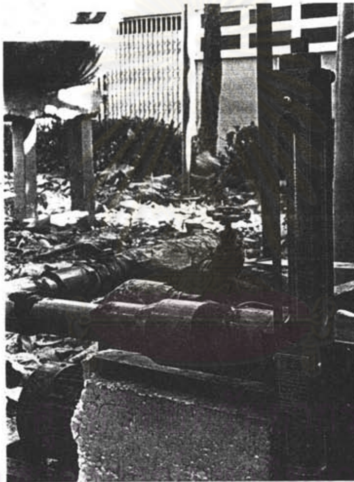
รูปที่ 4.14 Flow Cellmeter และท่อบายพาส ที่ใช้วัด และ ปรับอัตราการไหลของน้ำที่เข้าหอผึ่งน้ำ
