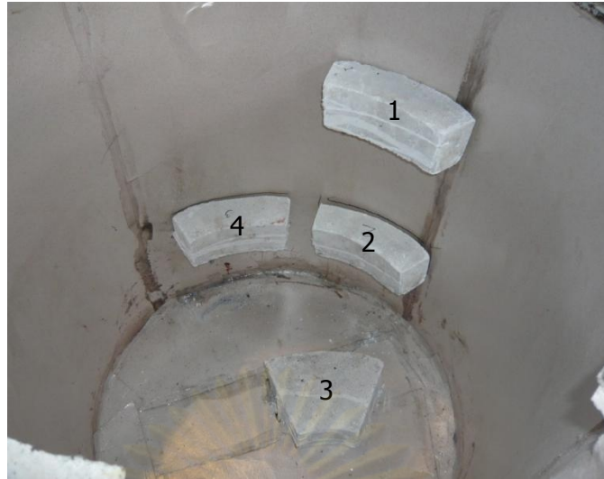
รูปที่ 4.14 การติดตั้งแท่งวัสดุทนไฟเข้ากับผนังภายในของตัวถังเหล็กก่อนการก่อวัสดุทนไฟ
