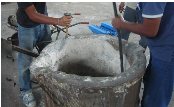
รูปที่ 4.10 การรื้อผนังเบ้ารับน้ำเหล็กเดิมออกเพื่อก่อผนังเบ้ารับน้ำเหล็กใหม่
