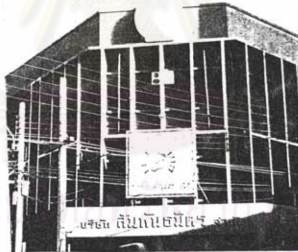
รูปภาพที่ 64 ใช้กระจกปาก้วของอาคารที่ตรงกับหม้อแปลงไฟฟ้า
