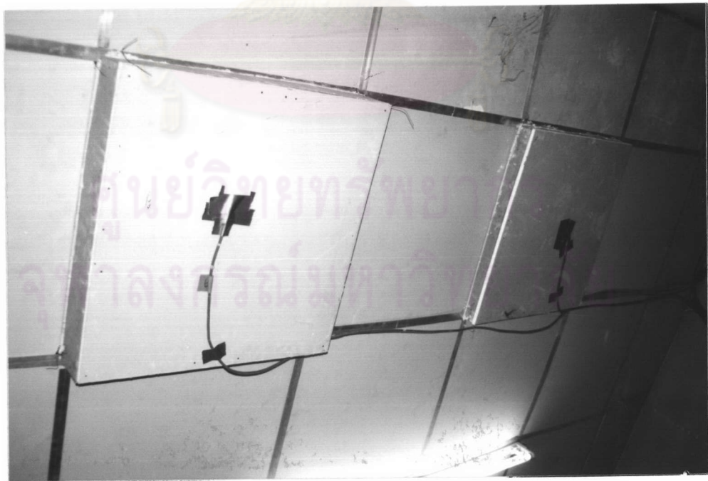
รูปที่ 35 แสดงการติดตั้งสาย Thermo Couple Type "J" ที่ฉนวนวัสดุ
