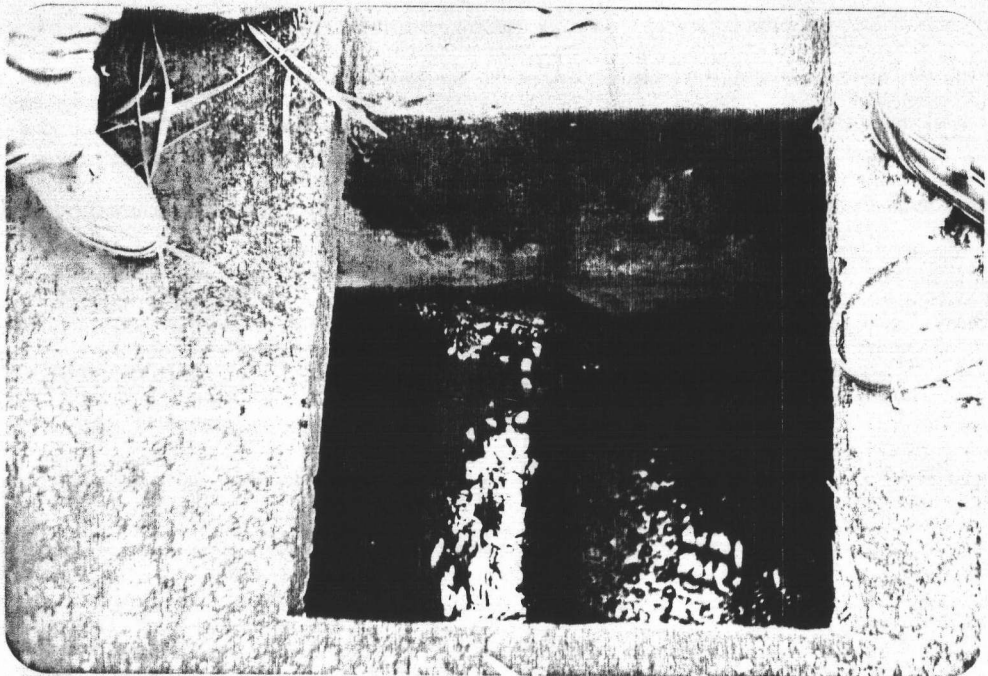
ภาพที่ 4.69 แสดงการไหลของน้ำดิบ เข้ามายังถังกรวดกรองของการประปาบ้านเพี้ย
