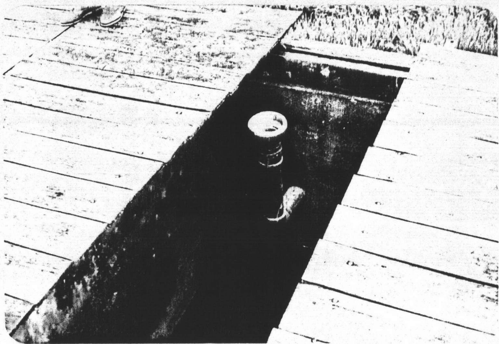
ภาพที่ 4.66 สภาพของดังกรองของการประปาบ้านปวนทุ ซึ่งมีฝาปิดบนรางเลื่อนและที่เห็น เป็นท่อน้ำล้น
