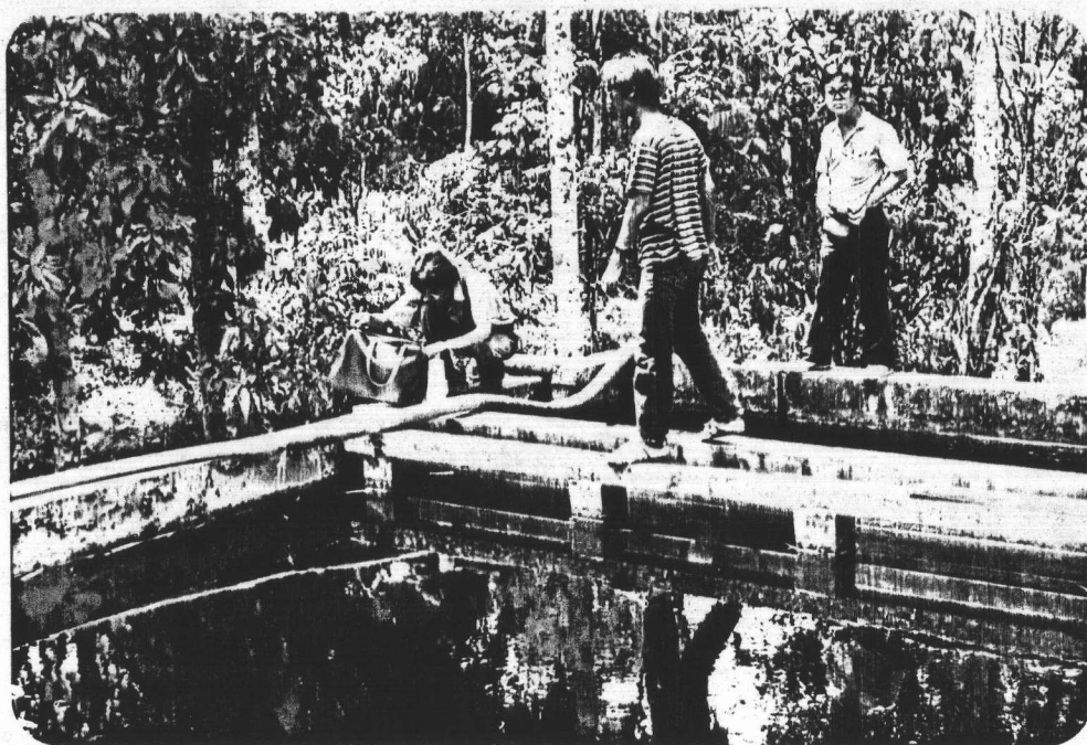
ภาพที่ 4.9 สภาพภายในถังกรองการประปาบ้านในเขี้ยว ซึ่งกำลังใช้งานตามปกติ
