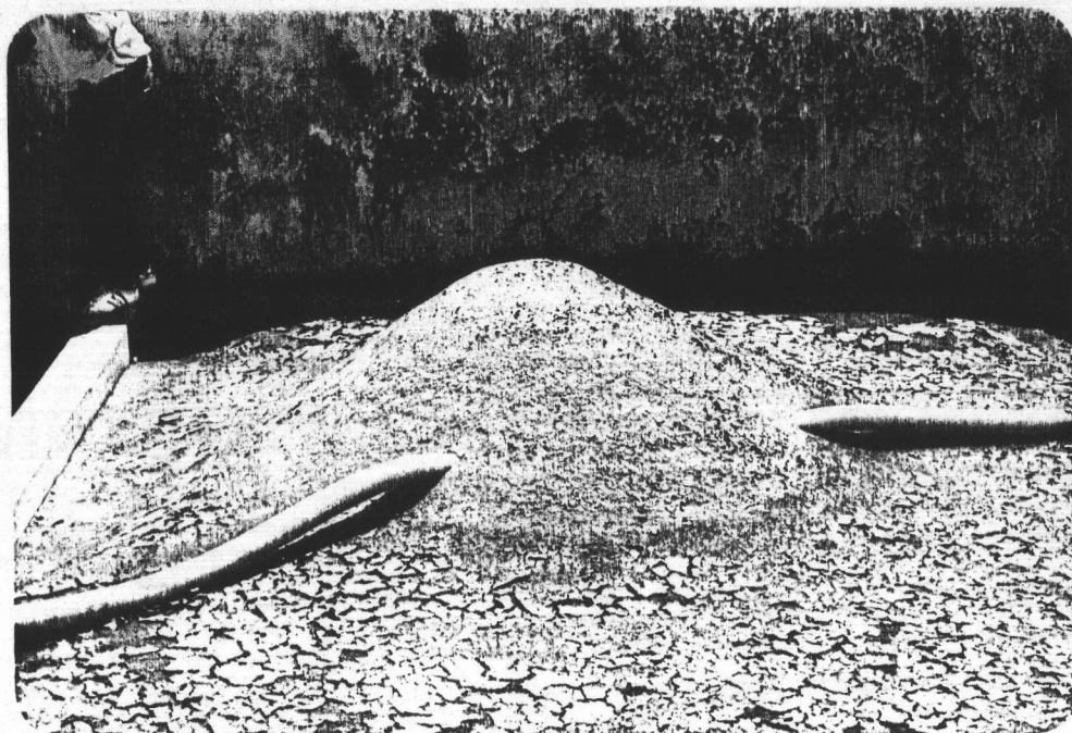
ภาพที่ 4.3 สภาพภายในถึงกรองของการประปาบ้านราชกรุง ซึ่งหยุดการกรองน้ำมาเป็นเวลาหลายวัน จะเห็นทรายที่ตักมาจากผิวหน้ามากองไว้รอการล้างทำความสะอาด
