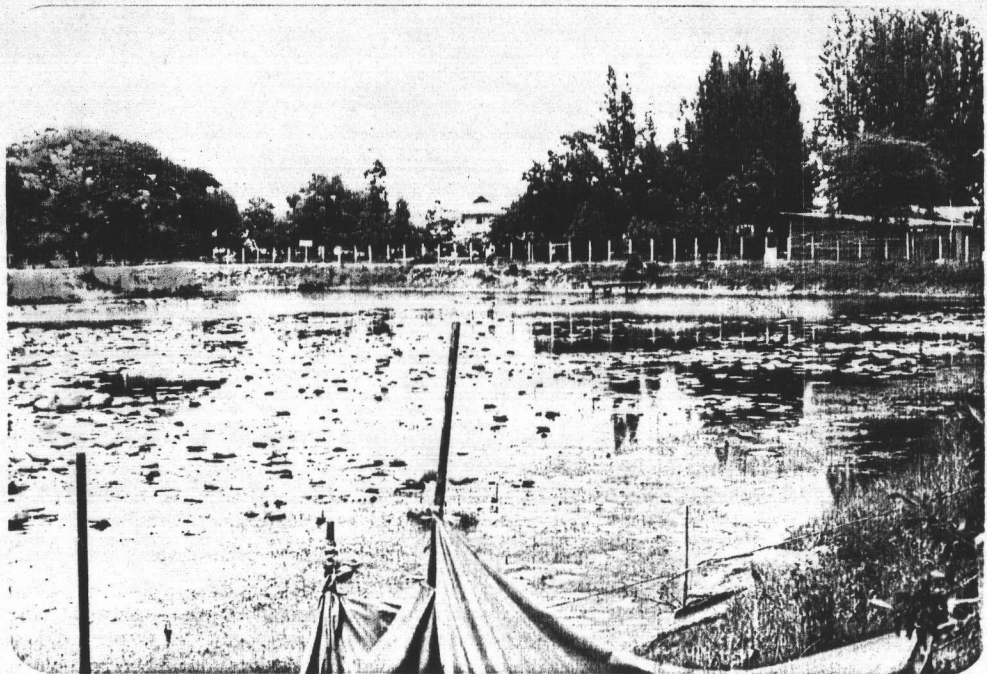
ภาพที่ 4.57 สภาพโดยทั่วไปของสระพักน้ำดิบ การประปาสุขาภิบาลหนองโก ซึ่งทำหน้าที่เป็นบ่อดกตะกอนเบื้องต้น
