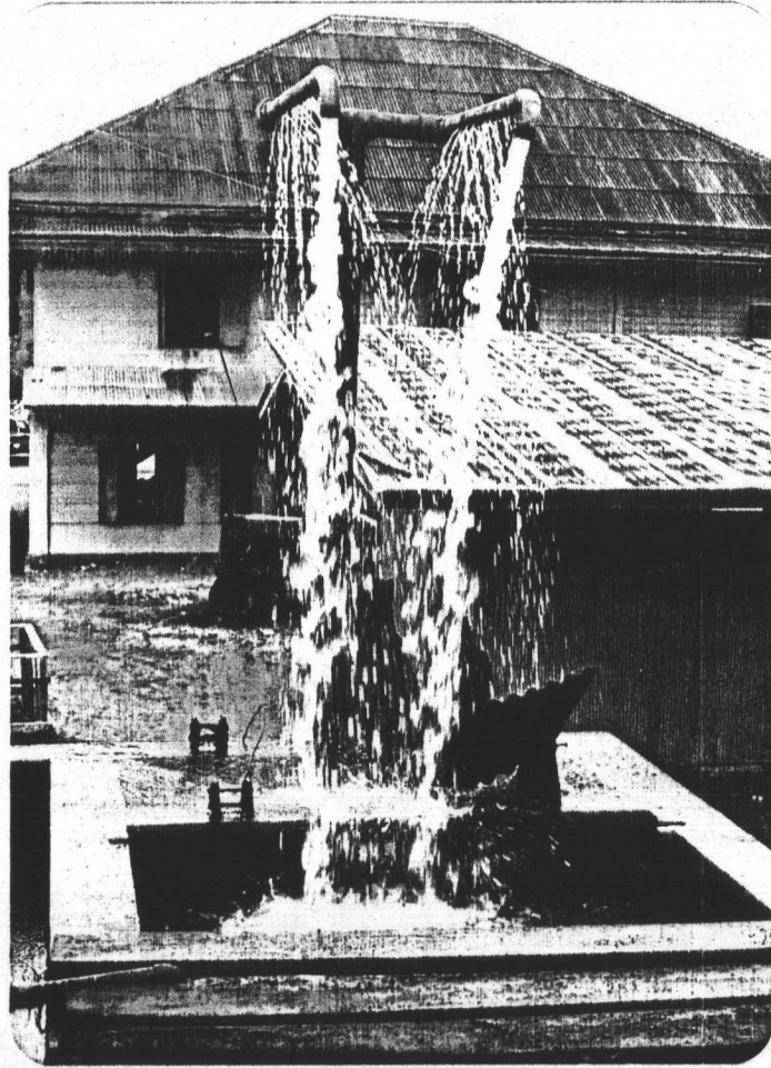
ภาพที่ 4.17 แสดงท่อน้ำเข้ามายังถังกรองของการประปาสุขาภิบาลยะรัง
