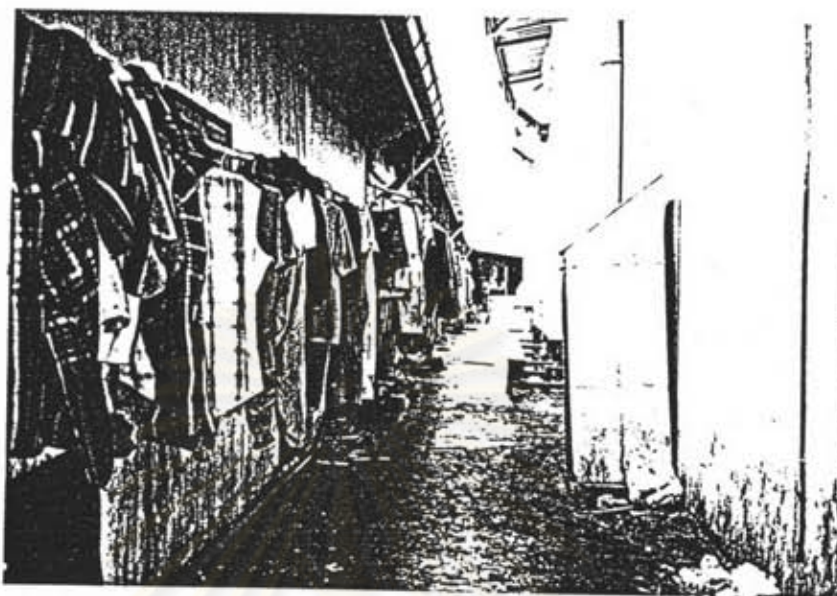
ภาพที่ 31 ลักษณะอาคารที่พักอาศัยเป็นห้องแถวอิฐ อยู่ด้านหลังโรงงาน ภายในบริเวณโรงงาน
