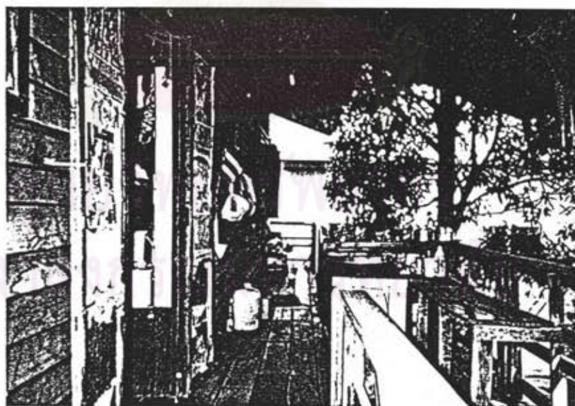
ภาพที่ 34 สภาพทางเดินเข้าห้องพัก ไม่มีกาบแบ่งสัดส่วนห้องพัก หนึ่งชั้น มีหนึ่งห้องพักอาศัย ทางเดินเป็นไม้กว้างประมาณ 2.00-2.50 เมตร
