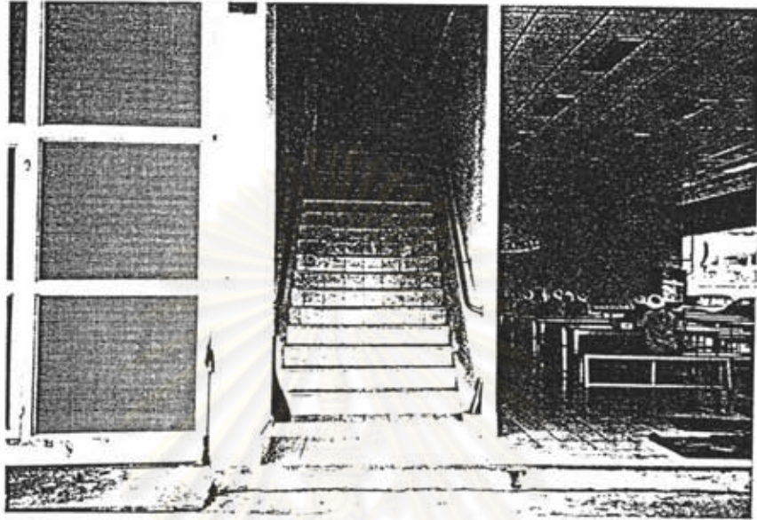
ภาพที่ 11 สภาพทางขึ้นลงที่พักอาศัย กว้างประมาณ 2-2.50 เมตร ปูด้วยกระเบื้องเซรามิค ที่พักอาศัยจัดไว้ชั้นบนอาคารโรงงาน
