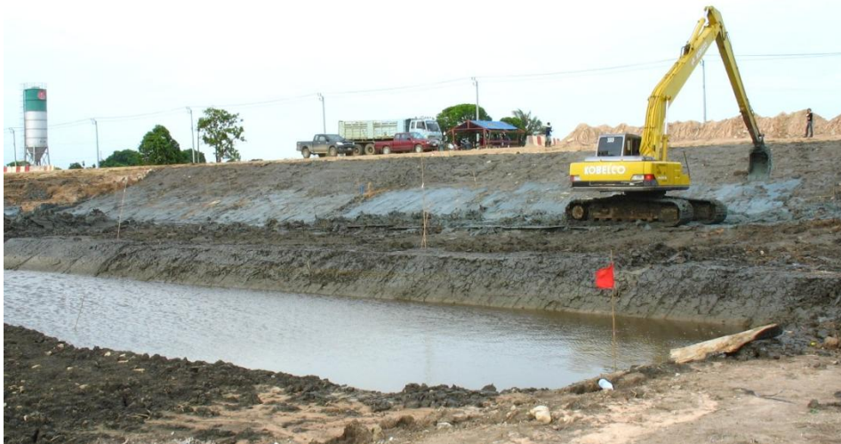
ภาพที่ ก.๑ แสดงขุดลอกดินบริเวณเชิงลาดคลอง ขั้นตอนที่ 4
