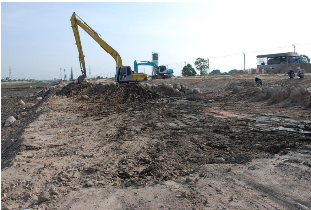
ภาพที่ ก.6 แสดงการตัดแต่งเชิงลาดบริเวณคันคลอง ขั้นตอนที่ 1-ข.
