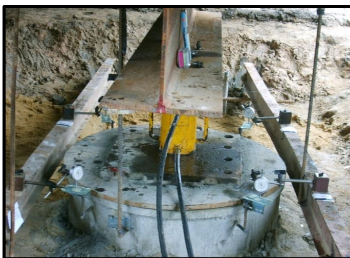
ภาพที่ 3.8 การทดสอบ Pile Load Test
