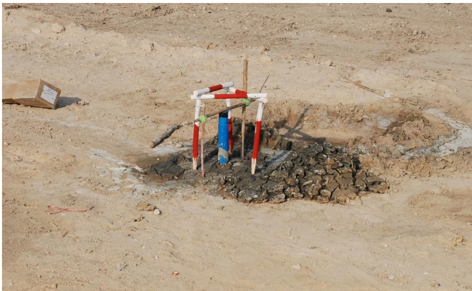
ภาพที่ ก.1 แสดงท่อตรวจวัดการเคลื่อนตัว (Inclinometer) ในแปลงทดลอง
