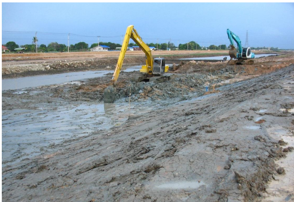
ภาพที่ ก.8 แสดงขุดลอกดินบริเวณเชิงลาดคลอง ขั้นตอนที่ 3
