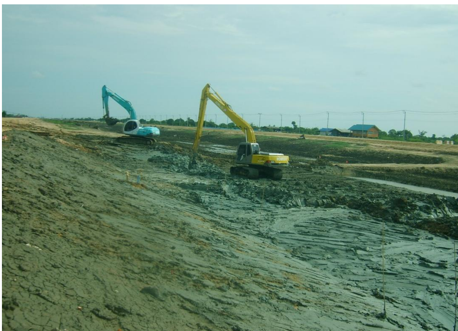
ภาพที่ ก.10 แสดงขุดลอกดินบริเวณเชิงลาดคลอง ขั้นตอนที่ 5
