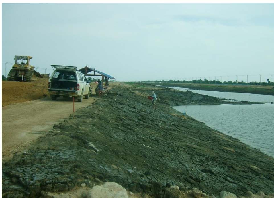
ภาพที่ ก.12 แสดงการปล่อยน้ำเข้าคลองระบายน้ำ ที่ระดับ -2.00 เมตร ชั้นตอนที่ 8
