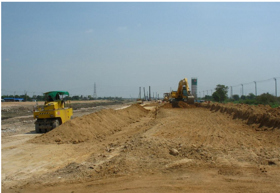
ภาพที่ ก.5 แสดงการถม บดอัดดินบริเวณชานคลอง ขั้นตอนที่ 1-ก.
