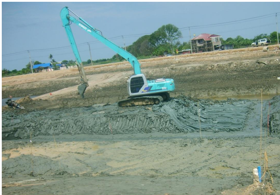
ภาพที่ ก.11 แสดงขุดลอกดินบริเวณเชิงลาดคลอง ชั้นตอนที่ 6
