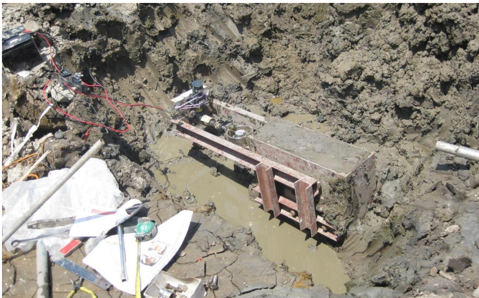
ภาพที่ ค.1 การติดตั้งกล่องทดสอบแบบจำลองแท่งดินซีเมนต์รับแรงทางด้านข้าง
