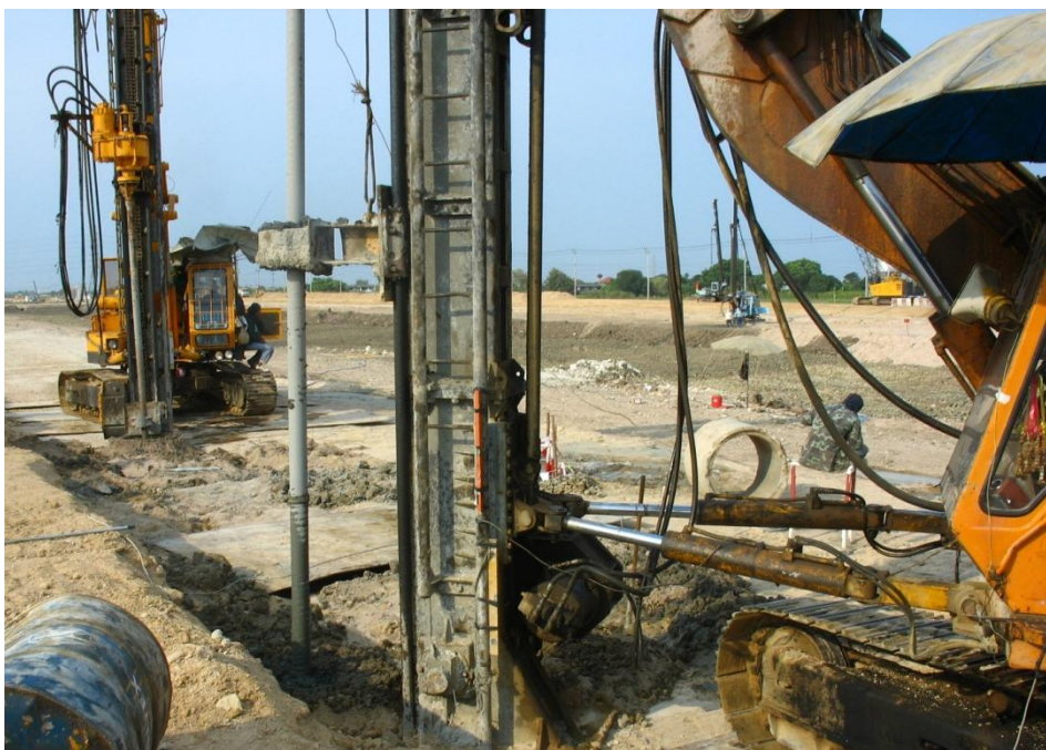
ภาพที่ ก.2 แสดงการก่อสร้างเสาเข็มดินซีเมนต์เพิ่มเติม ในส่วนของ SCC5 และ SCC6
