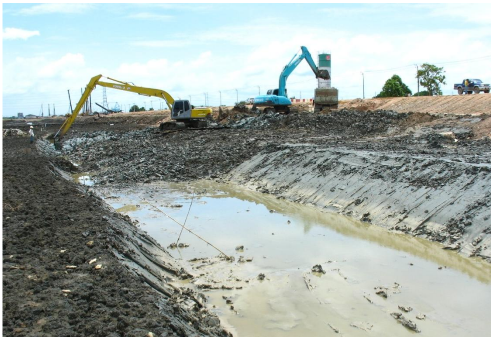
ภาพที่ ก.7 แสดงการลอกดินที่ระดับท้องคลองบริเวณแนวศูนย์กลางคลอง ขั้นตอนที่ 2
