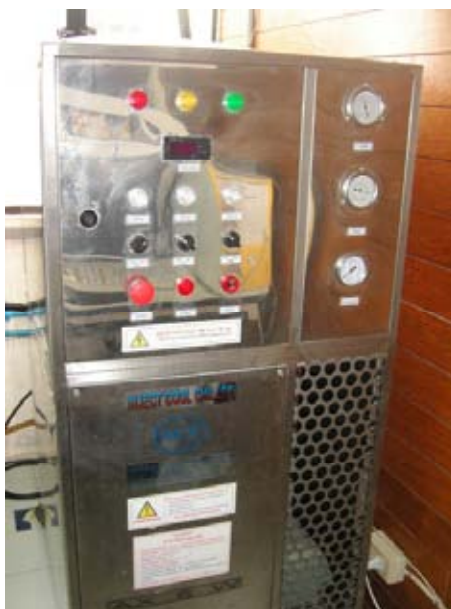
รูปที่ 4.12 เครื่องทำน้ำเย็น (Chilled Water Machine) [1]
