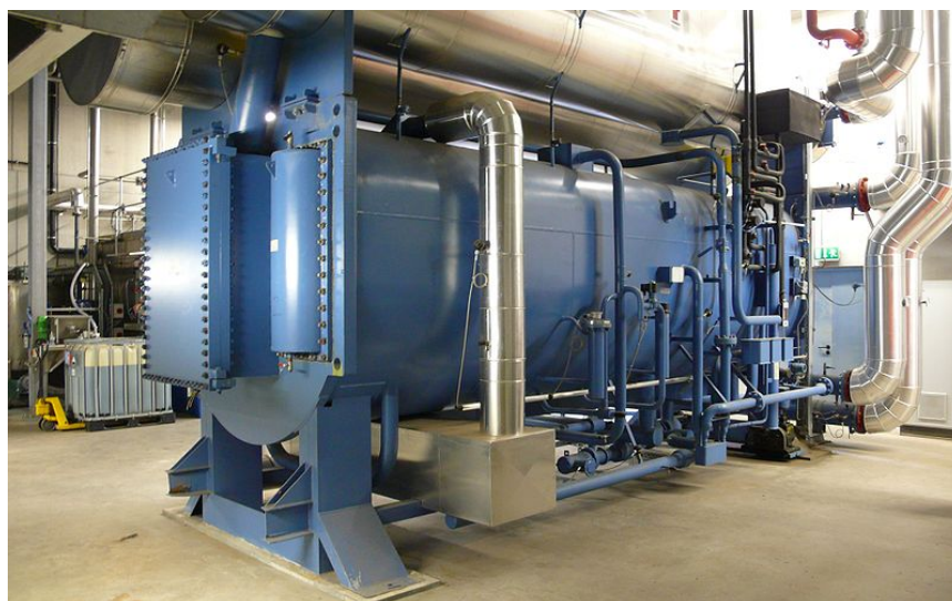
รูปที่ 2.3 ระบบป้อนความร้อนแบบ Absorption Heat Pump
