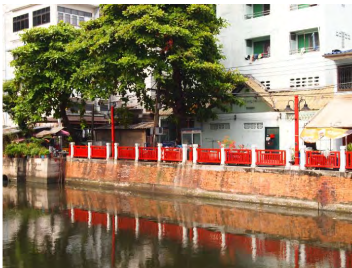
ภาพที่ 3.88 ภาพถ่ายตึ๊งบริเวณคลองบางลำภู (ที่มา : ผู้วิจัย 30 มกราคม 2556)
