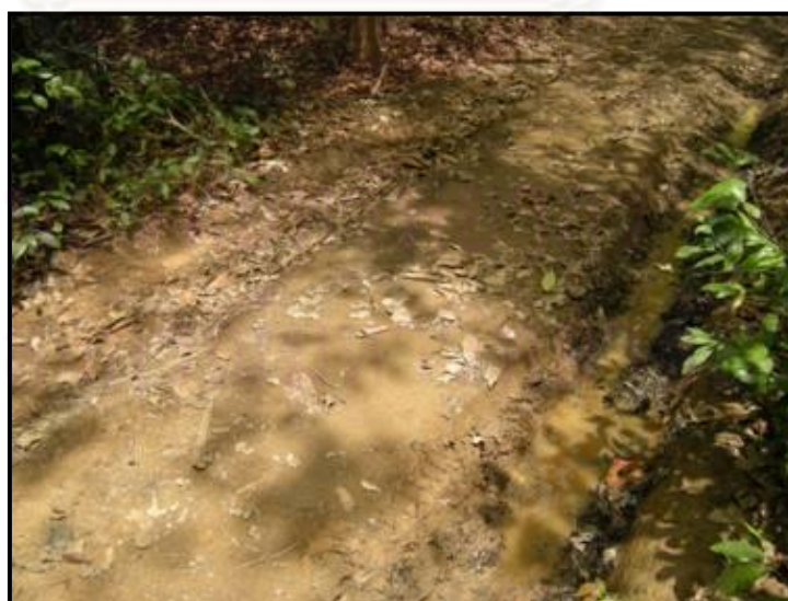
ภาพที่ 4-7 รอยล้อรถที่มีน้ำขังเมื่อฝนตกหนัก
