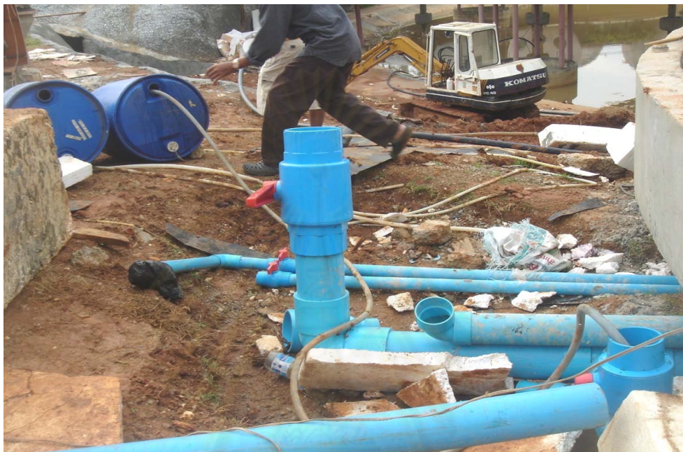
ภาพที่ 4-18 การเติมจุลินทรีย์จากบ่อบำบัด เข้าสู่ถังทดลอง ขนาด 200 ลิตร
