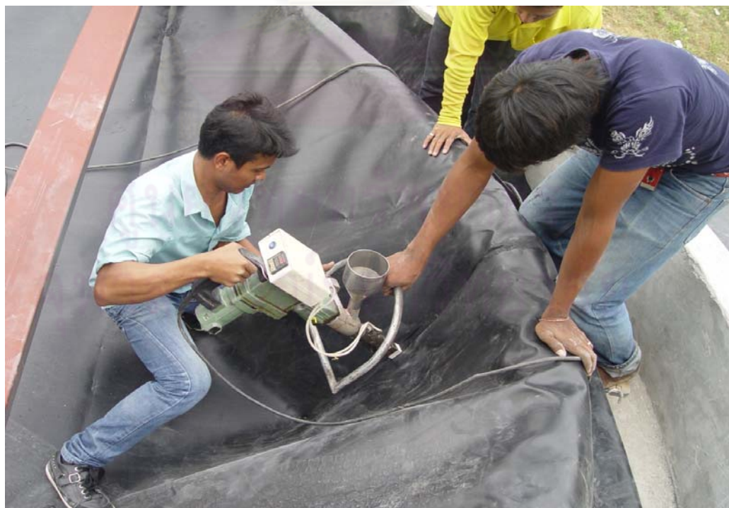
ภาพที่ 4-6 แสดงการเชื่อมพลาสติก HDPE
