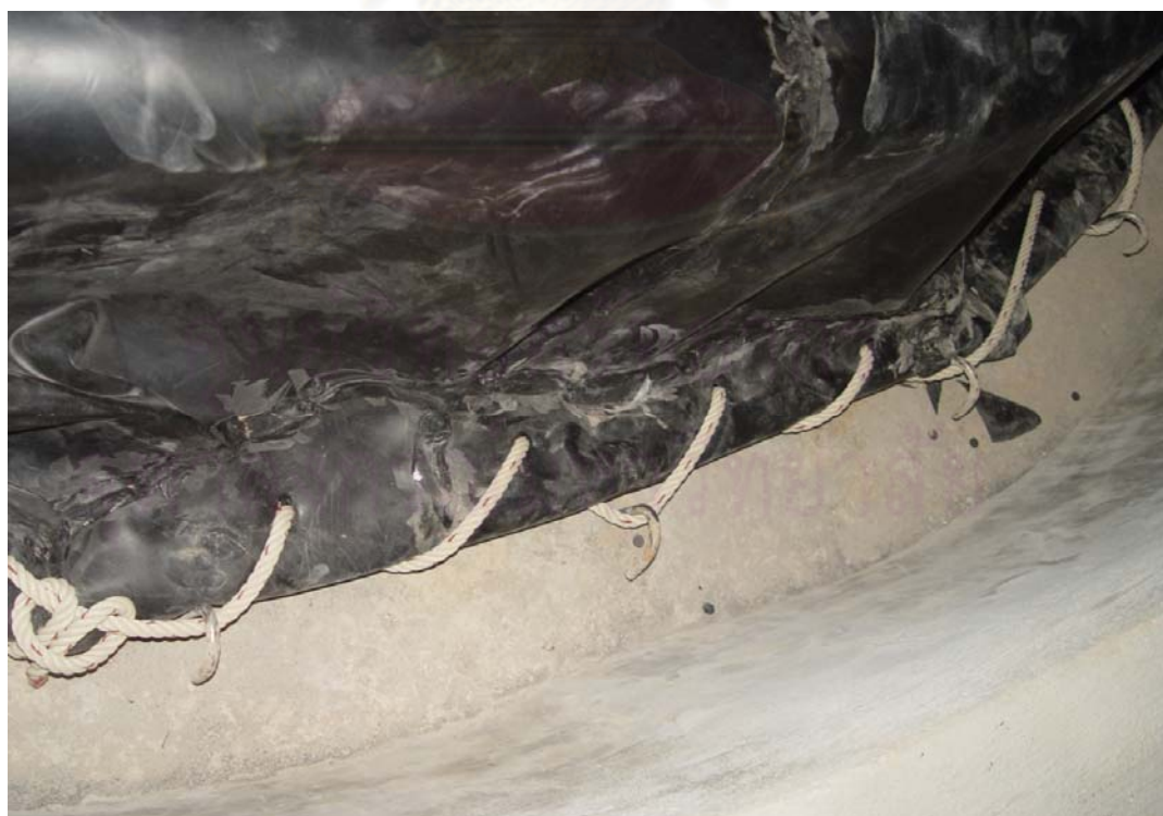
ภาพที่ 4-8 แสดงการคล้อง HDPE เข้ากับตะขอ
