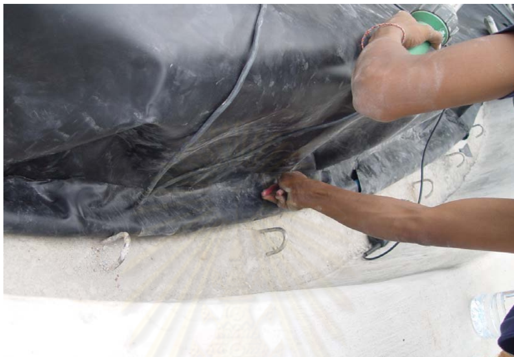
ภาพที่ 4-7 แสดงการพับขอบ HDPE โดยการใส่ท่อ PVC ด้านในและพับ HDPE ออก
