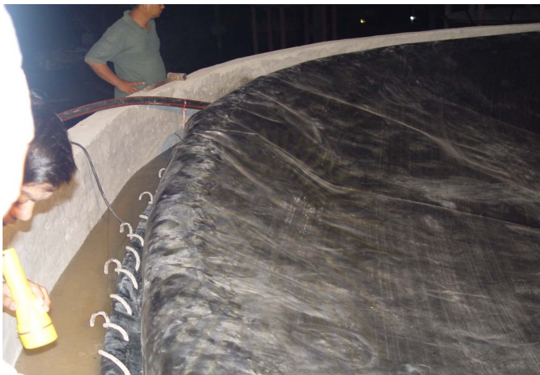
ภาพที่ 4-9 แสดงการเติมน้ำในรางน้ำ ทดสอบการรั่ว
