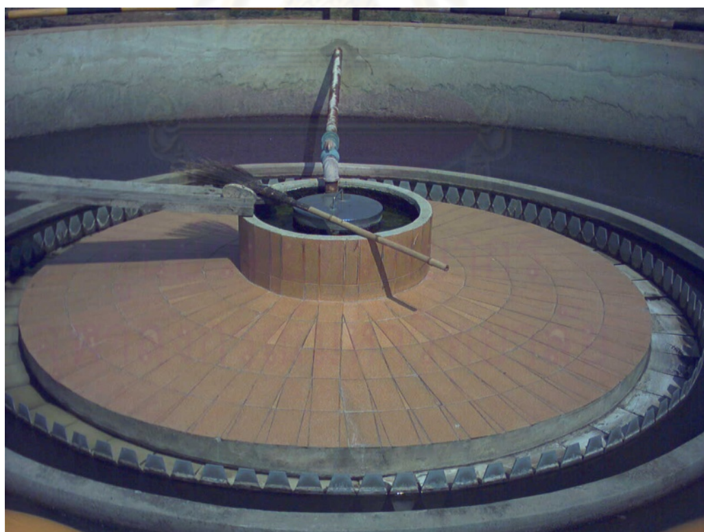
ภาพที่ 2-40 ถังหมักแบบ UASB (Up-flow Anaerobic Sludge Blanket)
