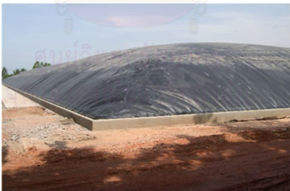
ภาพที่ 2-27 แสดงรูปแบบ Plug flow digester (Biogas Australia Pty Ltd, 2011)
