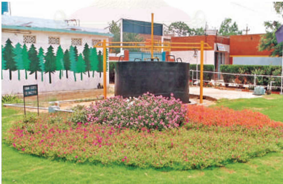
ภาพที่ 2-23 แทงค์ผลิตก๊าซชีวภาพและที่เก็บก๊าซ
