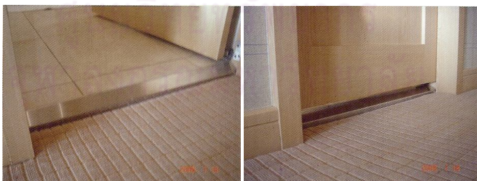
ภาพที่ 2.6 (ซ้าย) แสดงตัวอย่างกรณีประตูห้องน้ำที่มีความสูงเพียง 13 มิลลิเมตร เพื่อป้องกันการสะดุดล้ม
