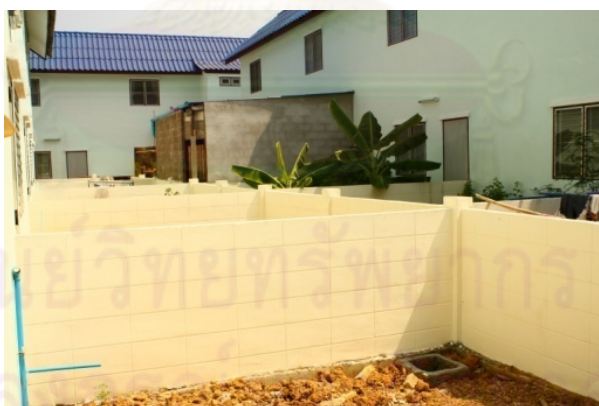
รูปที่ 5.6 แสดงห้องครัวแบบเดิม
