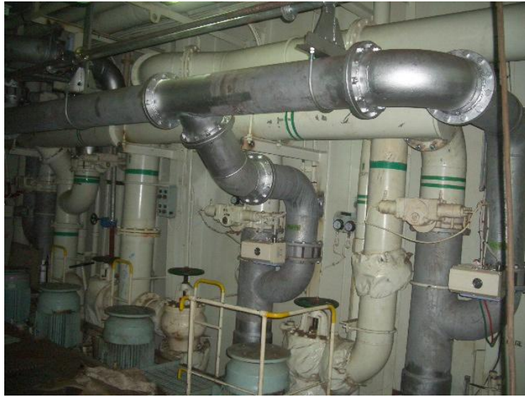
รูปที่ 48 ท่อน้ำทะเลใหม่ที่ติดตั้งเข้ากับระบบน้ำอับเฉาเรือของเดิม ที่มา: คู่ต่อเรือ K
