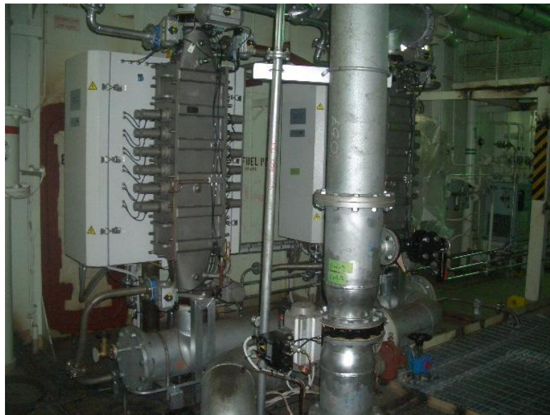
รูปที่ 49 ชุดอุปกรณ์ควบคุมในระบบบำบัดน้ำอับเฉา ที่มา: คู่ต่อเรือ K
