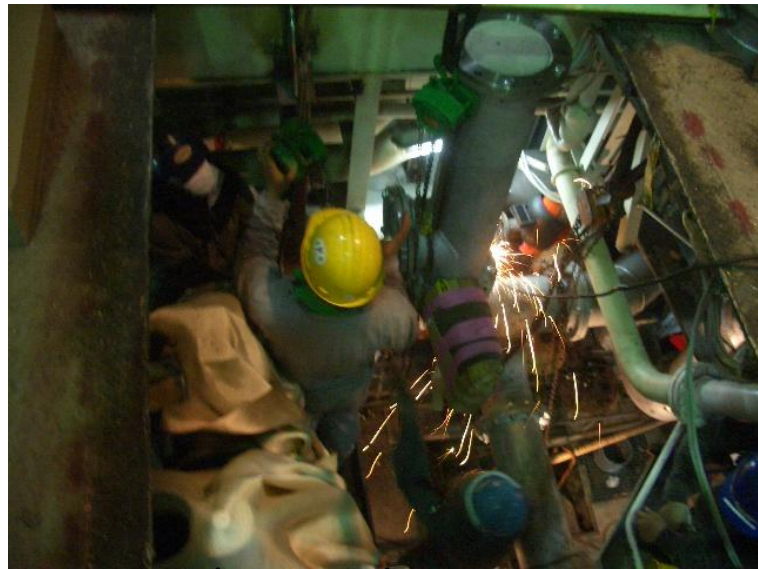
รูปที่ 47 ขั้นตอนการติดตั้งท่อทางในเรือ ที่มา: คู่ต่อเรือ K
