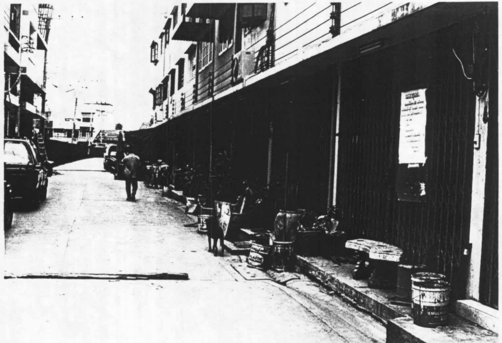
ภาพที่ 13, 14 แสดงภาพถ่ายลักษณะที่อยู่อาศัย 3 ชั้น (ZONE A)
