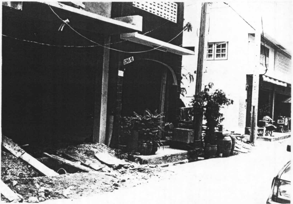
ภาพที่ 32, 33 แสดงภาพถ่ายที่อยู่อาศัยระหว่างการก่อสร้าง
