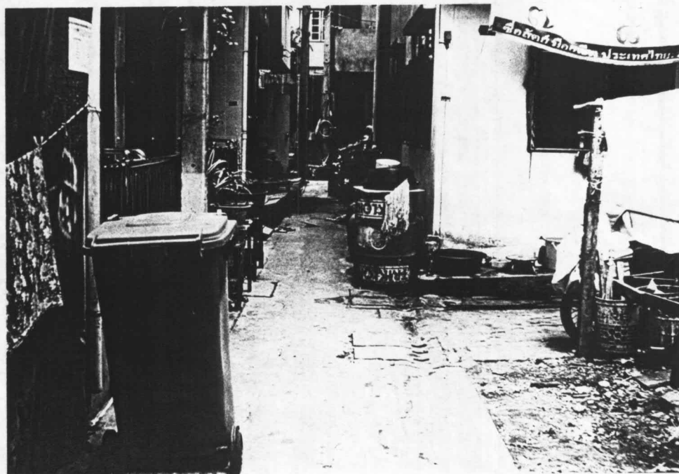
ภาพที่ 26 แสดงภาพถ่ายถนน และรางระบายน้ำ (ZONE D)
