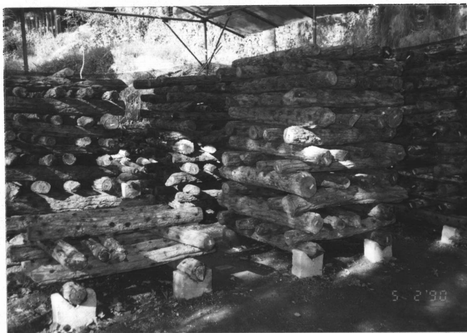
ภาพที่ 2.4 แสดงการวางไม้แบบหมอนรถไฟ
