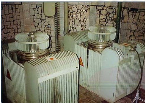
รูปที่ 2.4 เทอร์โมอิเล็กทริกเจเนอเรเตอร์ใช้ความร้อนจากไอโซโทปรังสี
