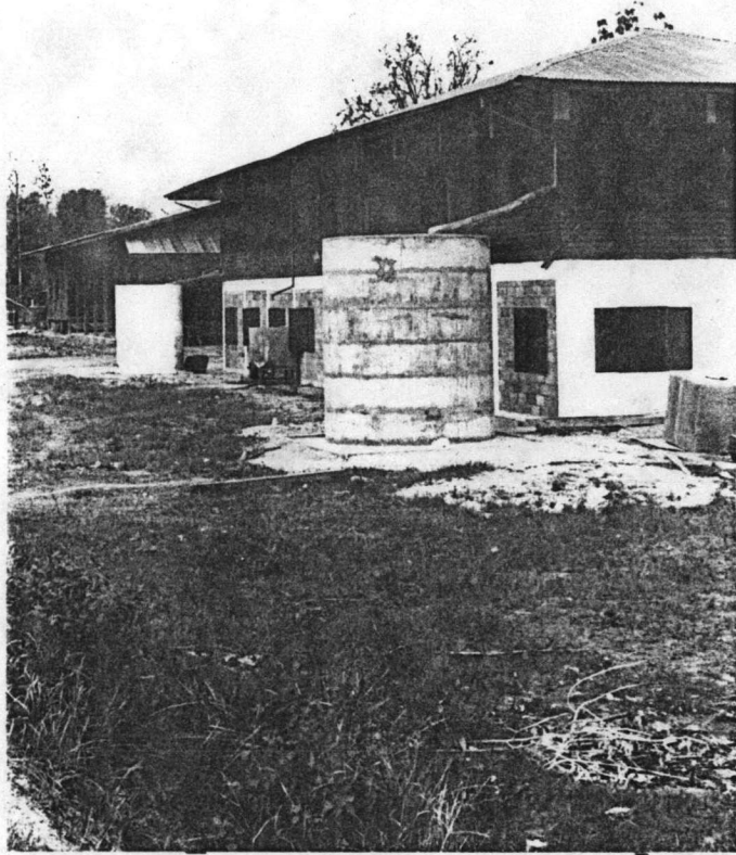
รูปที่ ๑-๓ ถังเก็บน้ำฝน ที่โรงเรียนบ้านเลื้อเต็น
