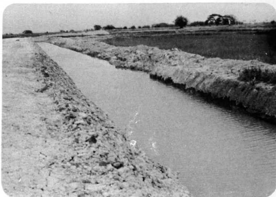
รูปที่ 6-8 แสดงตัวอย่างคลองโครงการสร้างงานในชนบท (2524) อ. เมือง จ.นครปฐม
