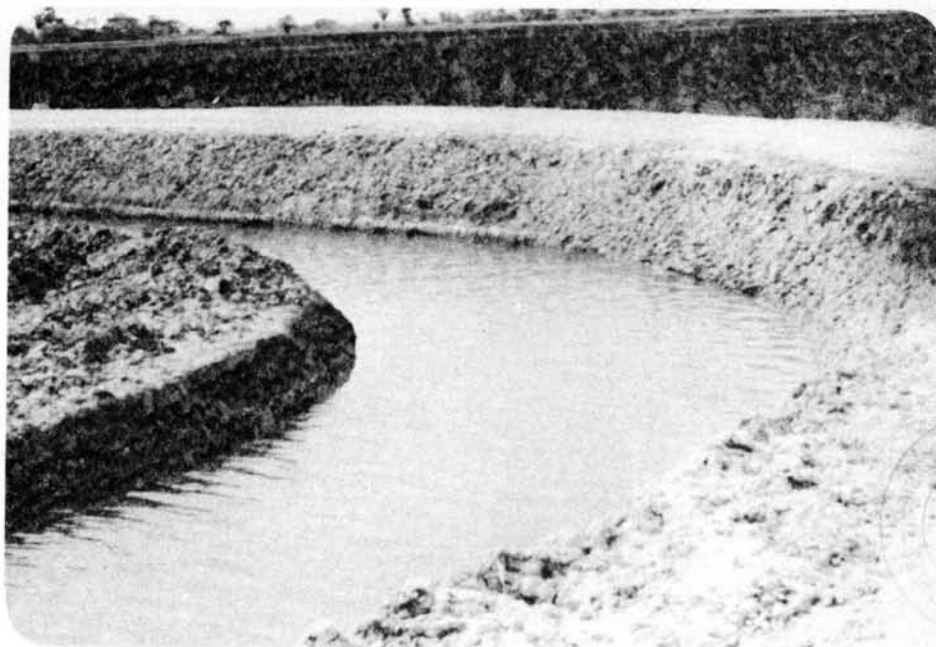
รูปที่ 6-1 แสดงตัวอย่างคลองโครงการสร้างงานในชนบท (2524) อ. เมือง จ. นครปฐม
