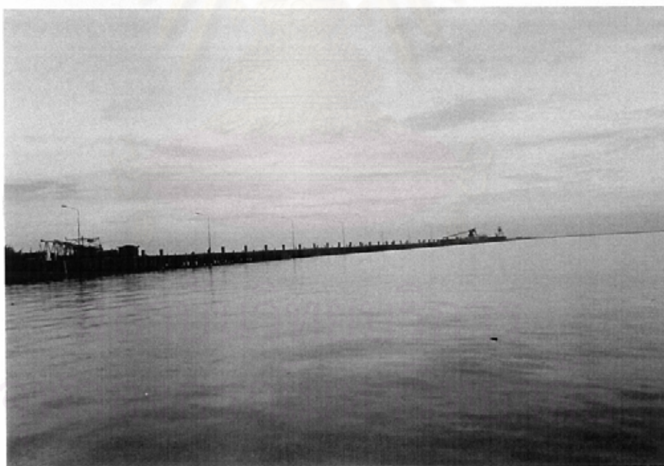
รูปที่ 4. บริเวณท่าเทียบเรือประมงที่สร้างใหม่ และยื่นลงไปในอ่าวปัตตานี ซึ่งอาจมีผลต่อระบบการหมุนเวียนกระแสน้ำในอ่าวปัตตานี และเกิดการพังทลายของชายฝั่งในอนาคต
