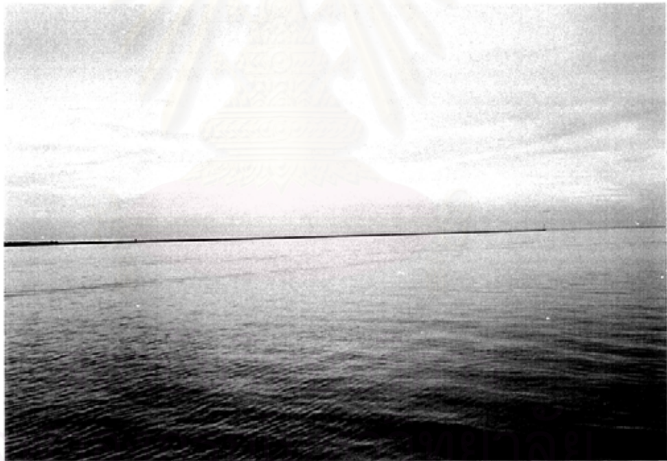
รูปที่ 6. คั่นทำนบกั้นดินโคลนที่ได้จากการขุดลอกร่องน้ำปัตตานี แล้วถมยื่นออกไปในทะเลบริเวณปากอ่าว มีความยาวประมาณ 800 เมตร ซึ่งส่งผลทำให้น้ำในอ่าวปัตตานี มีการถ่ายเทกับน้ำภายนอกได้น้อย เพราะช่องเปิดบริเวณปากอ่าวแคบลง
