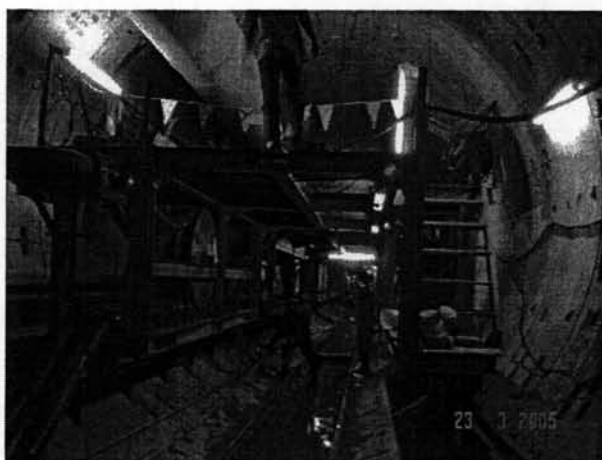
รูปที่ 4.8 ระบบชุดอุปกรณ์ที่ช่วยสนับสนุนในการขุดเจาะ (Back up Systems) (โครงการก่อสร้างอุโมงค์ระบายน้ำคลองลาดพร้าวฯ)
