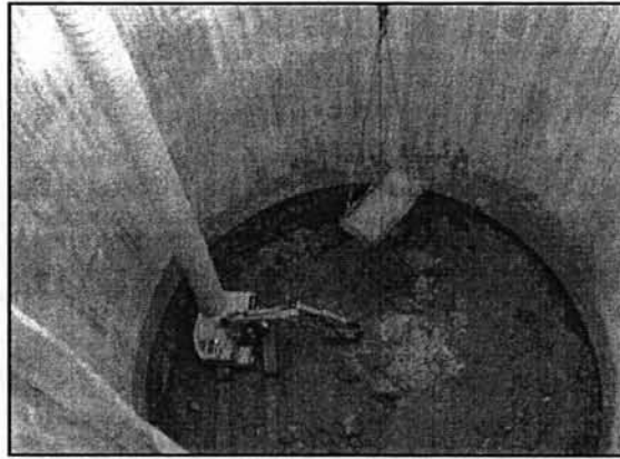
รูปที่ 4.17 การควบคุมการขุดดินภายในปล่องต้องไม่ทำในลักษณะ Over cut (มานิต ปานเอม, 2549)
