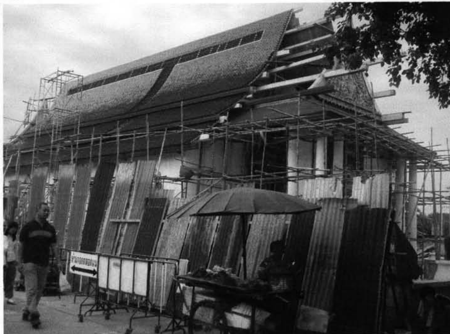
รูปที่ 4.7 พระอุโบสถที่ปัจจุบันกำลังบูรณะโดยกรมศิลปฯ
