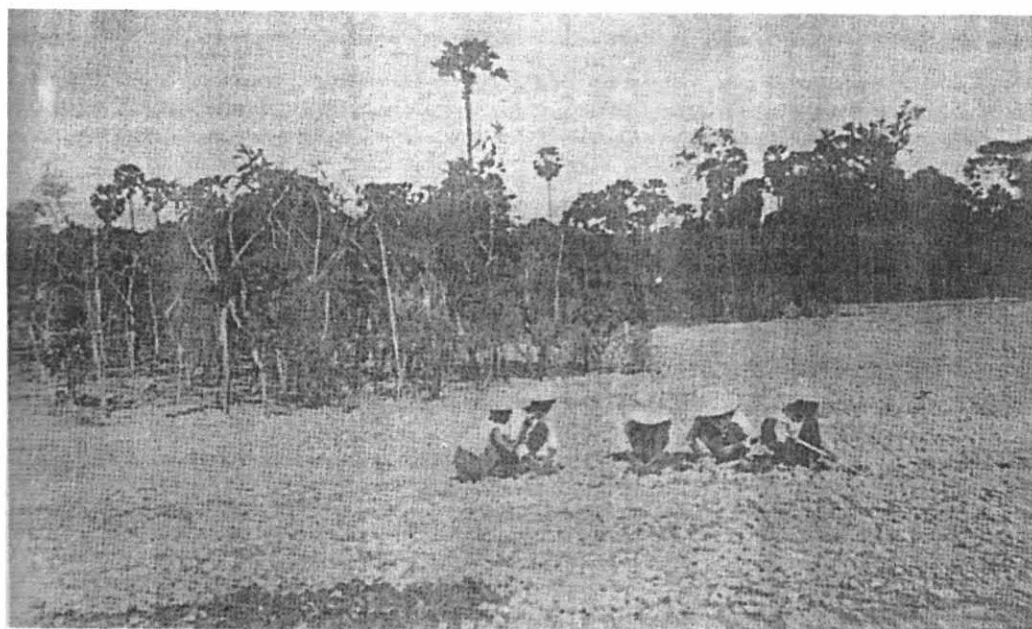
รูปภาพ 7 - 234 คนงานกำลังปรับแต่งพื้นที่เตรียมการก่อสร้างพระราชวังบ้านป็น
