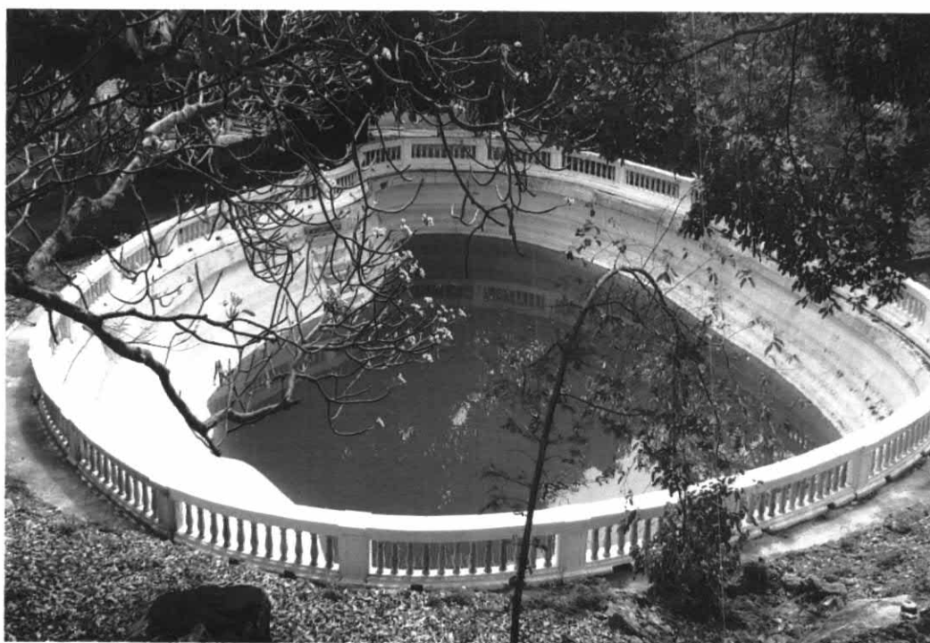
รูปภาพ 7 - 218 สระมหานอนดาตสระเก็บน้ำขนาดใหญ่ก่อด้วยอิฐกรุด้วยลูกกระเบียงโดยรอบ
