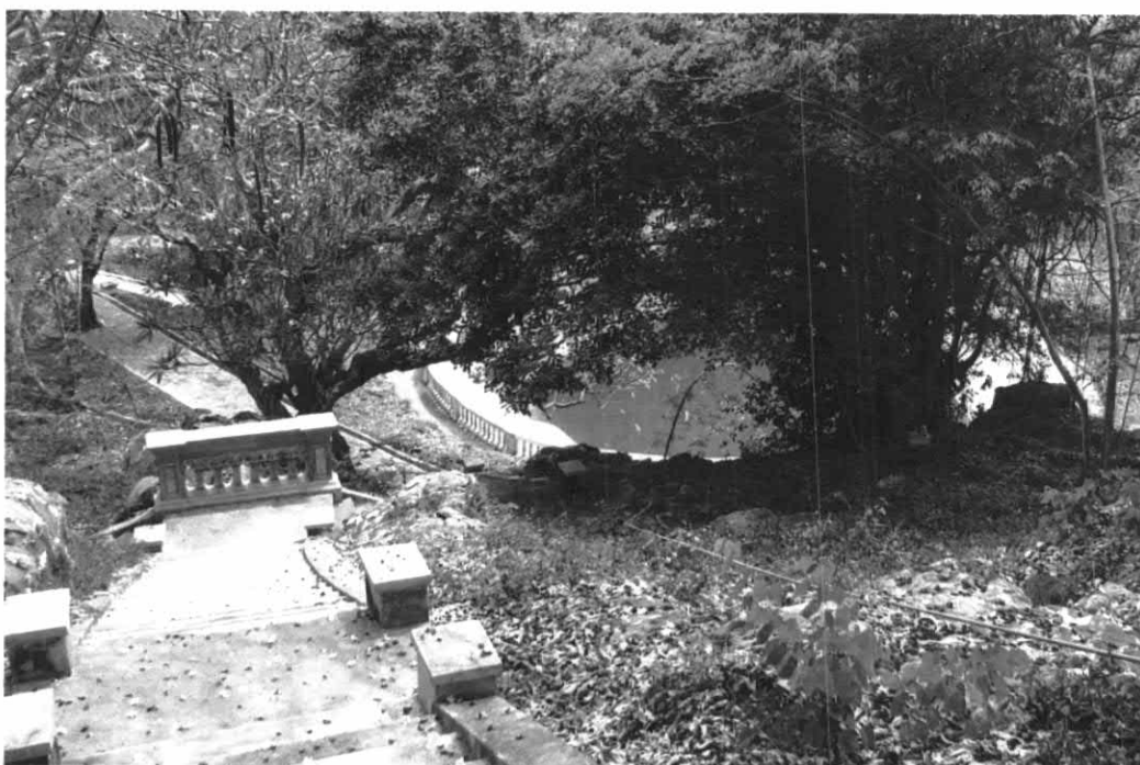
รูปภาพ 7 - 215 เส้นทางสัญจรอาศัยบันไดช่วยเนื่องจากสภาพที่สูงชัน
